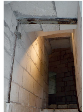
Figure 1 – Tirants métalliques existants (fin XIXème) sous le sol des salles intermédiaire et haute
