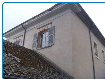
Couverture côté Ouest dégradée PRLV n° r51L31AD13 sur Couverture Ardoise amiante ciment
