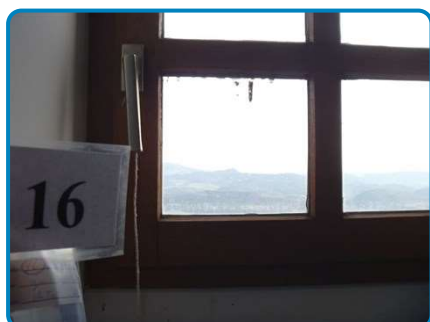
PRLV n° 16 sur Lucarne de toit Mastic de vitrage coulant gris
