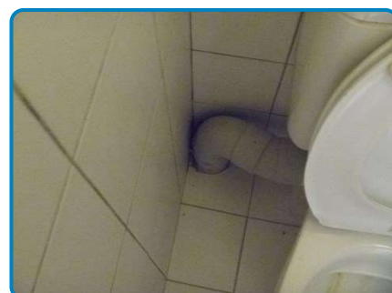
Conduit PVC d'évacuation des eaux vannes
