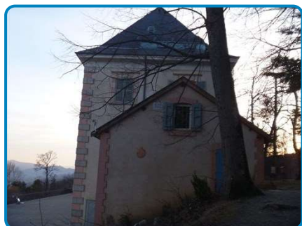
Couverture ardoise amiante ciment sur logement gardien
