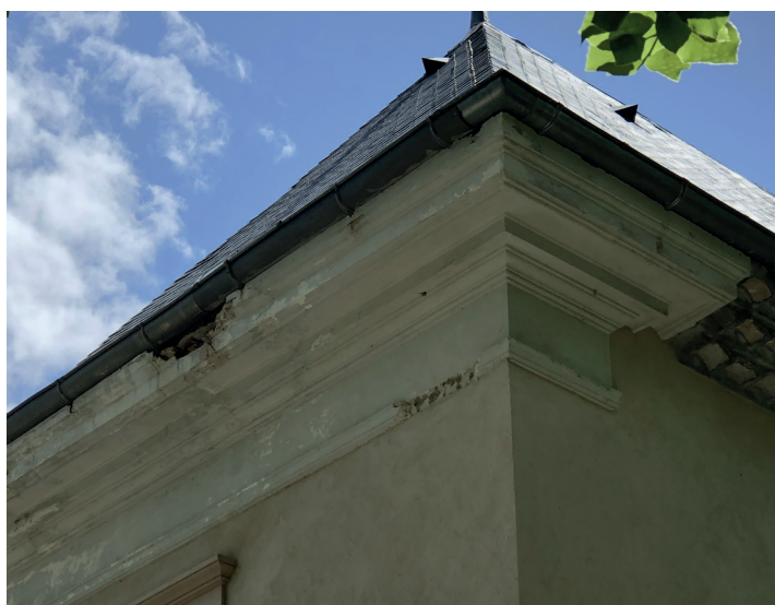
Corniche angle nord-est - perte de matière suite infiltrations d'eau
