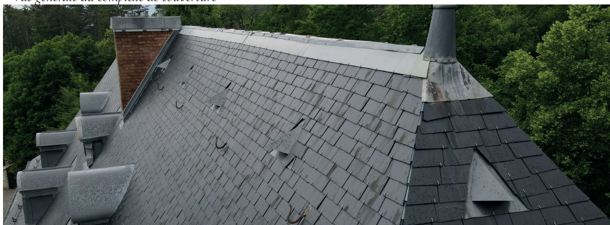
Altération au niveau du faîtage
