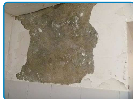
Enduit de ciment + plâtre sur mur
