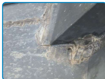
Soudure entre plaques de zinc
