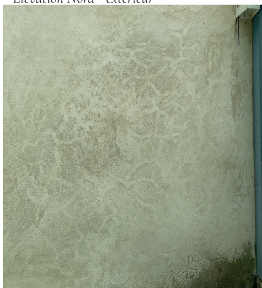
Élévation Nord - faïençage
