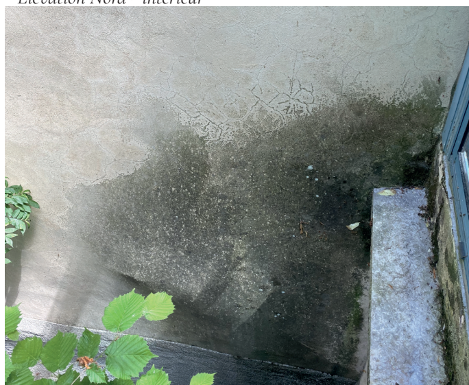
Élévation Nord - altération chromatique avec gonflement
