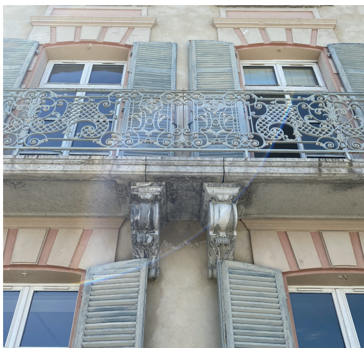
Altération chromatique, lessivage des joints et fissurations
