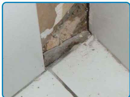
Sondage dans les sanitaires hommes: bande périphérique mousse sous chape
