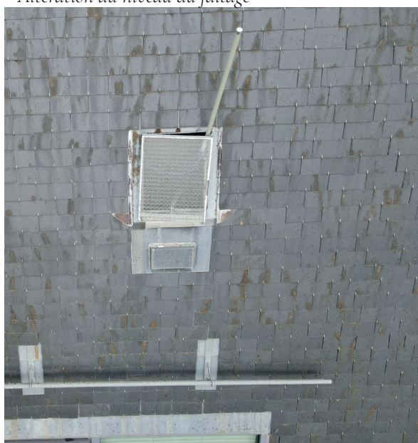
Dégradation des abergements de la tabatière
