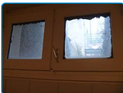
Menuiserie avec mastic coulant
