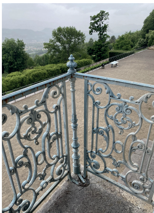
Fissurations au droit des scellements
