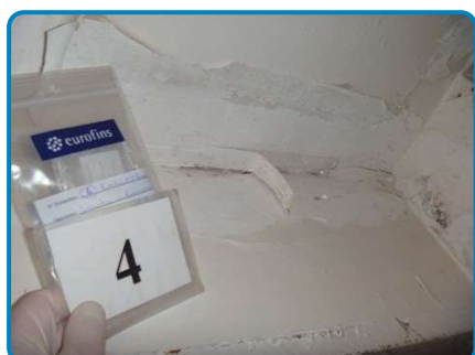
PRLV n° 4 sur Mur Enduit à bande
