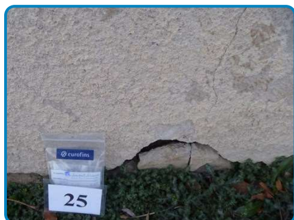
PRLV n° 25 sur Sous bassement Enduit de façade
