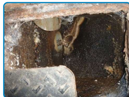
Sondage dans les sanitaires femmes: canalisation PVC dans le regard
