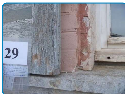
PRLV n° 29 sur Décor brique encadrement de fenêtre Plâtre
