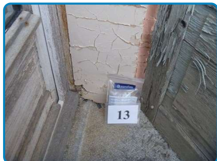
PRLV n° 13 sur Tableau de porte-fenêtre Plâtre
