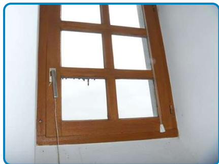
Menuiserie côté Sud avec mastic coulant gris
