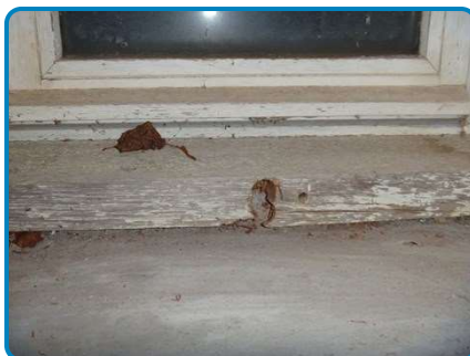
Sondage extérieur sous fenêtre des sanitaires hommes - Absence d'étanchéité accessible sur rejingot
