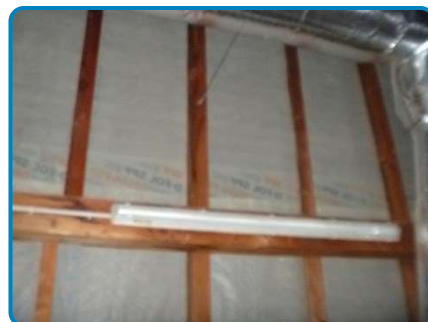
Comble Ouest: Film sous couverture
