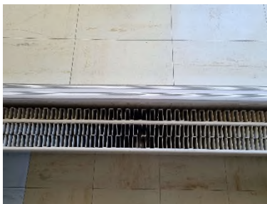
Radiateur plinthe à supprimer
