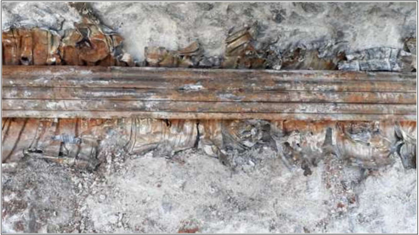
Enrouillement généralisé des câbles
