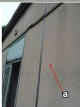
Photo n° A022 Localisation : LOG GARDIEN + ATELIER - PARTIES EXTERIEURES Ouvrage : 2. Parois verticales extérieures - Bardages Partie d'ouvrage : Cloison plaque fibres-ciment Description : Cloison plaque fibre-ciment Localisation sur croquis : P50
