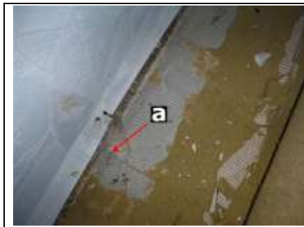
Photo n° A001 Localisation : RDC / LOGEMENT - CHAMBRE 2 Ouvrage : 5. Planchers et planchers techniques - Planchers Partie d'ouvrage : Ragréage + colle noire Description : Ragréage + colle noire Localisation sur croquis : P3
