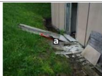
Photo n° A021 Localisation : LOG GARDIEN + ATELIER - PARTIES EXTERIEURES Ouvrage : 11. Elements hors liste - Divers absent de la liste Partie d'ouvrage : Dépôt plaques fibres-ciment Description : Dépôts plaques fibres-ciment Localisation sur croquis : P49
