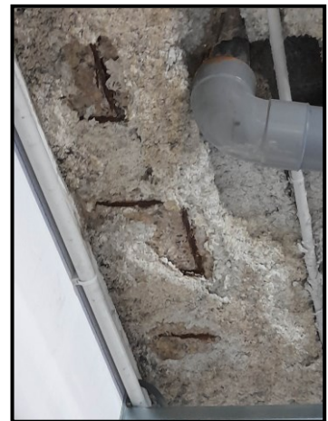
Béton dégradé et armatures apparentes
