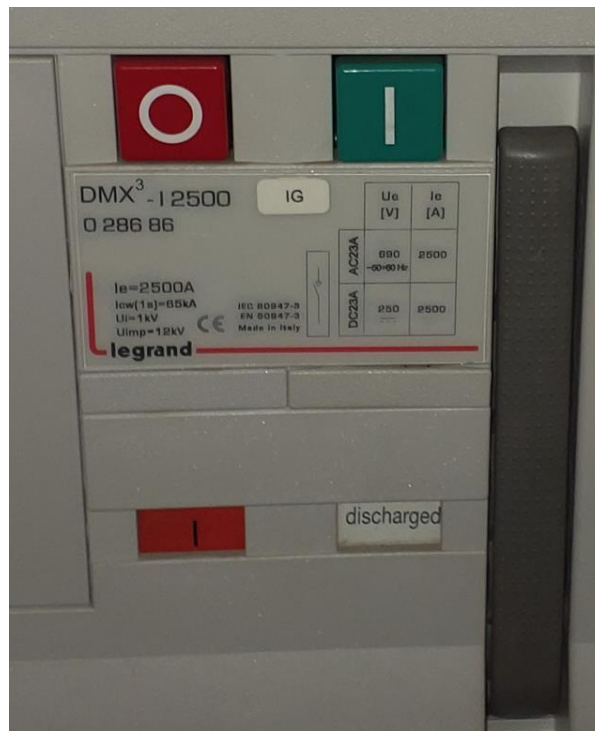
Figure 2 : Le disjoncteur général BT du site.
