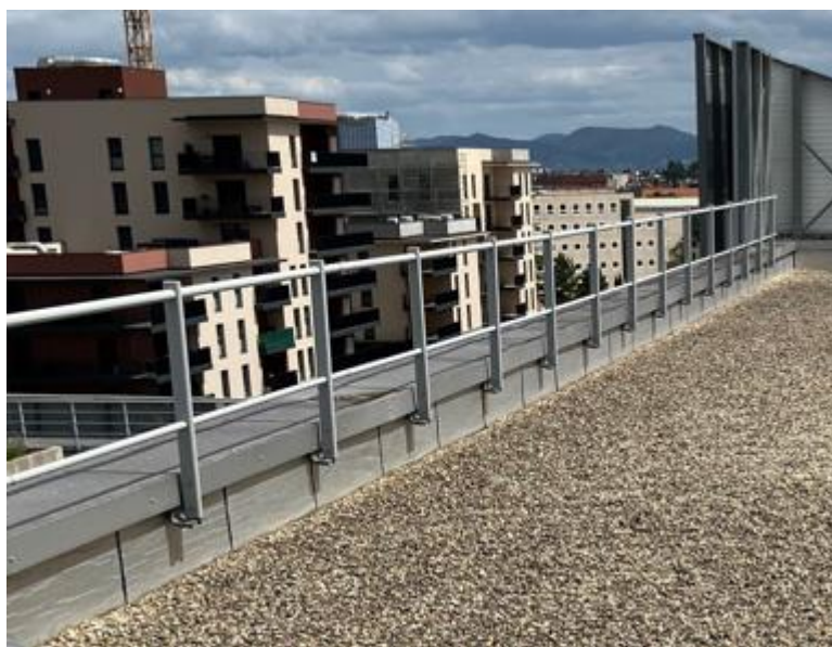
La toiture est Sécurisée par garde-corps
