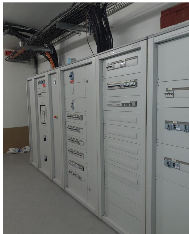
Figure 3 : Armoires électrique du TGBT
