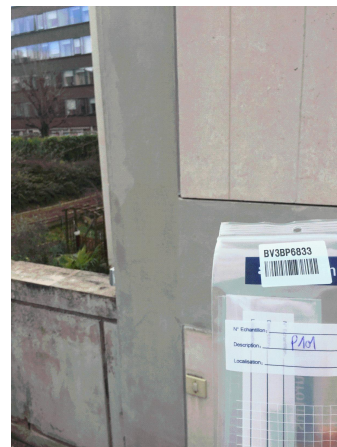
Prélèvement - P101 : FACADES - Enduit lissé- (Présence d'amiante)
