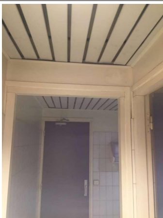
Prélèvement - P109 : BATIMENT 1 / ETAGE1 / Toilettes 1 - Enduit- (Absence d'amiante)
