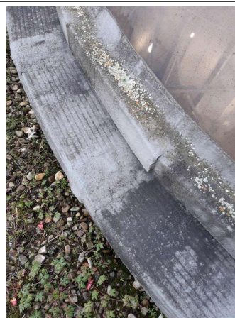
Prélèvement - P018 : Cour d'appel / Toiture salle d'audience / Dôme - Revêtement d'étanchéité- (Absence d'amiante)
