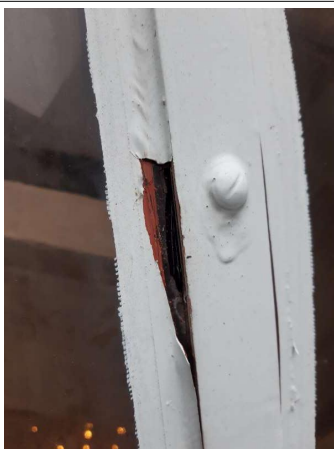
Prélèvement - P013 : Cour d'appel / Toiture R+1 / Dôme - Mastic- (Absence d'amiante)
