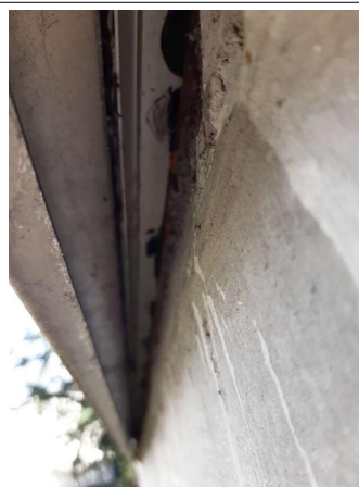
Prélèvement - P056 : Cour d'appel / Façades Nord - Joint- (Absence d'amiante)
