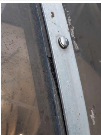
Prélèvement - P021 : Cour d'appel / Toiture salle d'audience / Dôme - Joint- (Absence d'amiante)
