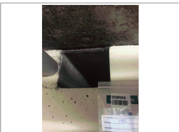
Prélèvement - P083 : BATIMENT 1 / SOUS SOL 2 / Local -204 - Conduit- (Présence d'amiante)
