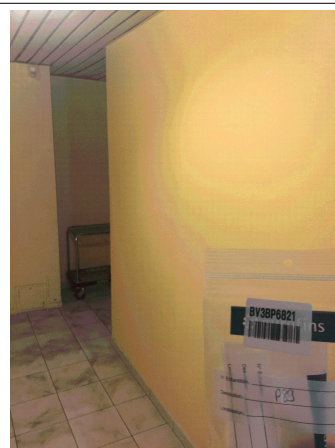
Prélèvement - P089 : BATIMENT 1 / SOUS SOL 1 / Local -122 - Enduit- (Présence d'amiante)
