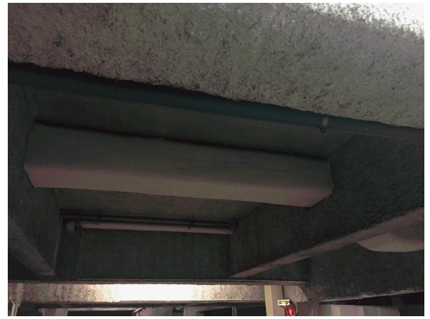
Prélèvement - P097 : BATIMENT 1 / SOUS SOL 1 / Local -115 - Flocage- (Absence d'amiante)
