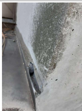
Prélèvement - P060 : Cour d'appel / Façades Est - Joint- (Absence d'amiante)
