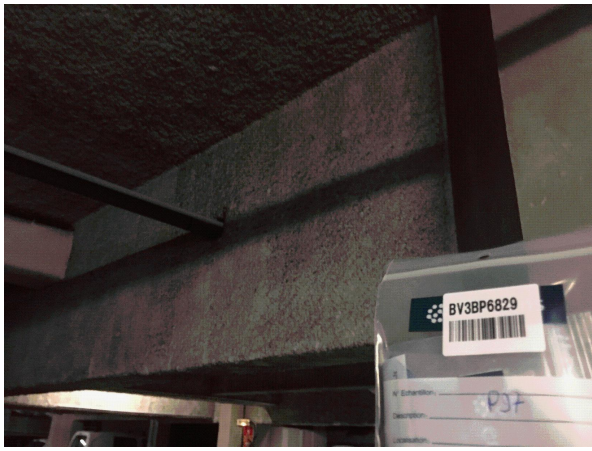
Prélèvement - P097 : BATIMENT 1 / SOUS SOL 1 / Local -115 - Flocage- (Absence d'amiante)
