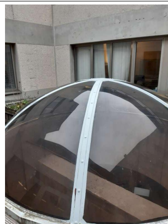
Prélèvement - P012 : Cour d'appel / Toiture R+1 / Dôme - Peinture- (Absence d'amiante)
