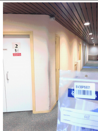
Prélèvement - P068 : BATIMENT 1 / ETAGE2 / Circulation - Enduit- (Présence d'amiante)
