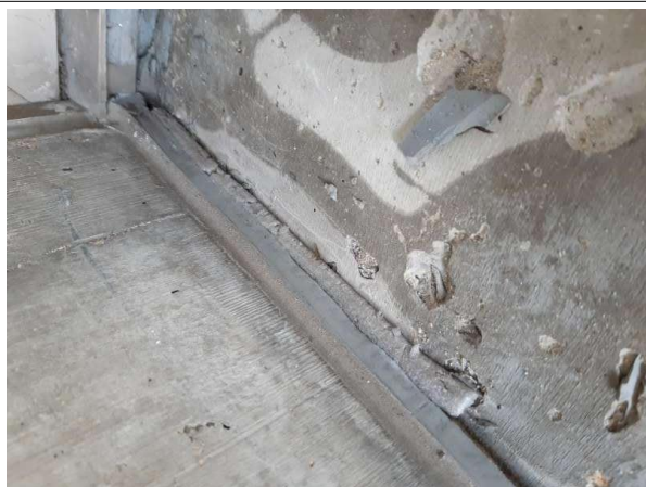
Prélèvement - P051 : Cour d'appel / Façades Est - Joint- (Absence d'amiante)
