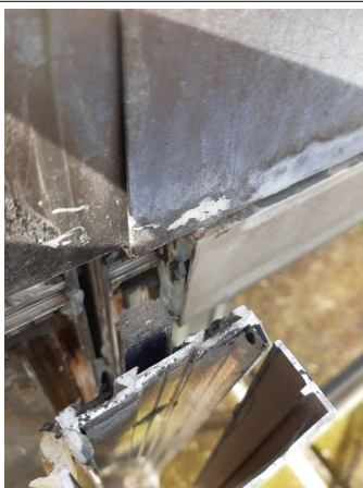
Prélèvement - P041 : Cour d'appel / Façades Est - Joint- (Absence d'amiante)
