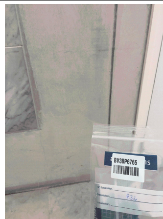
Prélèvement - P032 : BATIMENT 1 / RDC / Local 12 - Enduit lissé- (Présence d'amiante)
