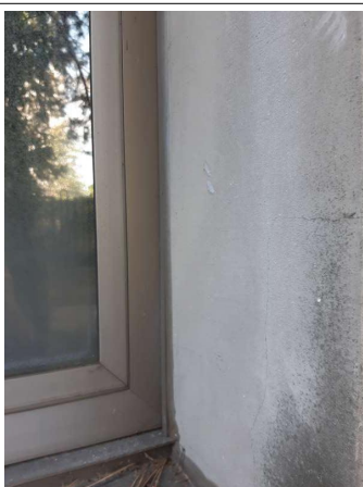
Prélèvement - P059 : Cour d'appel / Façades Est - Joint- (Absence d'amiante)
