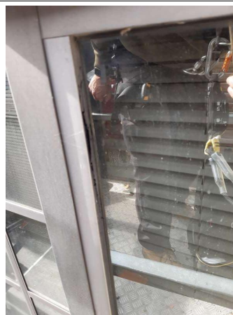
Prélèvement - P046 : Cour d'appel / Façades Est - Joint- (Absence d'amiante)
