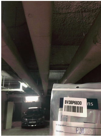
Prélèvement - P098 : BATIMENT 1 / SOUS SOL 1 / Local -115 - Calorifugeage- (Absence d'amiante)
