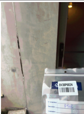
Prélèvement - P102 : FACADES - Joint de dilatation- (Absence d'amiante)
