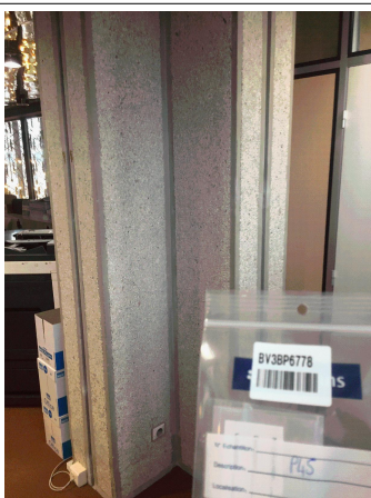
Prélèvement - P045 : BATIMENT 1 / MEZZANINE / Local 002 - Enduit lissé- (Présence d'amiante)
