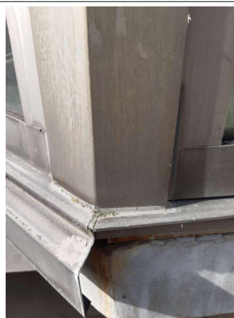
Prélèvement - P044 : Cour d'appel / Façades Est - Joint- (Absence d'amiante)
