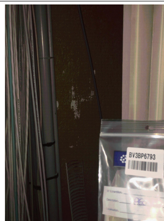
Prélèvement - P060 : BATIMENT 1 / PLATE FORME / Escalier 2 - Enduit projeté- (Absence d'amiante)
