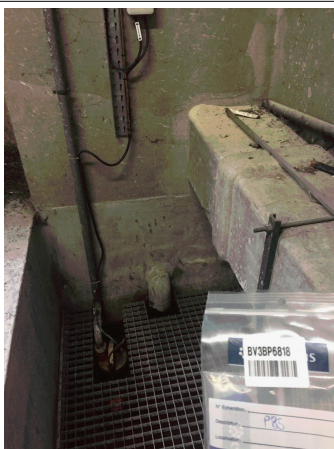
Prélèvement - P085 : BATIMENT 1 / SOUS SOL 2 / Local -201 - Conduit- (Présence d'amiante)
