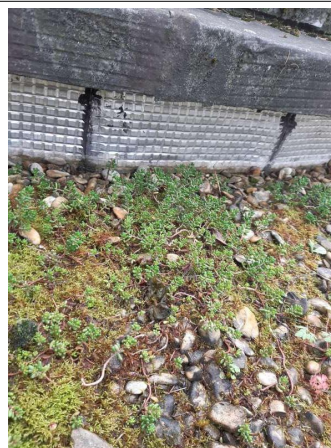
Prélèvement - P016 : Cour d'appel / Toiture salle d'audience / Dôme - Bardeau bitumineux- (Absence d'amiante)
