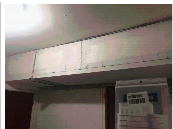
Prélèvement - P079 : BATIMENT 1 / SOUS SOL 2 / Local -208 - Enduit- (Absence d'amiante)
