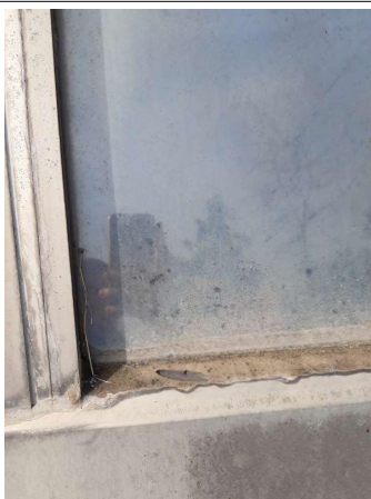
Prélèvement - P045 : Cour d'appel / Façades Est - Joint- (Absence d'amiante)
