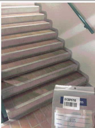
Prélèvement - P035 : BATIMENT 1 / RDC / Escalier 1 - Colle de carrelage- (Absence d'amiante)
