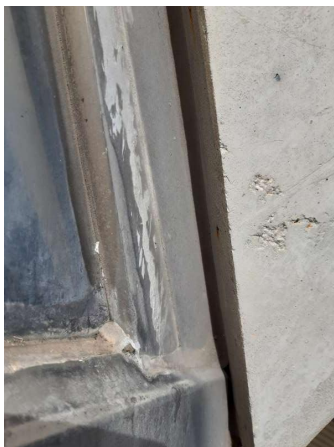
Prélèvement - P049 : Cour d'appel / Façades Est - Joint- (Absence d'amiante)
