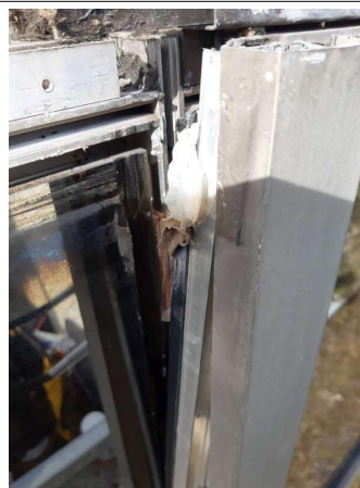
Prélèvement - P040 : Cour d'appel / Façades Est - Joint- (Absence d'amiante)
