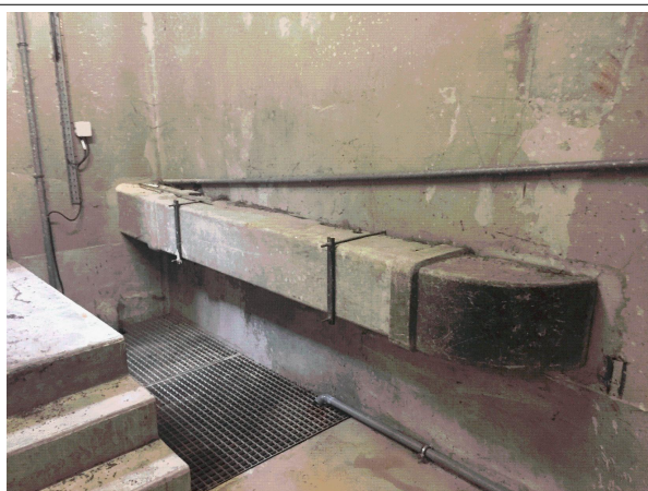
prélevé - idem P083 : BATIMENT 1 / SOUS SOL 2 / Local -201 - Conduit- (Présence d'amiante)
