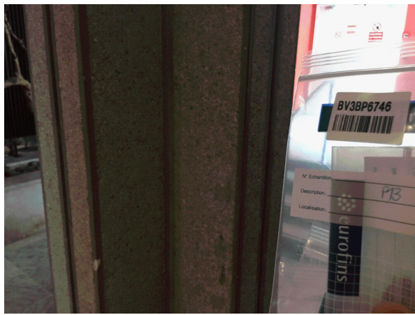
Prélèvement - P013 : BATIMENT 1 / RDC / Local 21 - Enduit lissé- (Présence d'amiante)
