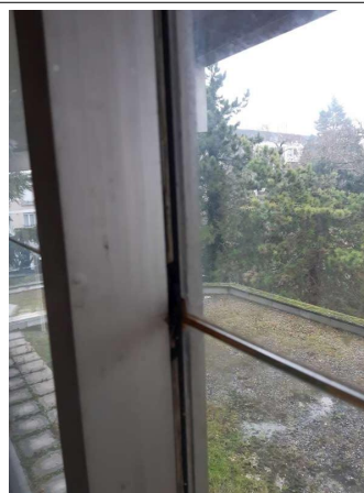
Prélèvement - P024 : Cour d'appel / RDC/R+1 / Mezzanine accueil - Joint- (Absence d'amiante)
