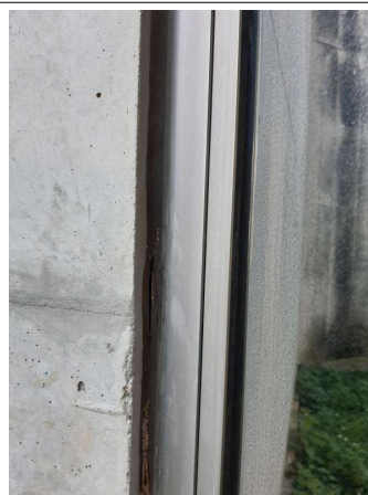
Prélèvement - P062 : Cour d'appel / Façades Est - Joint- (Absence d'amiante)
