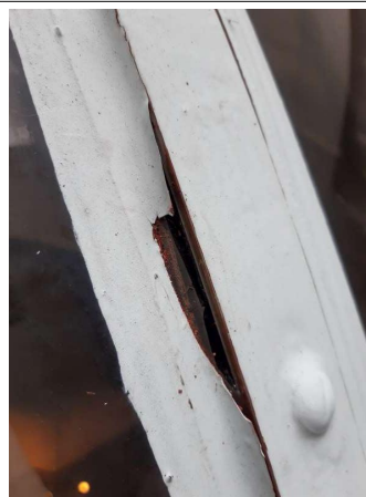
Prélèvement - P014 : Cour d'appel / Toiture R+1 / Dôme - Mastic- (Absence d'amiante)
