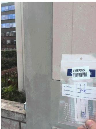
Prélèvement - P100 : FACADES - Joint- (Absence d'amiante)
