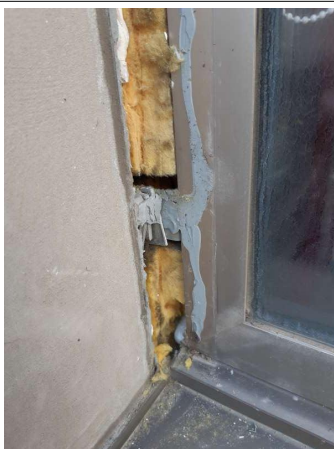
Prélèvement - P063 : Cour d'appel / Patio - Joint- (Absence d'amiante)
