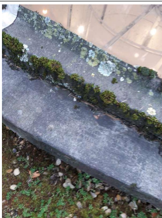
Prélèvement - P017 : Cour d'appel / Toiture salle d'audience / Dôme - Revêtement d'étanchéité- (Absence d'amiante)
