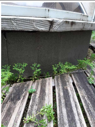
Prélèvement - P015 : Cour d'appel / Toiture R+1 / Dôme - Relevé d'étanchéité- (Absence d'amiante)
