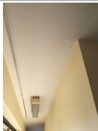
Prélèvement - P108 : BATIMENT 1 / ETAGE1 / Local 113 - Enduit- (Présence d'amiante)
