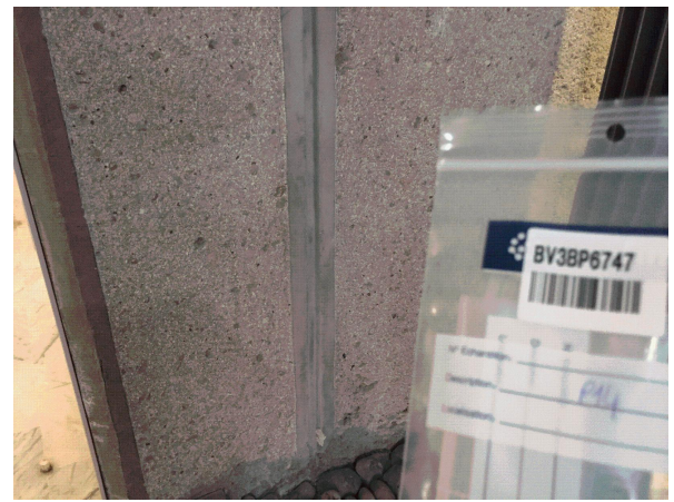
Prélèvement - P014 : BATIMENT 1 / RDC / Local 21 - Enduit lissé- (Présence d'amiante)
