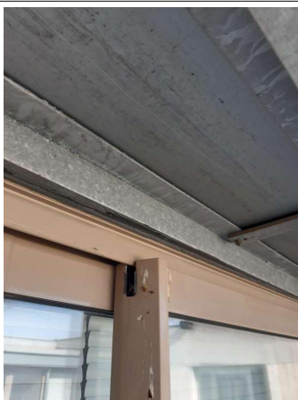
Prélèvement - P065 : Cour d'appel / Patio - Joint- (Absence d'amiante)
