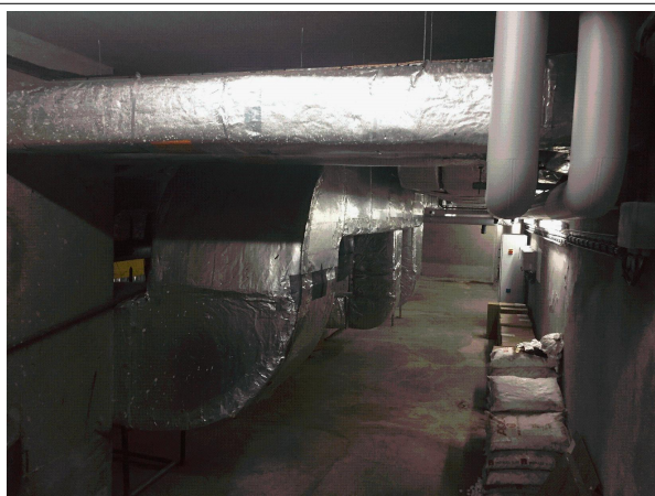
Déclaré - : BATIMENT 1 / SOUS SOL 2 / Local -201 - Calorifugeage- (Absence d'amiante)
