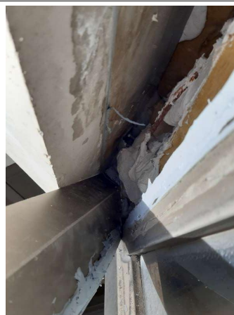
Prélèvement - P048 : Cour d'appel / Façades Est - Joint- (Présence d'amiante)
