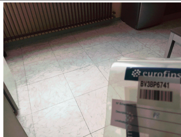
Prélèvement - P008 : BATIMENT 1 / RDC / Local 18 - Colle- (Absence d'amiante)
