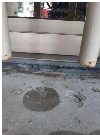
Prélèvement - P050 : Cour d'appel / Façades Est - Joint- (Absence d'amiante)
