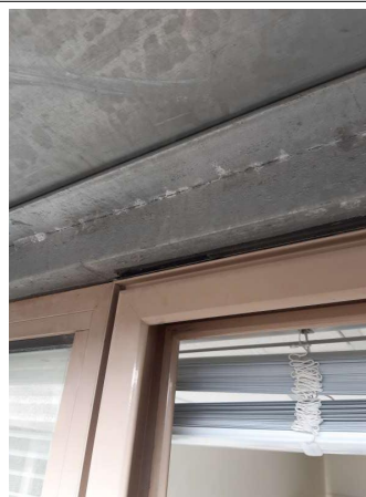
Prélèvement - P064 : Cour d'appel / Patio - Joint- (Absence d'amiante)
