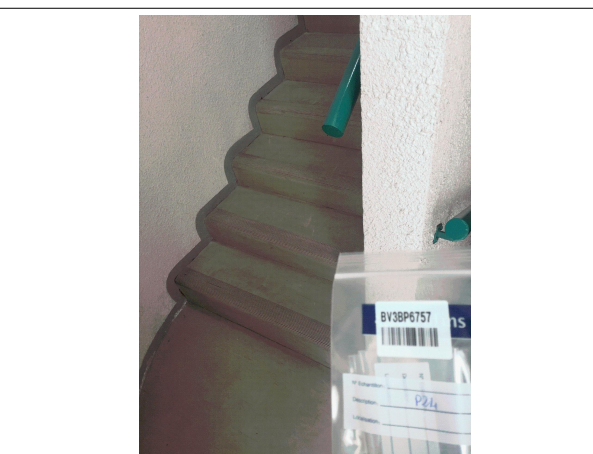
Prélèvement - P024 : BATIMENT 1 / RDC / Escalier 4 - Enduit lissé- (Présence d'amiante)
