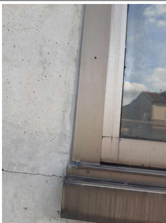
Prélèvement - P057 : Cour d'appel / Façades Nord - Joint- (Absence d'amiante)
