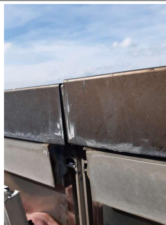
Prélèvement - P052 : Cour d'appel / Façades Sud - Joint- (Absence d'amiante)
