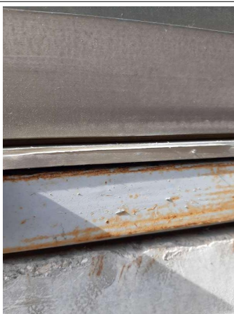
Prélèvement - P043 : Cour d'appel / Façades Est - Joint- (Absence d'amiante)
