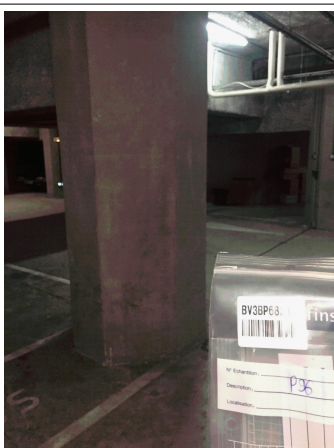
Prélèvement - P096 : BATIMENT 1 / SOUS SOL 1 / Local -115 - Enduit lissé- (Présence d'amiante)
