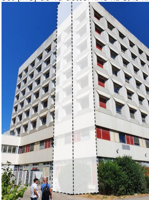
Implantation MC et escalier accès niveaux 7 et toiture de la Tour A
