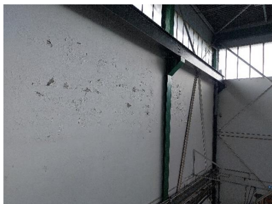
Humidité des murs, microfissurations
