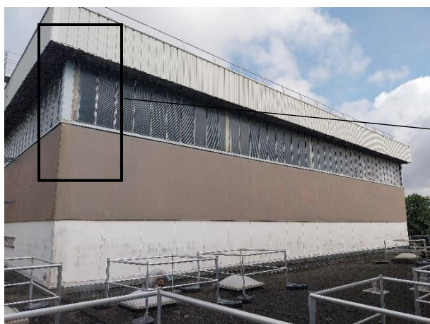
Hall 1 : membrures poteaux côté façade corrodées
