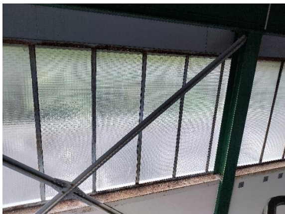
Hall 1 et 2 : corrosion des lisses
