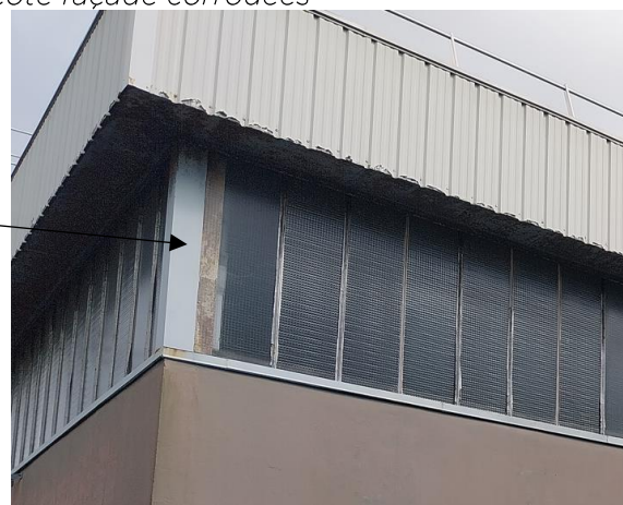
Hall 1 : membrures poteaux côté façade corrodées
