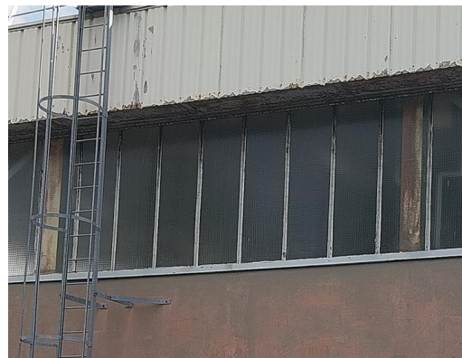
Hall 2 : membrures poteaux côté façade corrodées
