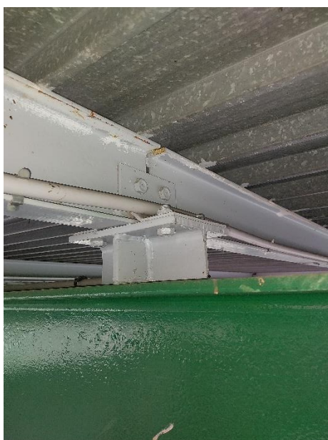
Hall 1 et 2 : Corrosion de surface sur éléments de charpente
