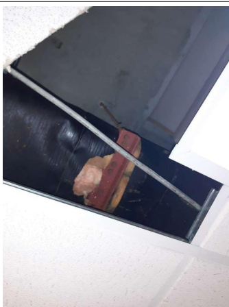
Prélèvement - P017 : RDC / 221.00.01 CIRCULATION - Calorifugeage- (Absence d'amiante)
