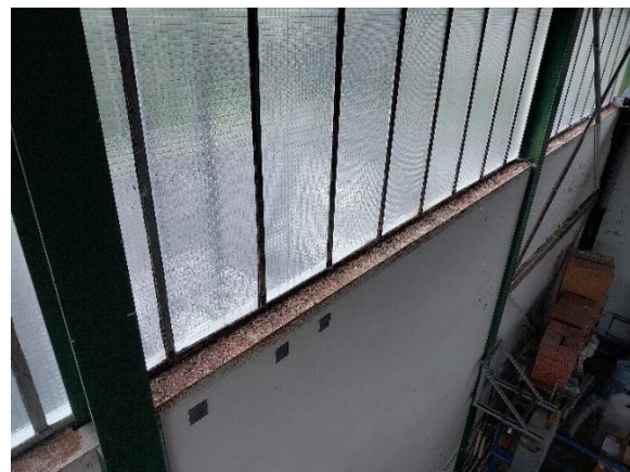
Hall 1 et 2 : corrosion des lisses
