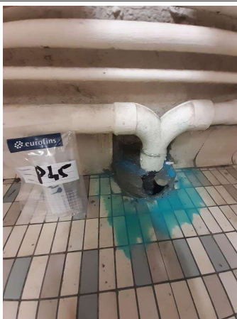
Prélèvement - P045 : RDC / 221.00.23 - Fourreau- (Présence d'amiante)
