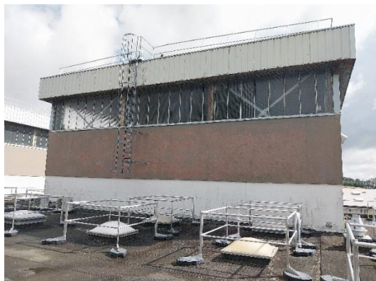
Hall 2 : membrures poteaux côté façade corrodées
