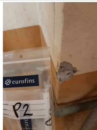
Prélèvement - P002 : RDC / 221.00.47 - Enduit- (Absence d'amiante)
