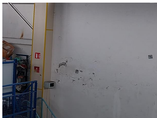
Humidité des murs, microfissurations
