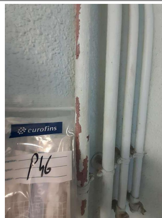
Prélèvement - P046 : RDC / 221.00.00 CIRCULATION - Peinture- (Absence d'amiante)
