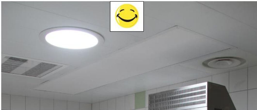
Mise en place respectant le PMS – Plafond tôle fixe solatube pour la lumière, bouche de ventilation Lumière encastrée et chauffage en plaque encastrée au plafond.
