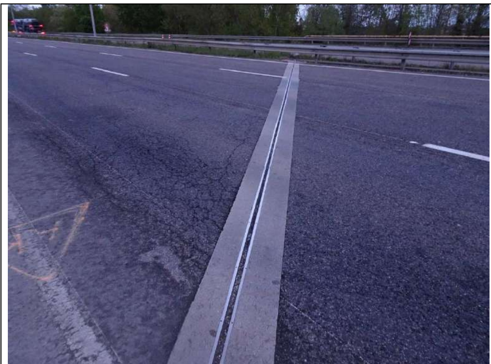
7 : Joint de chaussée côté Metz
