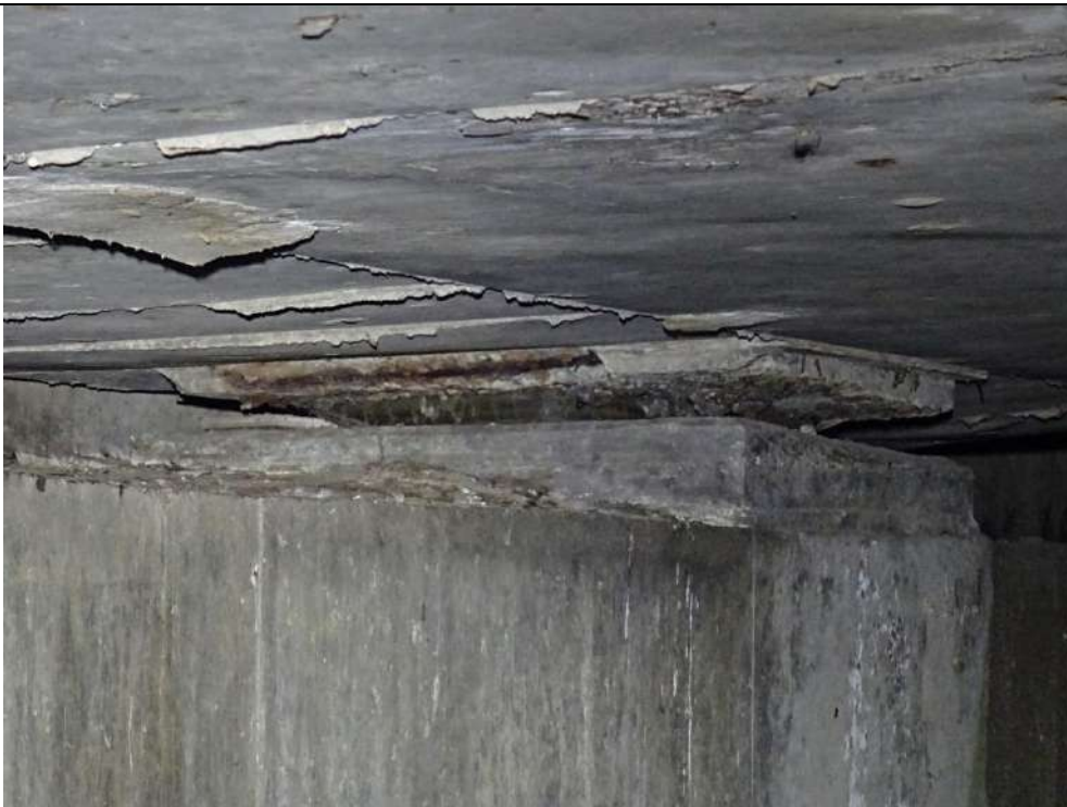
1008 : Appareil d'appui aval sur la culée C0 rive gauche
