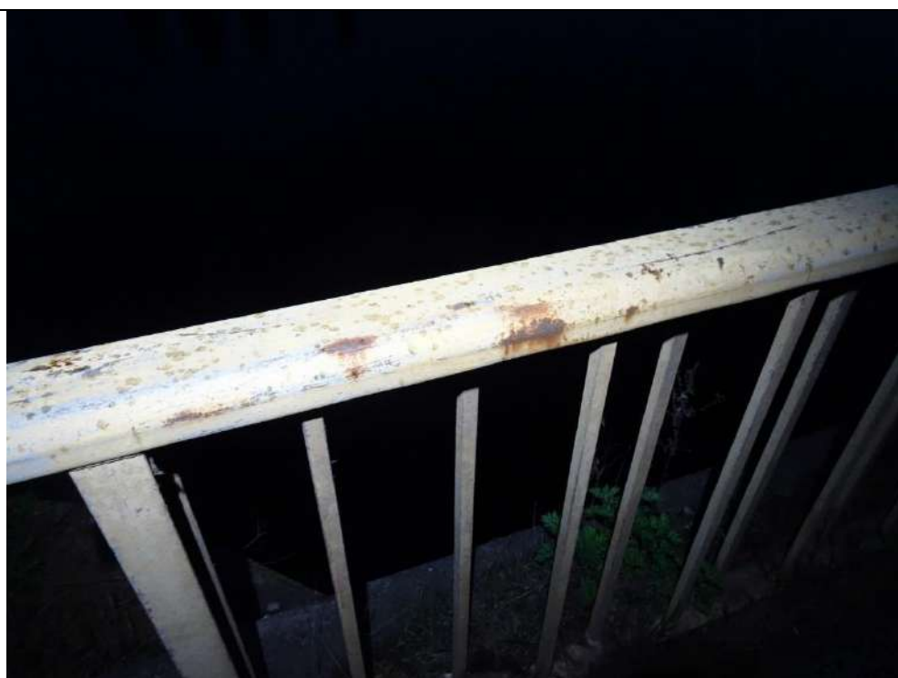
16 : Corrosion éparse sur les lisses supérieures des garde-corps du trottoir amont
