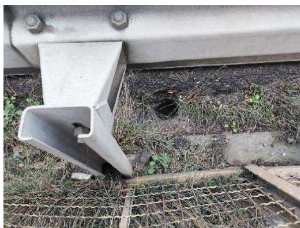
Figure 8 : Descente d'eau au niveau de la rive de la chaussée
