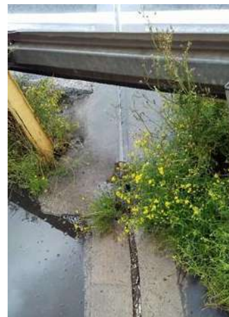
Figure 12 : Absence de relevé du joint de chaussée. Source : Visite DIR
