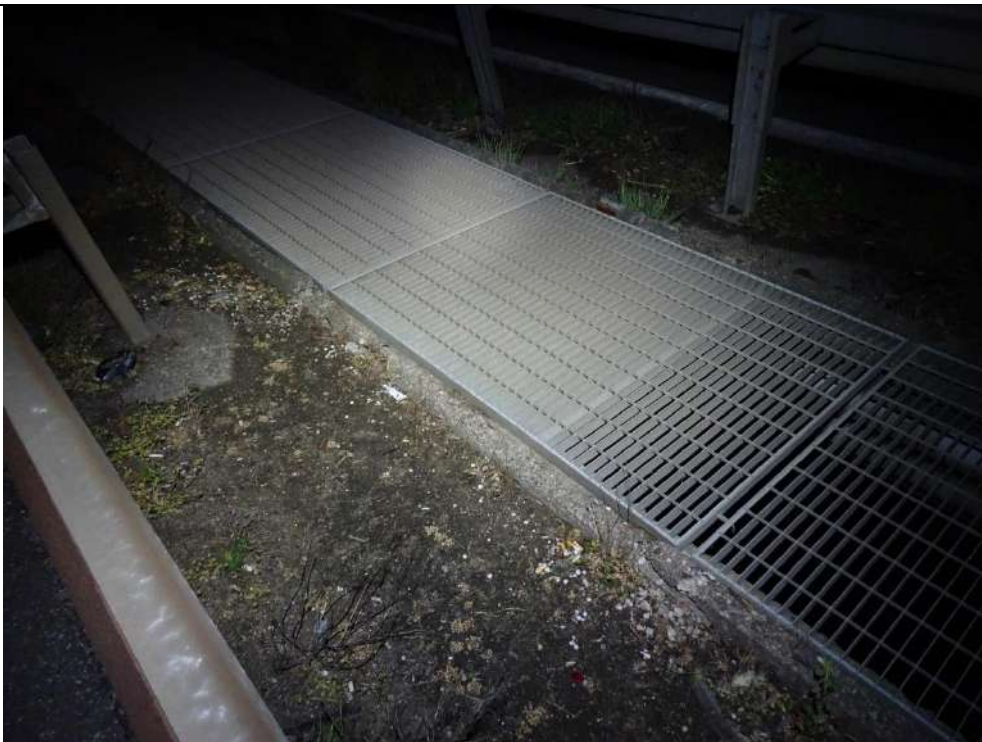
34 : Longrine aval maintenant les caillebotis altérée
