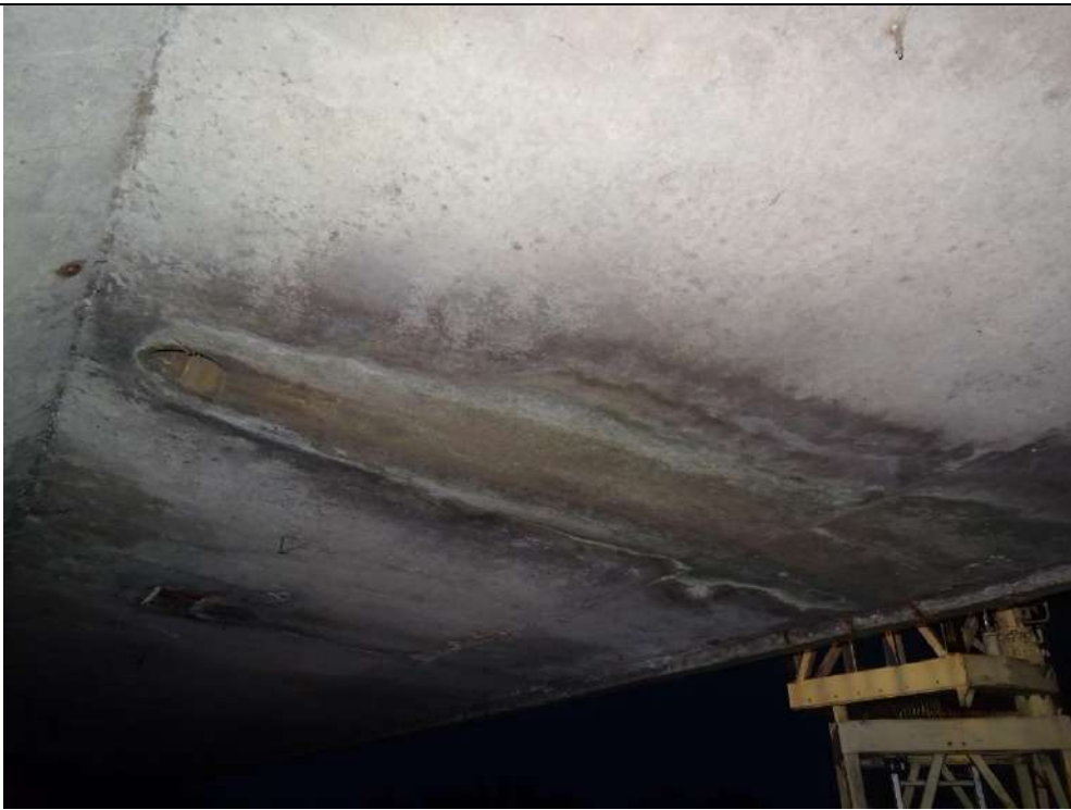
1006 : Traces de coulures sous l'encorbellement amont depuis une gargouille côté rive gauche
