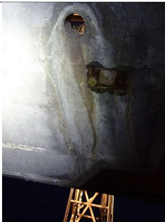
1019 : Traces de coulures sous l'encorbellement amont depuis une gargouille à mi-travée de la travée T1
