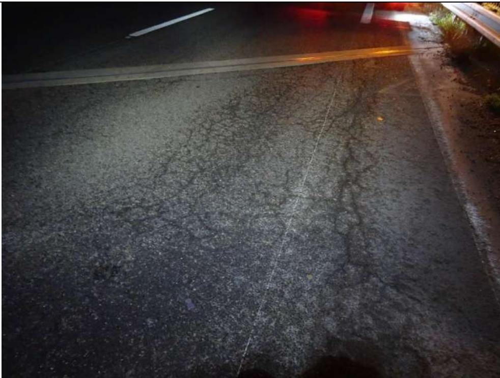
23 : Faïençage au droit de la voie lente à l'arrière du joint de chaussée côté Metz
