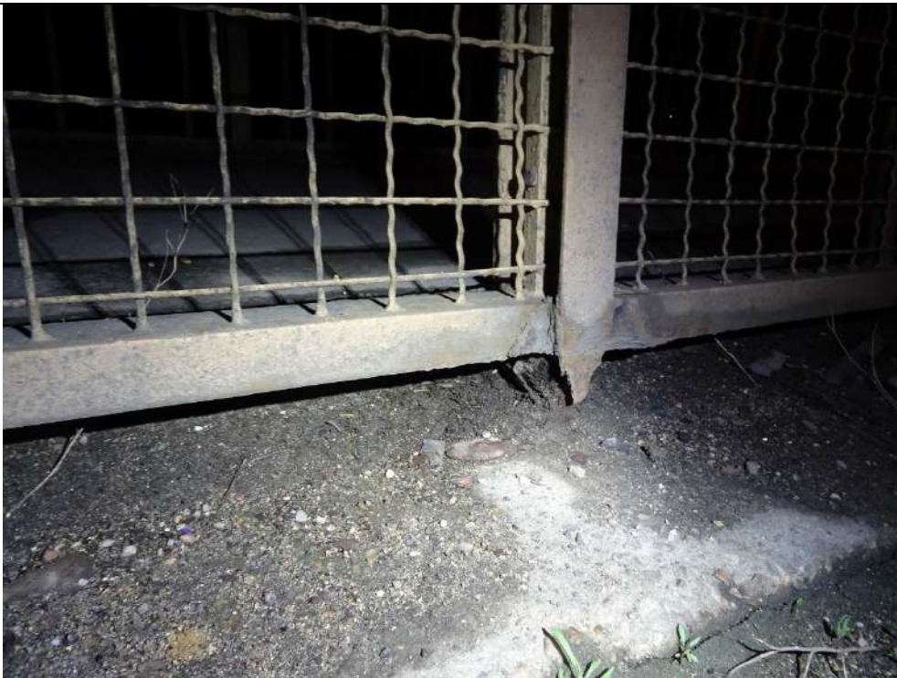
29 : Montant du garde-corps aval du trottoir amont corrodé et sectionné au droit de la glissière de sécurité déformée
