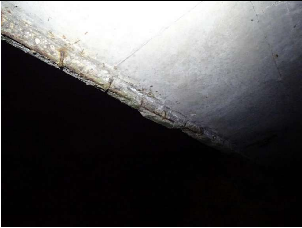
1022 : Eclats prononcés avec aciers apparents oxydés sous la retombée de corniche amont côté rive droite
