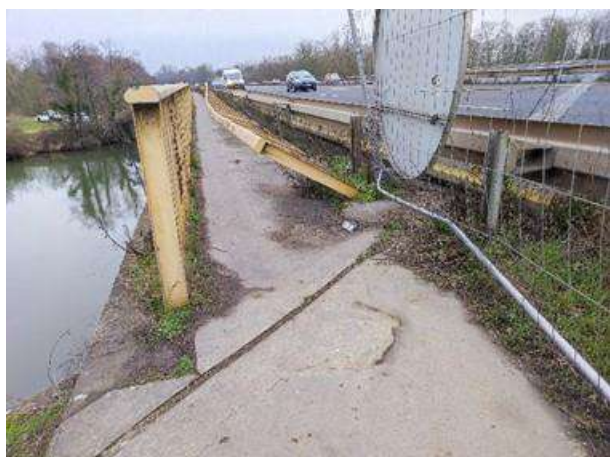
Figure 11 : Absence de joint de trottoir
