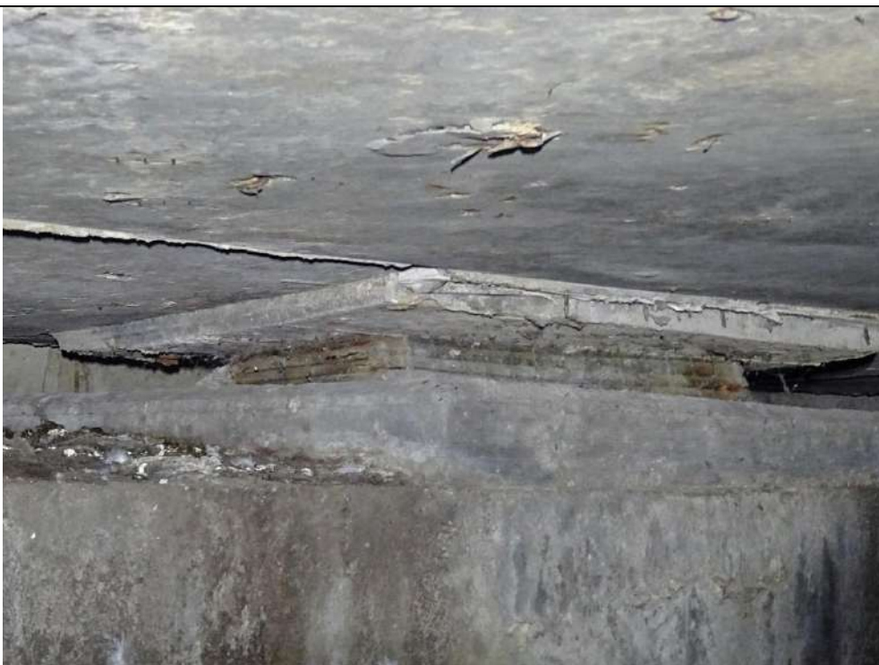
1009 : Appareil d'appui intermédiaire aval sur la culée C0 rive gauche
