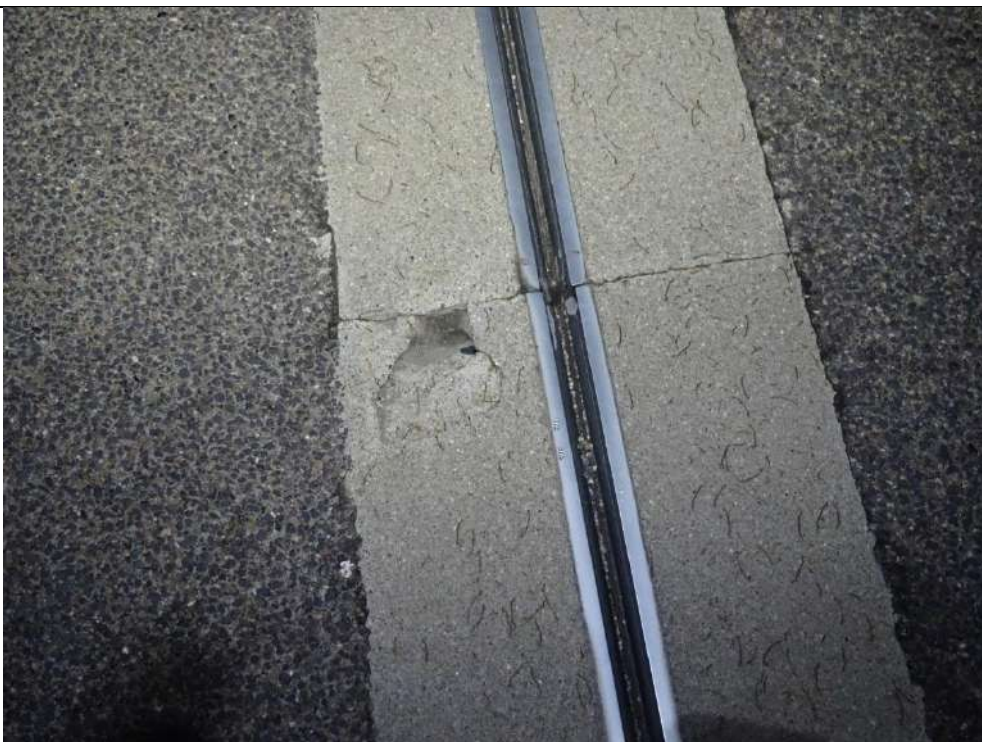
30 : Eclat au droit de la voie rapide sur le solin du joint de chaussée côté Nancy
