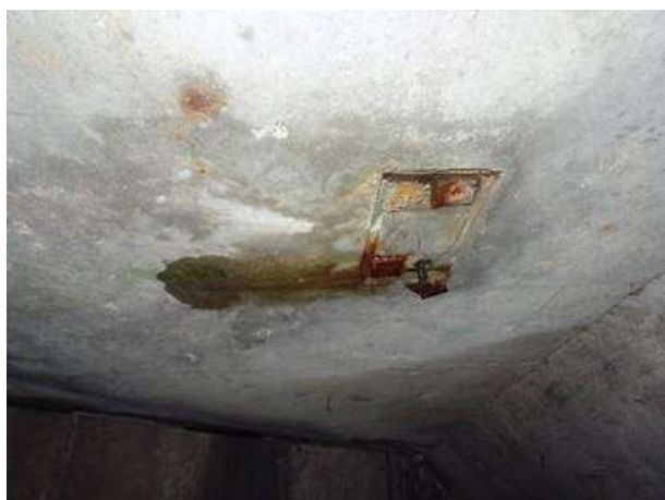
Figure 9 : Ancre traversant des glissières. Source IDP 2021
