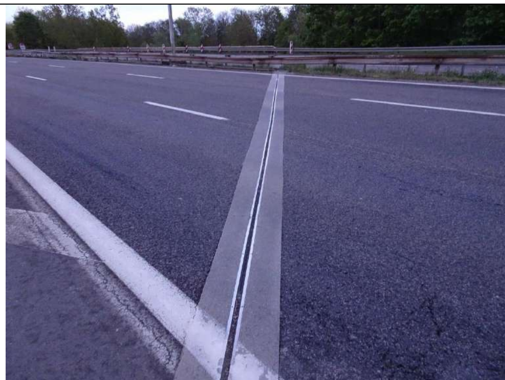
3 : Joint de chaussée côté Nancy
