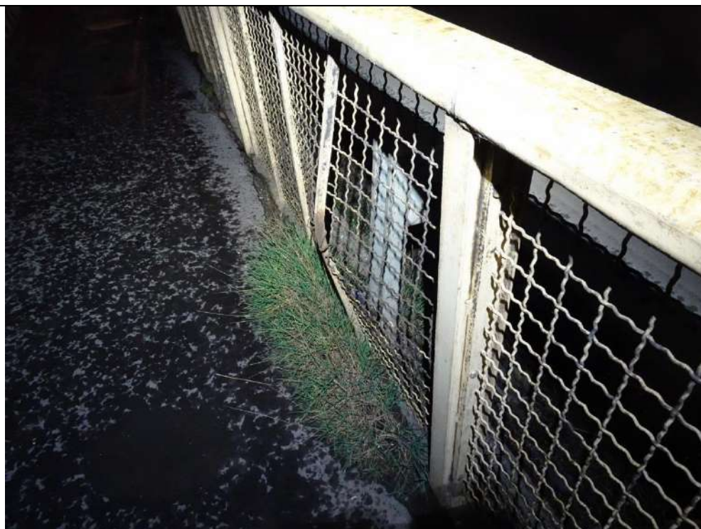
19 : Garde-corps aval du trottoir amont déformé suite à un choc dans la glissière de sécurité de la chaussée
