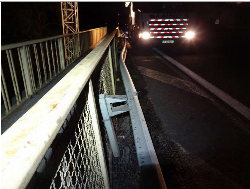
28 : Déformation de la glissière de sécurité aval avec déformation du garde-corps
