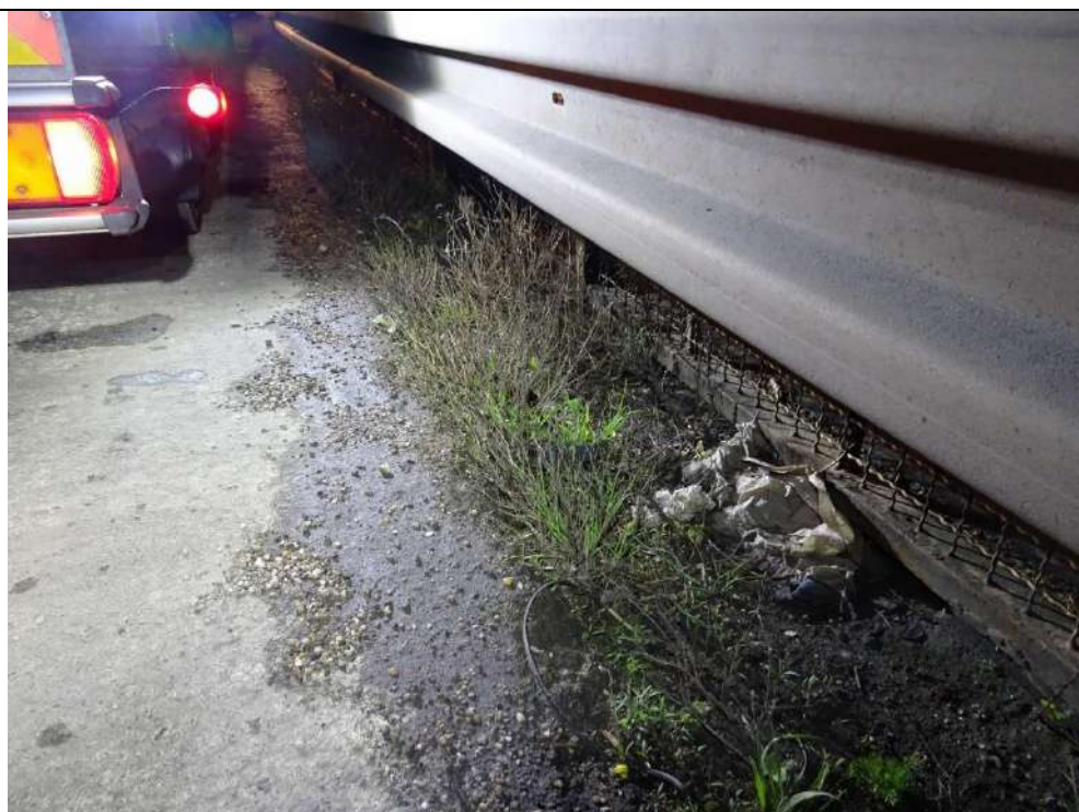
26 : Végétation et dépôts terreux généralisés entre la chaussée et le trottoir amont
