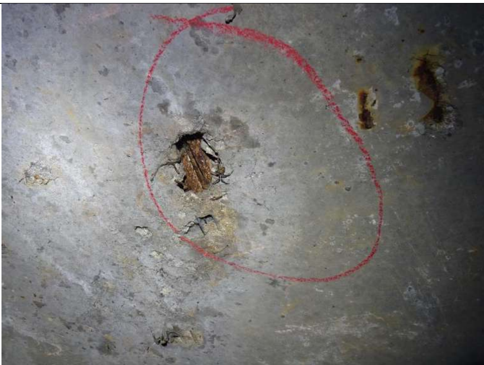
1017 : Aciers apparents oxydés en sous-face de dalle de la travée T1
