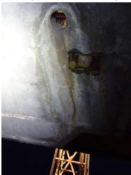
Figure 7 : Descente d'eau à travers l'encorbellement. Source : IDP 2021
