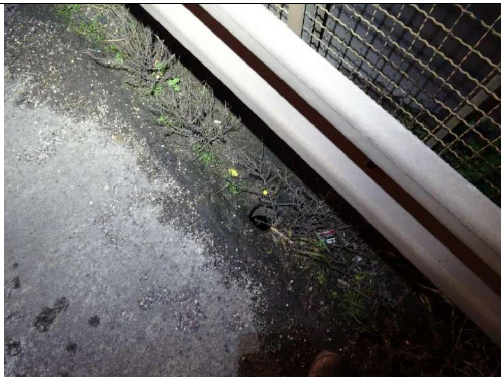
25 : Absence de grille sur les gargouilles dans le fil d'eau amont
