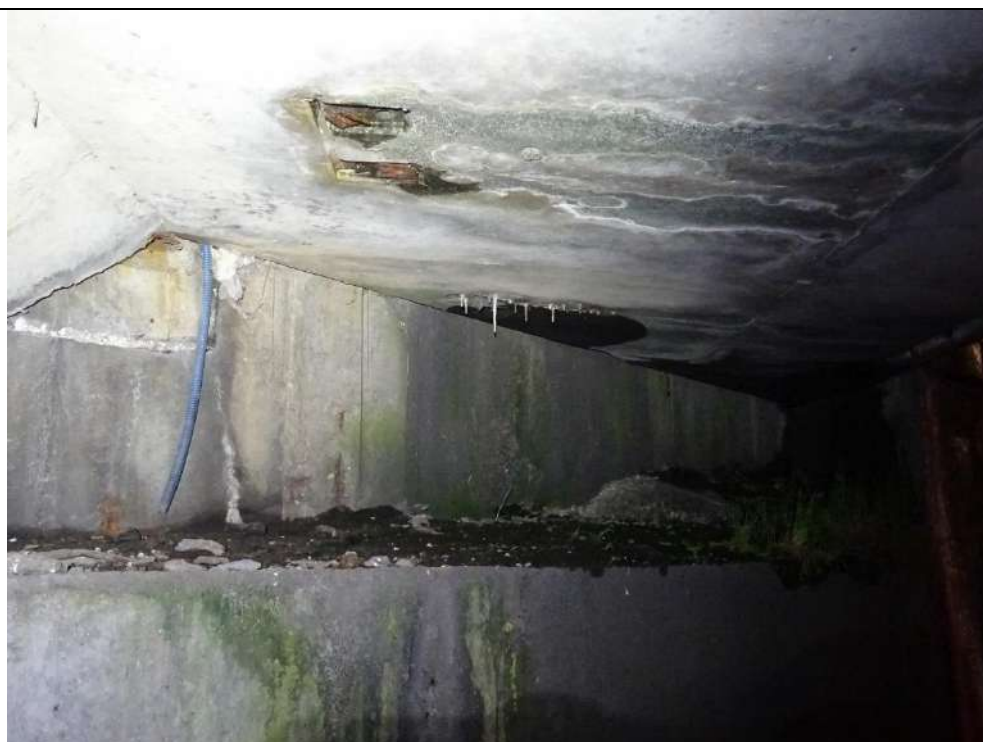
1029 : Terre et humidité sur le sommier de la culée C2 rive droite côté amont
