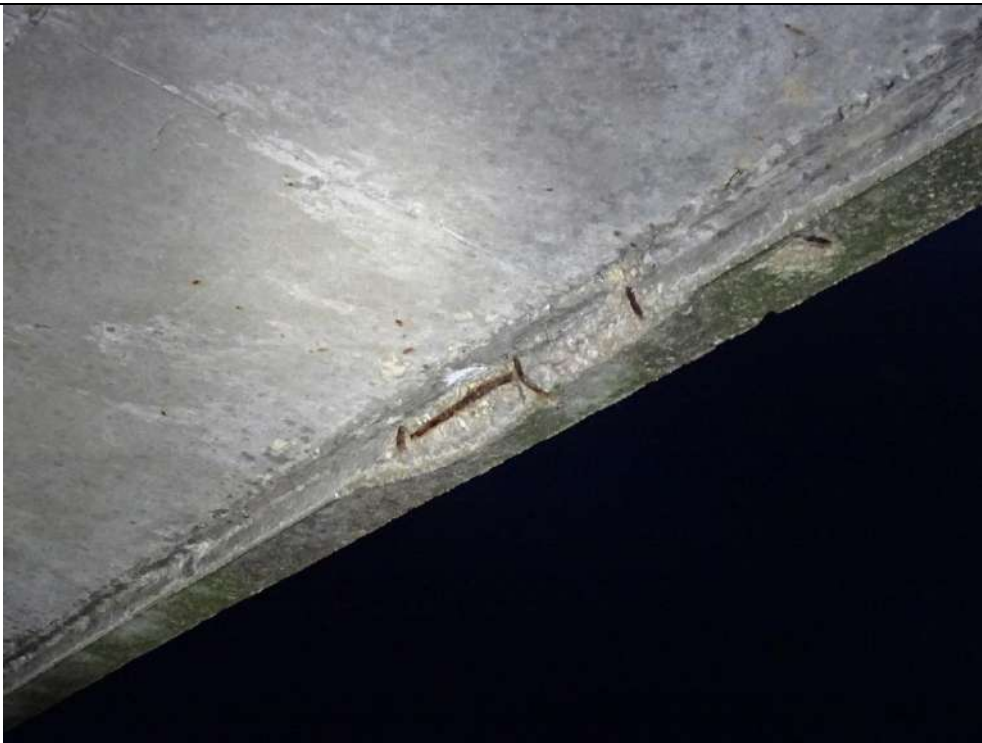
1016 : Eclats avec aciers apparents oxydés et perte de section en sous-face de corniche amont
