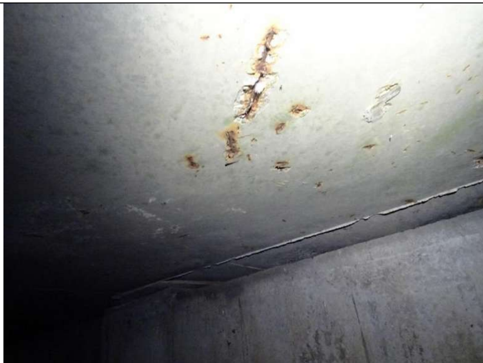
1032: Plusieurs petits aciers apparents oxydés en sous-face de la dalle de la travée T2 à proximité de la culée C2 rive droite
