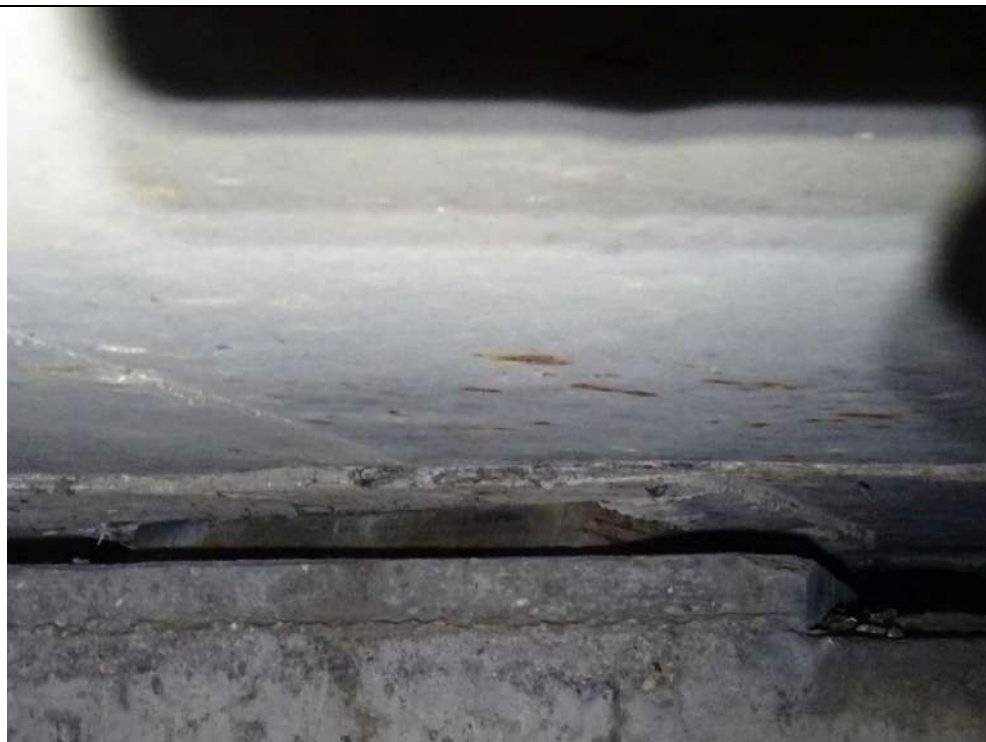
1030 : Appareil d'appui intermédiaire amont de la culée C2 rive droite
