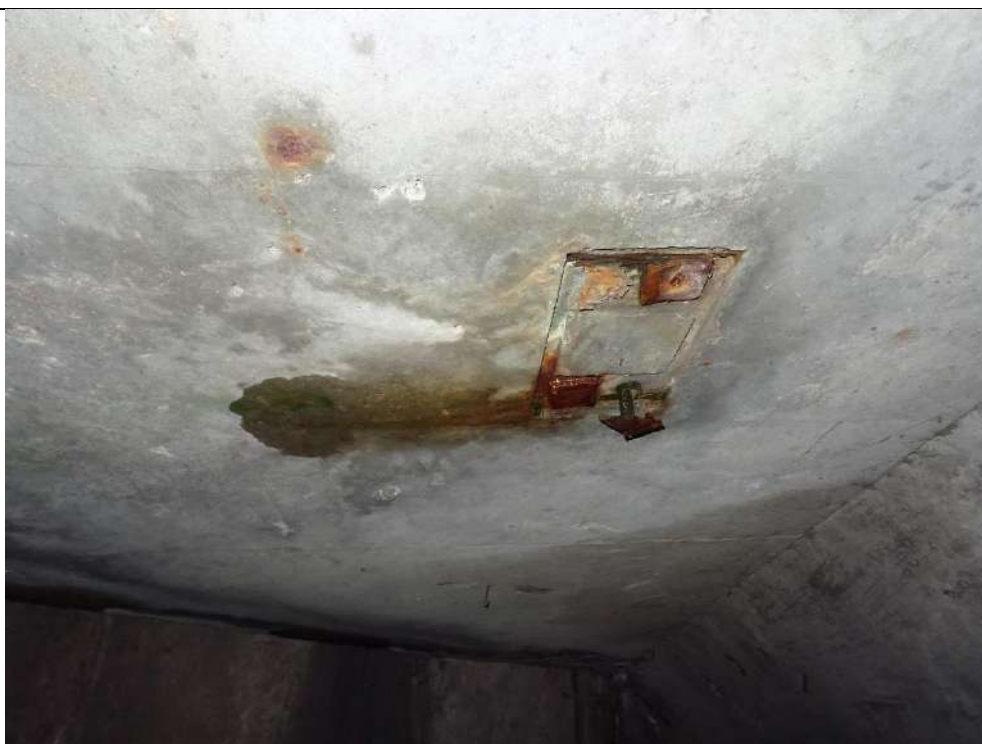
1005 : Ancrage traversant de glissière oxydé et coulures d'eau en encorbellement amont à proximité de culée C0 rive gauche
