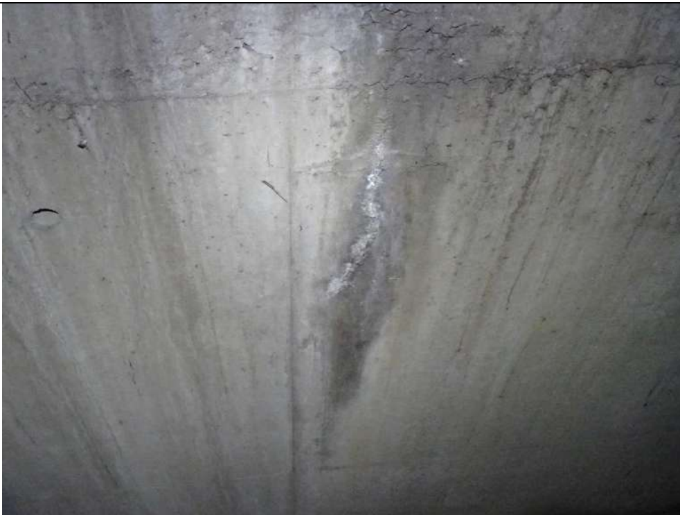
1010 : Fissure verticale avec calcite sur le mur de front de la culée C0 rive gauche
