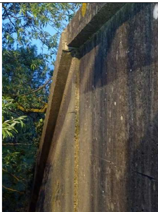
1003 : Déversement du mur en aile amont rive gauche
