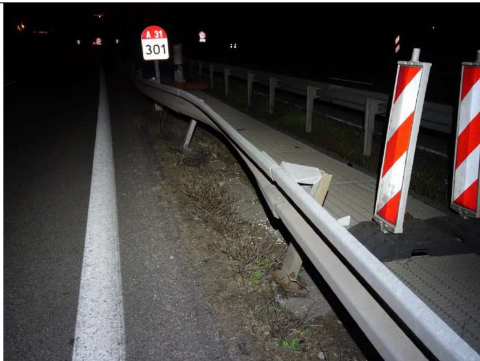
35 : Choc sur la glissière de sécurité aval côté Metz
