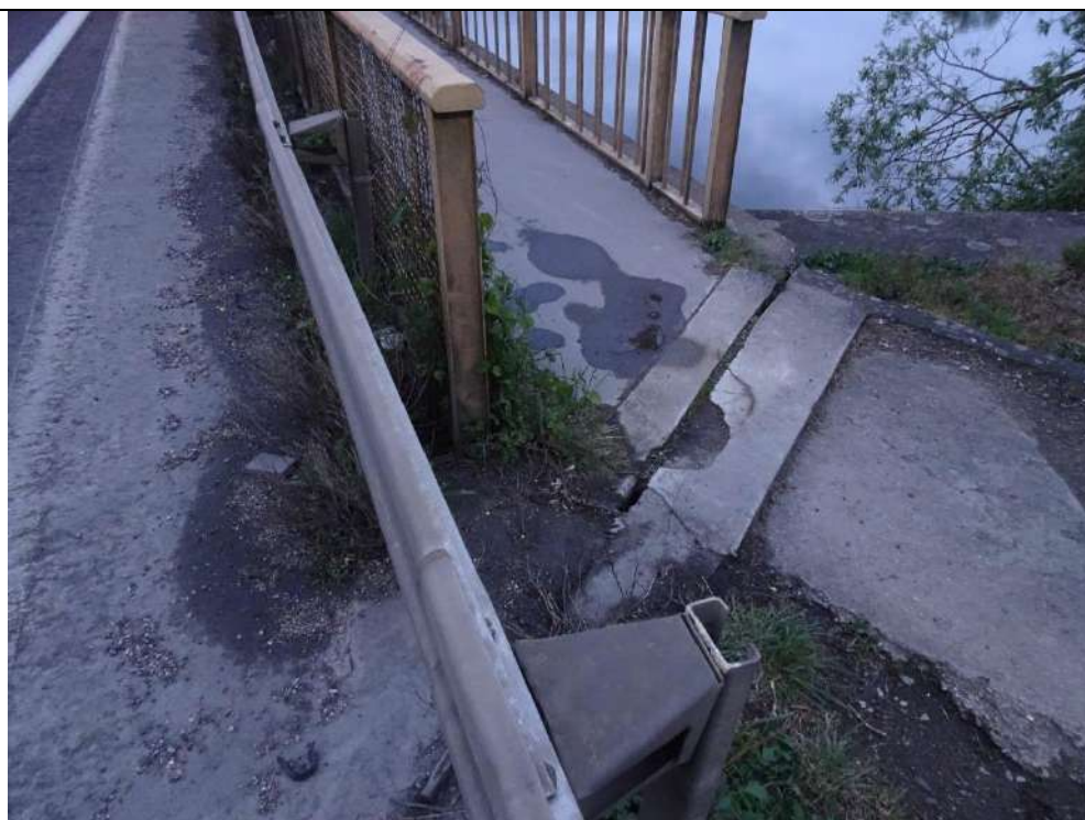
6 : Absence de joint au droit du trottoir amont côté Metz
