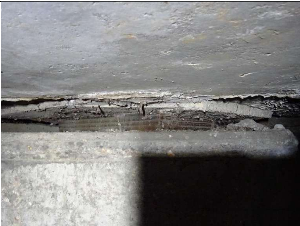
1007 : Appareil d'appui amont de la culée C0 rive gauche
