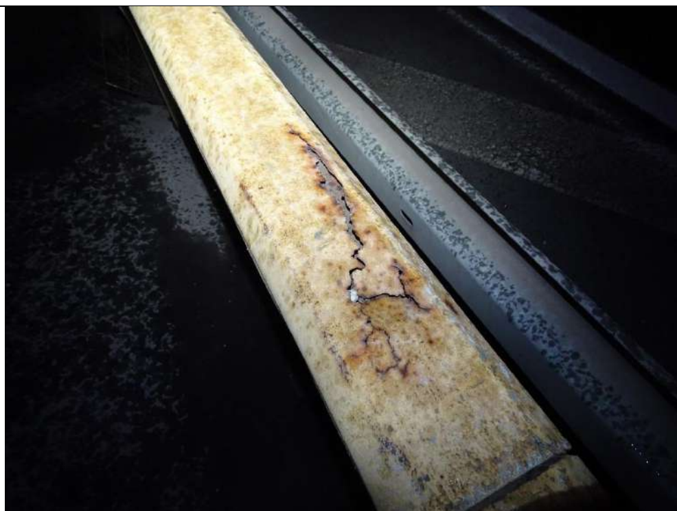
20 : Lisse supérieure du garde-corps aval du trottoir amont qui s'éventre
