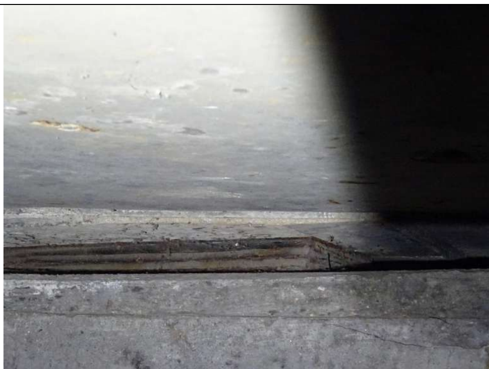
1031: Appareil d'appui central de la culée C2 rive droite
