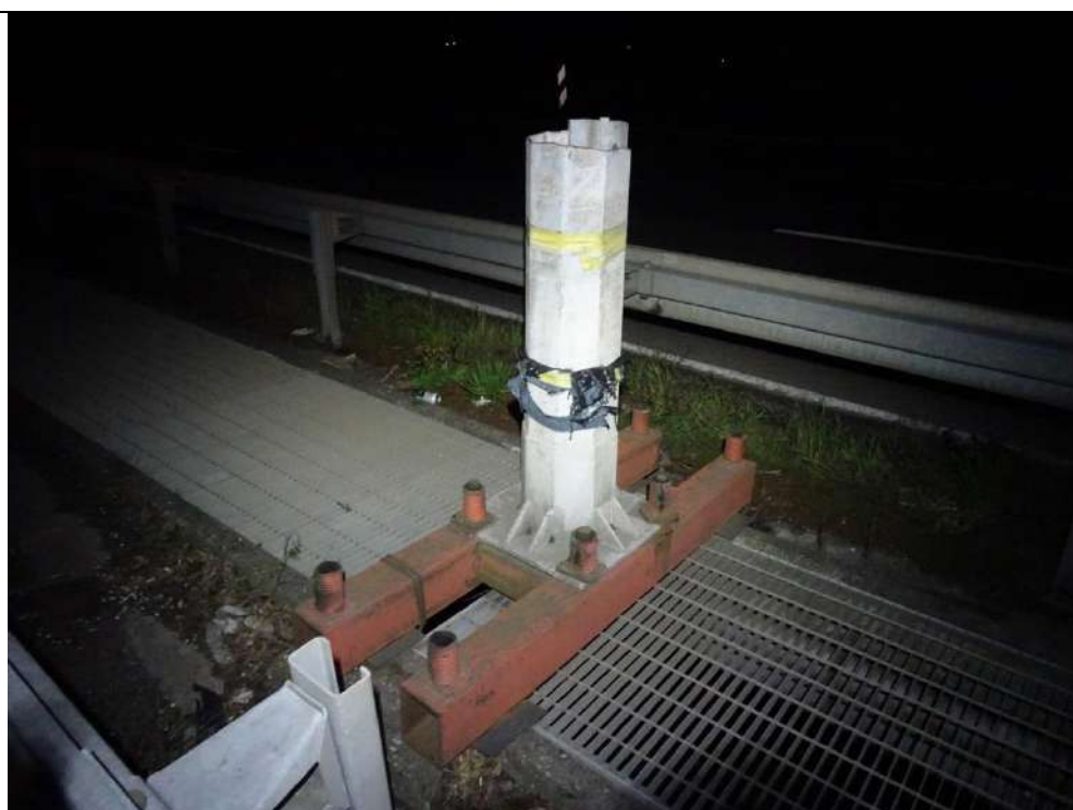
36 : Candélabre sur le TPC côté Metz sectionné
