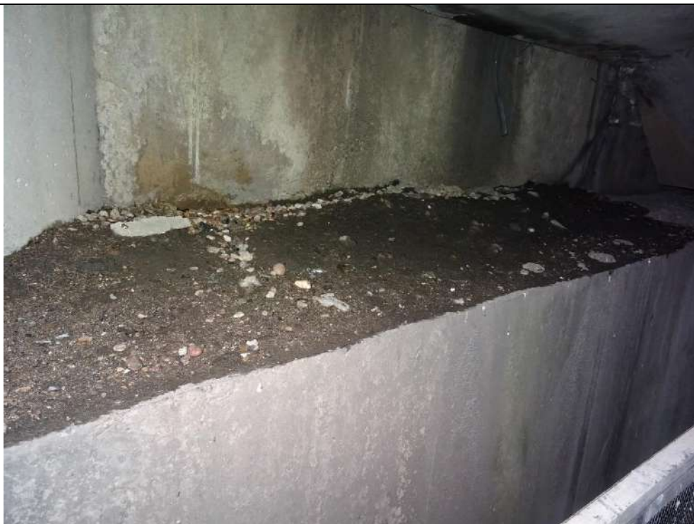
1004 : Dépôts de terre et humidité sur le sommier de la culée C0 rive gauche côté amont
