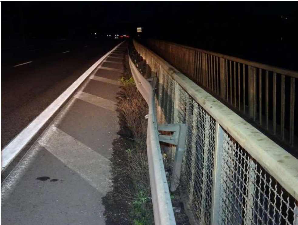
27 : Déformation de la glissière de sécurité aval avec déformation du garde-corps
