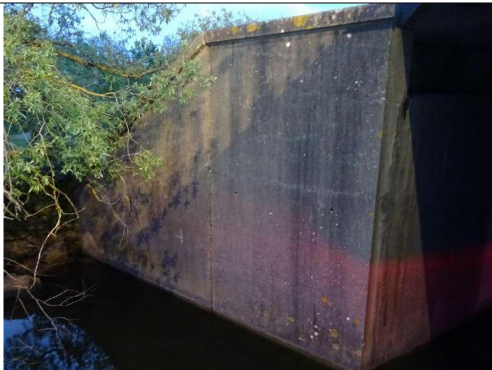
1002 : Mur en aile amont rive gauche
