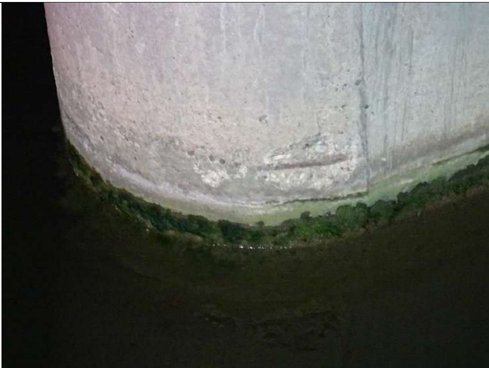
1023 : Acier apparent oxydé en pied de la pile P1 côté amont sur la face côté C2
