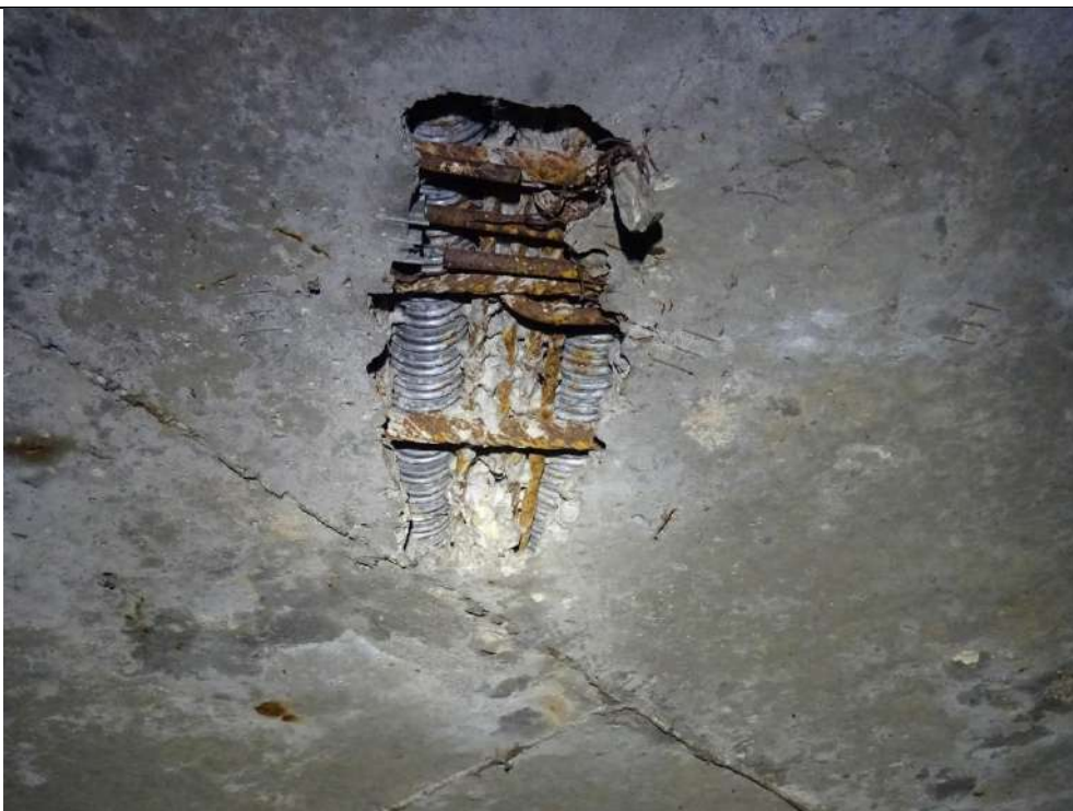
1011 : Gains de précontrainte apparentes et aciers apparents oxydés en intrados de la travée T1
