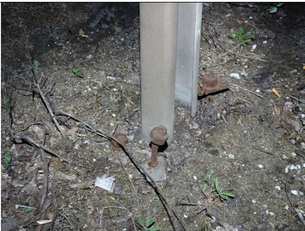
32 : Montant de glissière de sécurité aval desserré en pied à proximité de la culée C2
