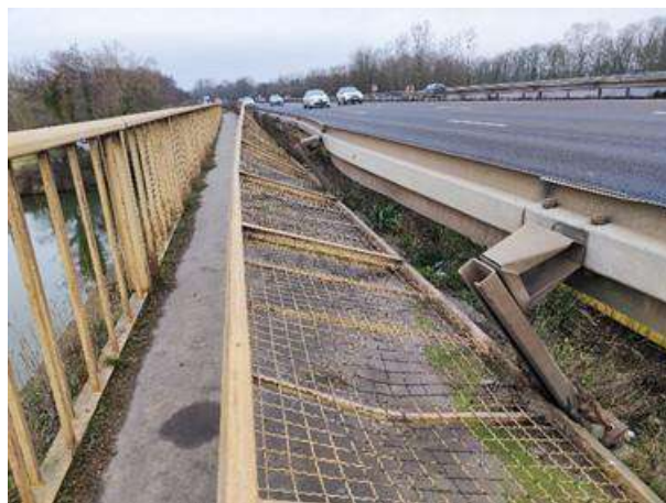
Figure 10 : État des dispositifs de retenue
