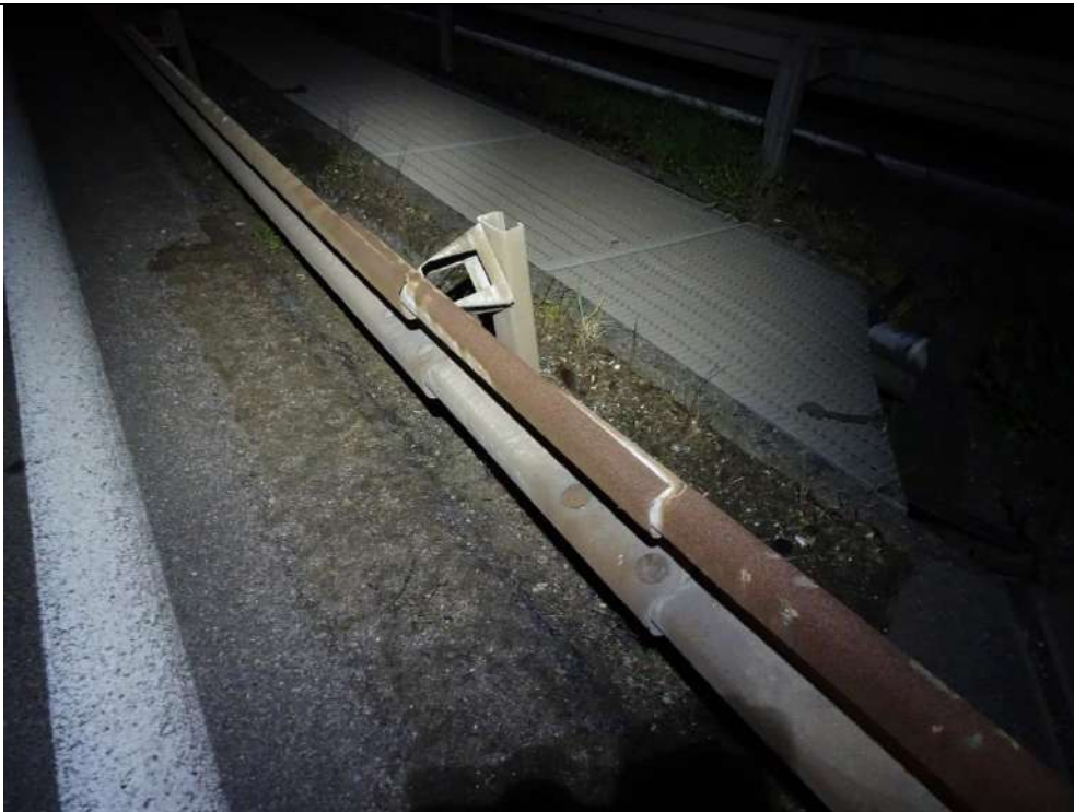
33 : Lisse de la glissière de sécurité aval corrodée avec quelques écarteurs déformés
