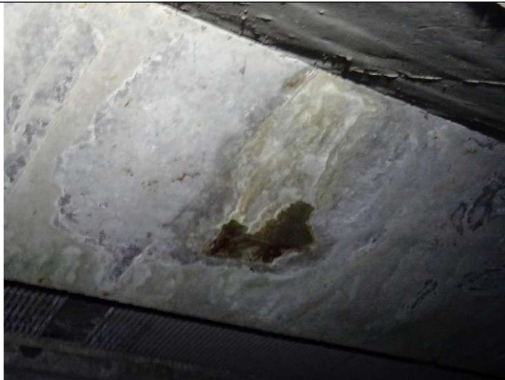
1018 : Ancrages de GS corrodés et traces humides de coulures tout le long sous l'encorbellement aval
