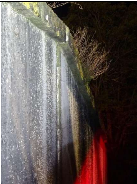
1028 : Déversement du mur en aile amont rive droite
