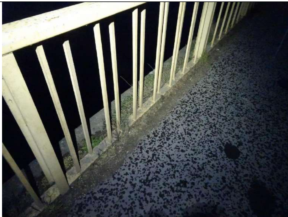
17 : Dépôts de terre et végétation tout le long en pied du garde-corps amont du trottoir amont
