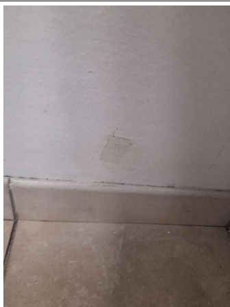
Prélèvement - P103 : COUR D'APPEL / R+0 / Pièce 21 - Enduit - (Présence d'amiante)
