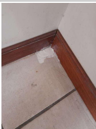
Prélèvement - P111 : COUR D'APPEL / R+0 / Pièce 23 - Colle de carrelage- (Absence d'amiante)
