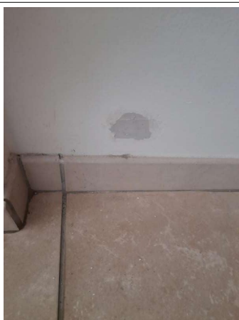
Prélèvement - P249 : COUR D'APPEL / R+1 / Pièce 46 - Enduit - (Présence d'amiante)
