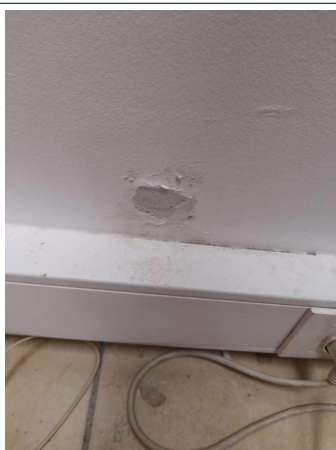
Prélèvement - P263 : COUR D'APPEL / R+1 / Pièce 49 - Enduit - (Présence d'amiante)
