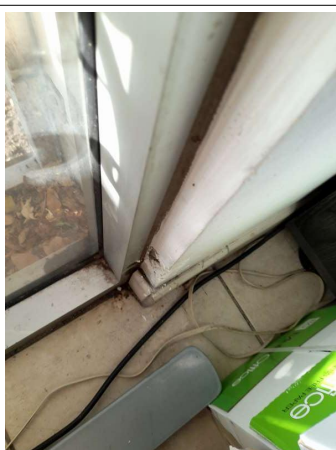
Prélèvement - P099 : COUR D'APPEL / R+0 / Pièce 20 - Enduit - (Présence d'amiante)
