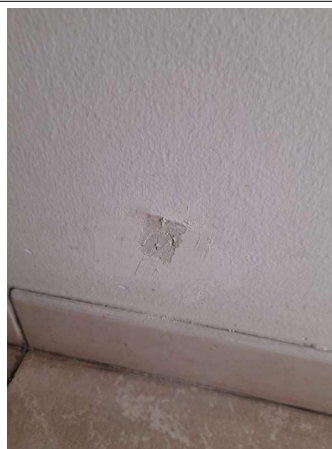
Prélèvement - P098 : COUR D'APPEL / R+0 / Pièce 20 - Enduit - (Présence d'amiante)
