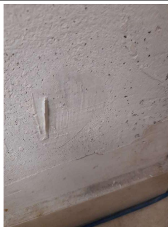
Prélèvement - P038 : COUR D'APPEL / R+0 / Pièce 08 - Enduit - (Présence d'amiante)
