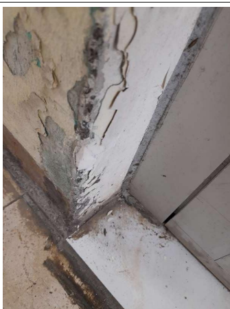
Prélèvement - P124 : COUR D'APPEL / R+0 / Coursives - Enduit- (Absence d'amiante)
