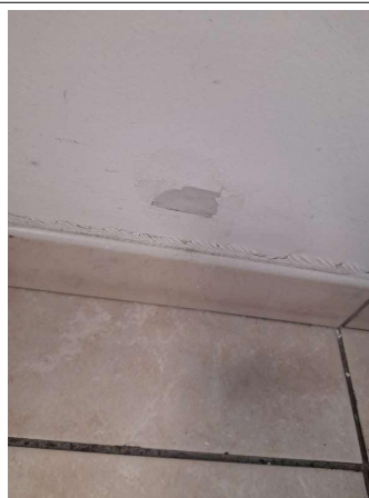
Prélèvement - P278 : COUR D'APPEL / R+1 / Pièce 52 - Enduit - (Absence d'amiante)
