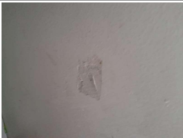
Prélèvement - P073 : COUR D'APPEL / R+0 / Pièce 15 - Enduit - (Présence d'amiante)
