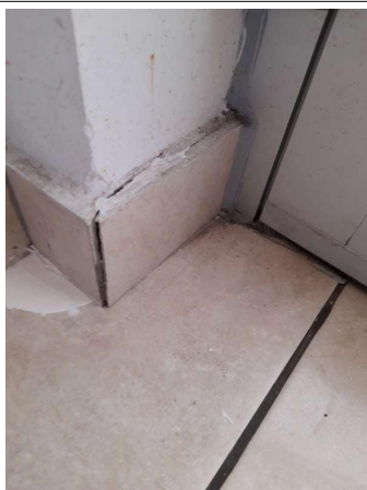
Prélèvement - P217 : COUR D'APPEL / R+1 / Pièce 40 - Colle de plinthe- (Absence d'amiante)
