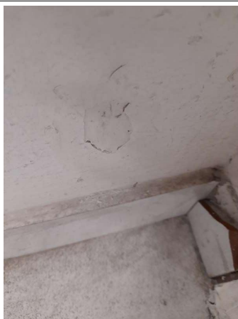
Prélèvement - P043 : COUR D'APPEL / R+0 / Pièce 09 - Enduit - (Présence d'amiante)
