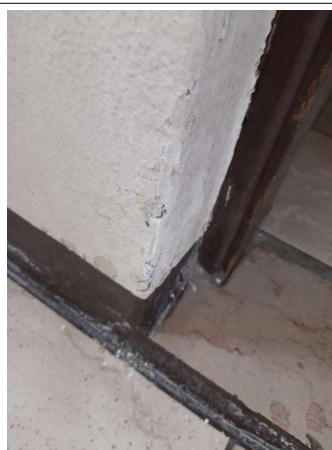
Prélèvement - P144 : COUR D'APPEL / R+1 / Coursives - Enduit- (Absence d'amiante)
