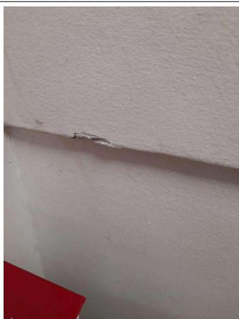
Prélèvement - P289 : COUR D'APPEL / R+1 / Pièce 54 - Enduit - (Présence d'amiante)
