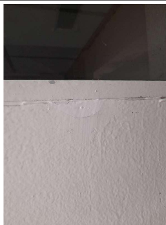
Prélèvement - P123 : COUR D'APPEL / R+0 / Coursives - Enduit- (Absence d'amiante)
