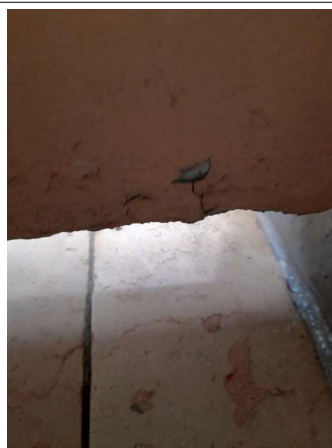
Prélèvement - P148 : COUR D'APPEL / R+1 / Coursives - Enduit- (Présence d'amiante)
