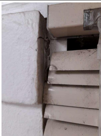
Prélèvement - P085 : COUR D'APPEL / R+0 / Pièce 17 - Joint- (Présence d'amiante)
