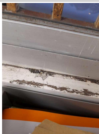
Prélèvement - P070 : COUR D'APPEL / R+0 / Pièce 14 - Joint- (Absence d'amiante)
