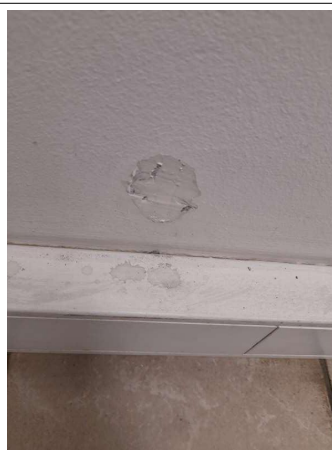
Prélèvement - P184 : COUR D'APPEL / R+1 / Pièce 32 - Enduit - (Présence d'amiante)
