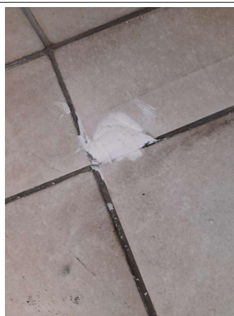
Prélèvement - P016 : COUR D'APPEL / R+0 / Pièce 04 - Colle de carrelage- (Absence d'amiante)
