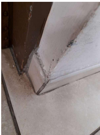
Prélèvement - P128 : COUR D'APPEL / R+0 / Pièce 25 - Enduit - (Présence d'amiante)
