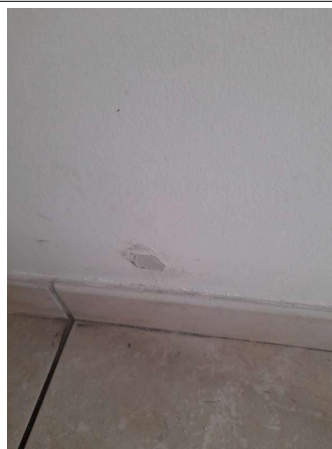
Prélèvement - P248 : COUR D'APPEL / R+1 / Pièce 46 - Enduit - (Présence d'amiante)
