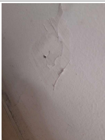
Prélèvement - P039 : COUR D'APPEL / R+0 / Pièce 08 - Enduit - (Présence d'amiante)
