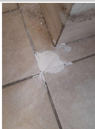
Prélèvement - P046 : COUR D'APPEL / R+0 / Pièce 10 - Colle de carrelage- (Absence d'amiante)
