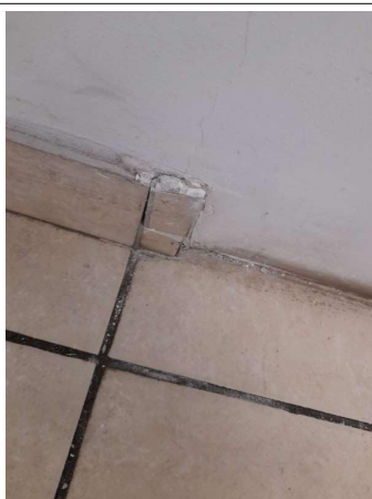
Prélèvement - P237 : COUR D'APPEL / R+1 / Pièce 44 - Colle de plinthe- (Absence d'amiante)
