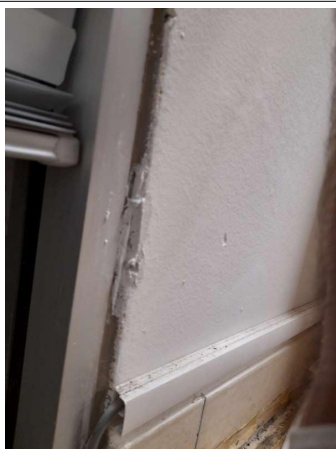
Prélèvement - P324 : COUR D'APPEL / R+0 / Pièce 62 - Enduit - (Présence d'amiante)
