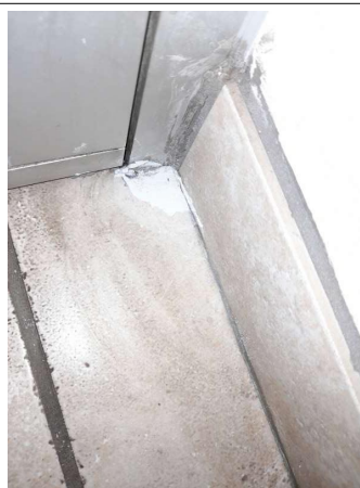
Prélèvement - P251 : COUR D'APPEL / R+1 / Pièce 47 - Colle de carrelage- (Absence d'amiante)
