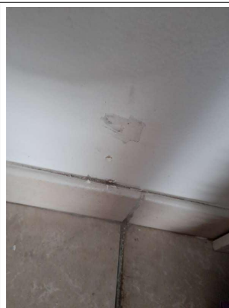
Prélèvement - P214 : COUR D'APPEL / R+1 / Pièce 39 - Enduit - (Présence d'amiante)
