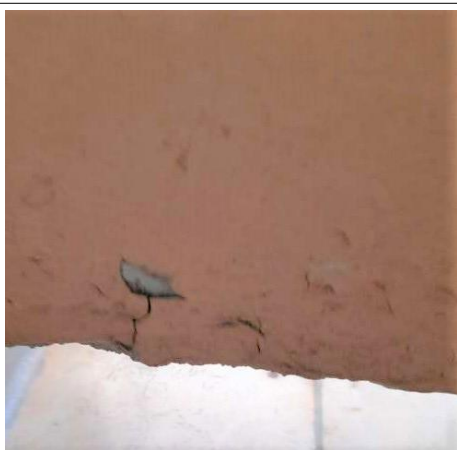
Prélèvement - P151 : COUR D'APPEL / R+1 / Coursives - Enduit- (Présence d'amiante)
