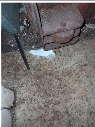
Prélèvement - P191 : COUR D'APPEL / R+0 / Pièce 34 - Dalle de sol- (Présence d'amiante)
