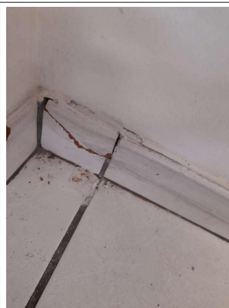
Prélèvement - P282 : COUR D'APPEL / R+1 / Pièce 53 - Colle de plinthe- (Présence d'amiante)
