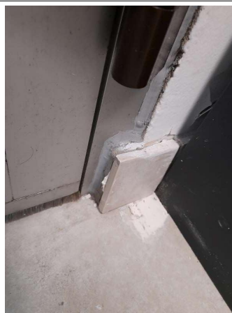
Prélèvement - P117 : COUR D'APPEL / R+0 / Pièce 24 - Colle de plinthe- (Absence d'amiante)
