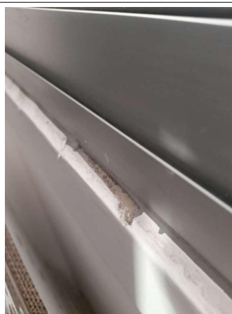
Prélèvement - P220 : COUR D'APPEL / R+1 / Pièce 40 - Joint- (Absence d'amiante)
