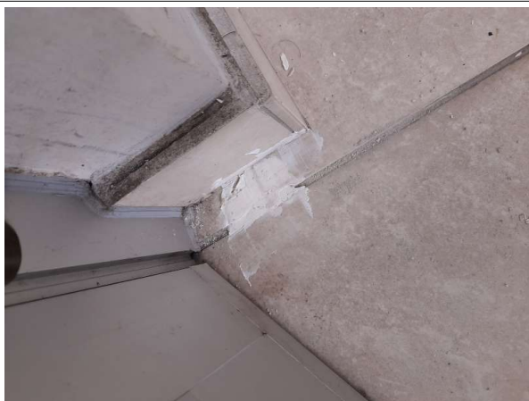
Prélèvement - P031 : COUR D'APPEL / R+0 / Pièce 07 - Colle de carrelage- (Absence d'amiante)
