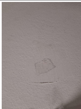
Prélèvement - P274 : COUR D'APPEL / R+1 / Pièce 51 - Enduit - (Présence d'amiante)
