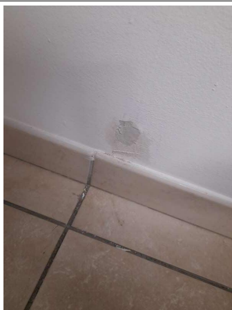
Prélèvement - P273 : COUR D'APPEL / R+1 / Pièce 51 - Enduit - (Présence d'amiante)
