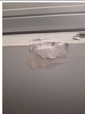
Prélèvement - P054 : COUR D'APPEL / R+0 / Pièce 11 - Enduit - (Absence d'amiante)
