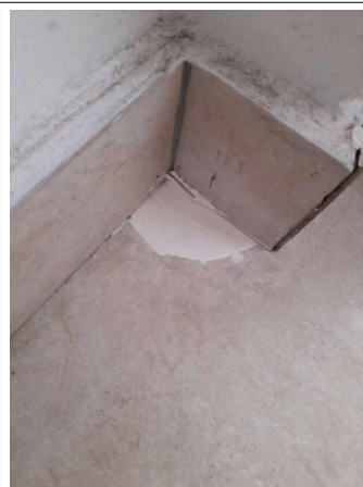
Prélèvement - P216 : COUR D'APPEL / R+1 / Pièce 40 - Colle de carrelage- (Présence d'amiante)
