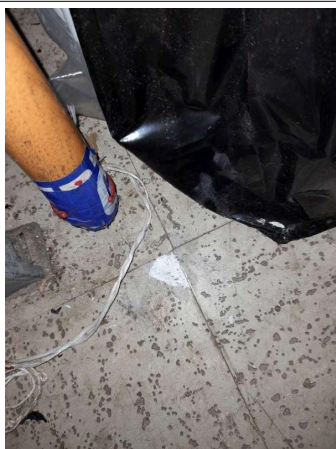
Prélèvement - P193 : COUR D'APPEL / R+0 / Pièce 34 - Dalle de sol- (Présence d'amiante)
