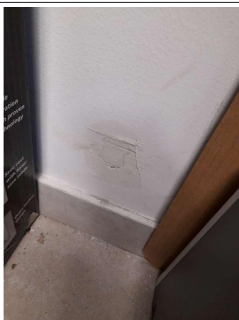
Prélèvement - P118 : COUR D'APPEL / R+0 / Pièce 24 - Enduit - (Présence d'amiante)
