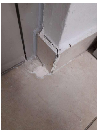
Prélèvement - P027 : COUR D'APPEL / R+0 / Pièce 06 - Colle de plinthe- (Présence d'amiante)
