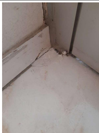
Prélèvement - P286 : COUR D'APPEL / R+1 / Pièce 54 - Colle de carrelage- (Présence d'amiante)
