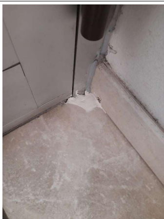
Prélèvement - P101 : COUR D'APPEL / R+0 / Pièce 21 - Colle de carrelage- (Absence d'amiante)
