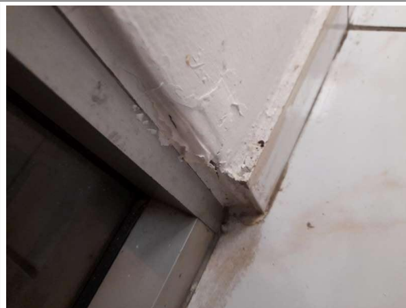
Prélèvement - P074 : COUR D'APPEL / R+0 / Pièce 15 - Enduit - (Présence d'amiante)
