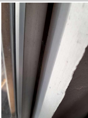
Prélèvement - P105 : COUR D'APPEL / R+0 / Pièce 21 - Joint- (Absence d'amiante)
