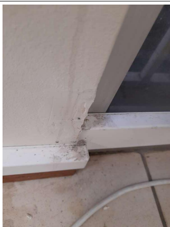
Prélèvement - P113 : COUR D'APPEL / R+0 / Pièce 23 - Enduit - (Présence d'amiante)
