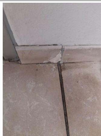
Prélèvement - P162 : COUR D'APPEL / R+1 / Pièce 28 - Colle de plinthe- (Présence d'amiante)
