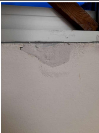
Prélèvement - P299 : COUR D'APPEL / R+1 / Pièce 56 - Enduit - (Présence d'amiante)
