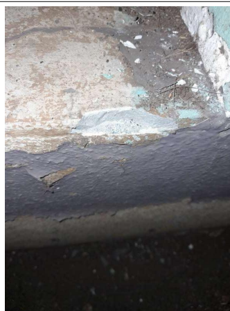
Prélèvement - P121 : COUR D'APPEL / R+0 / Patio 02 - Enduit- (Présence d'amiante)
