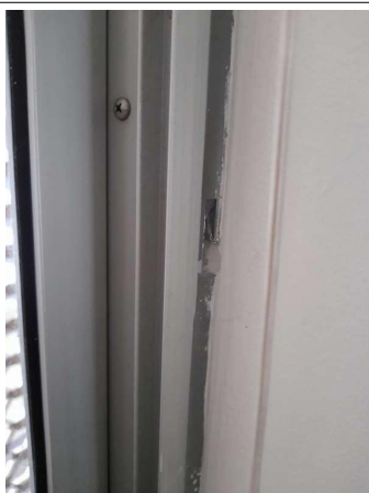
Prélèvement - P215 : COUR D'APPEL / R+1 / Pièce 39 - Joint- (Présence d'amiante)
