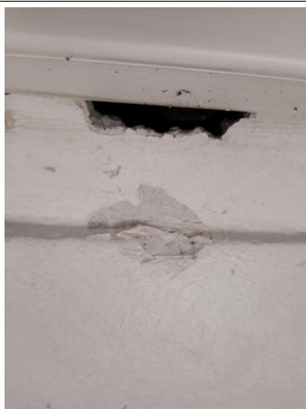
Prélèvement - P019 : COUR D'APPEL / R+0 / Pièce 04 - Enduit - (Présence d'amiante)
