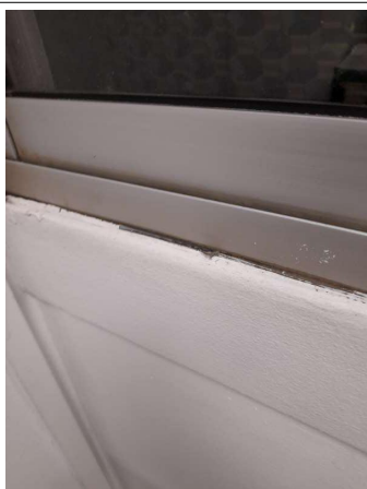
Prélèvement - P185 : COUR D'APPEL / R+1 / Pièce 32 - Joint- (Absence d'amiante)
