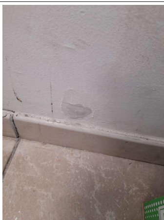
Prélèvement - P189 : COUR D'APPEL / R+0 / Pièce 33 - Enduit - (Absence d'amiante)
