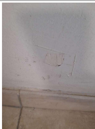
Prélèvement - P048 : COUR D'APPEL / R+0 / Pièce 10 - Enduit - (Présence d'amiante)
