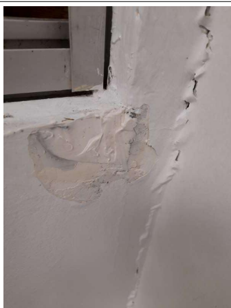
Prélèvement - P059 : COUR D'APPEL / R+0 / Pièce 12 - Enduit - (Absence d'amiante)
