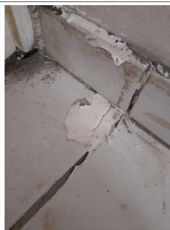
Prélèvement - P022 : COUR D'APPEL / R+0 / Pièce 05 - Colle de plinthe- (Présence d'amiante)
