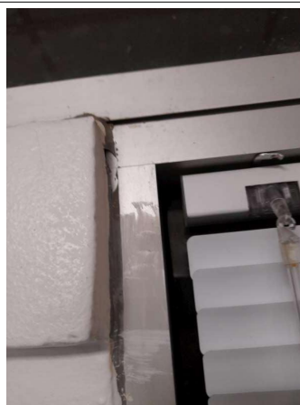
Prélèvement - P335 : COUR D'APPEL / R+0 / Pièce 64 - Joint- (Absence d'amiante)
