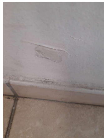
Prélèvement - P133 : COUR D'APPEL / R+0 / Pièce 26 - Enduit - (Présence d'amiante)
