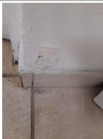
Prélèvement - P228 : COUR D'APPEL / R+1 / Pièce 42 - Enduit - (Présence d'amiante)
