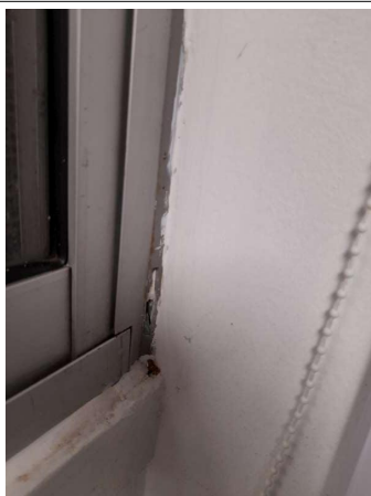
Prélèvement - P235 : COUR D'APPEL / R+1 / Pièce 43 - Joint- (Absence d'amiante)
