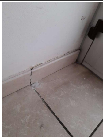
Prélèvement - P247 : COUR D'APPEL / R+1 / Pièce 46 - Colle de plinthe- (Présence d'amiante)
