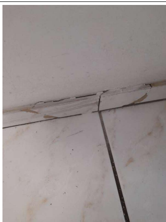
Prélèvement - P287 : COUR D'APPEL / R+1 / Pièce 54 - Colle de plinthe- (Absence d'amiante)
