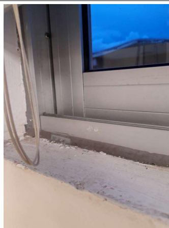
Prélèvement - P300 : COUR D'APPEL / R+1 / Pièce 56 - Joint- (Présence d'amiante)
