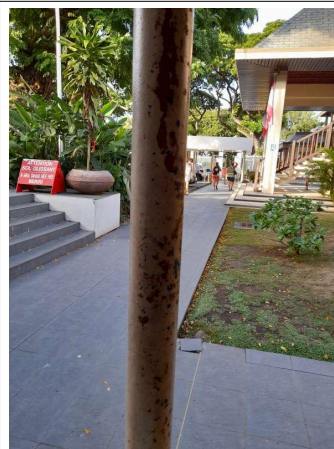
Prélèvement - P158 : COUR D'APPEL / Extérieur / Auvent - Peinture- (Absence d'amiante)
