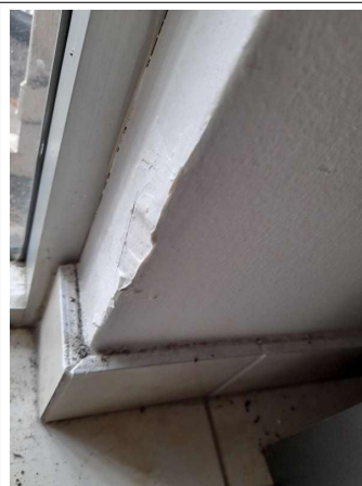
Prélèvement - P139 : COUR D'APPEL / R+0 / Pièce 27 - Enduit - (Présence d'amiante)
