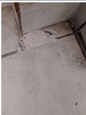
Prélèvement - P041 : COUR D'APPEL / R+0 / Pièce 09 - Colle de carrelage- (Absence d'amiante)
