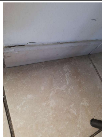
Prélèvement - P212 : COUR D'APPEL / R+1 / Pièce 39 - Colle de plinthe- (Absence d'amiante)
