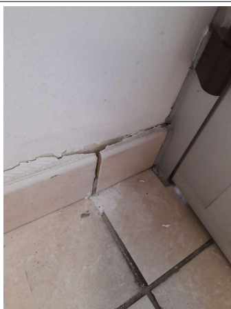
Prélèvement - P277 : COUR D'APPEL / R+1 / Pièce 52 - Colle de plinthe- (Présence d'amiante)
