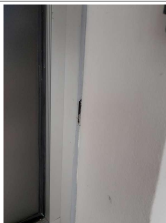
Prélèvement - P317 : COUR D'APPEL / R+1 / Pièce 60 - Joint- (Absence d'amiante)
