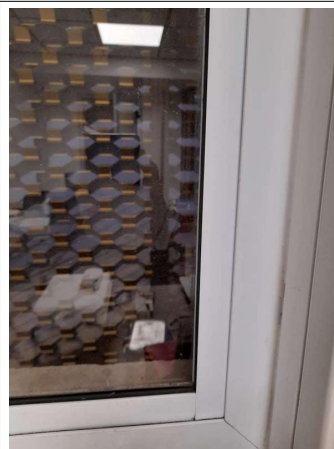
Prélèvement - P230 : COUR D'APPEL / R+1 / Pièce 42 - Joint- (Absence d'amiante)
