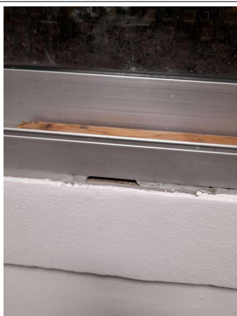
Prélèvement - P265 : COUR D'APPEL / R+1 / Pièce 49 - Joint- (Absence d'amiante)
