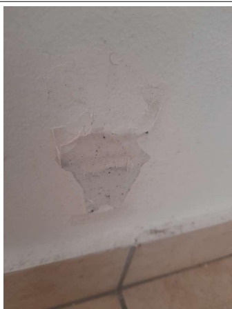
Prélèvement - P209 : COUR D'APPEL / R+1 / Pièce 38 - Enduit - (Présence d'amiante)
