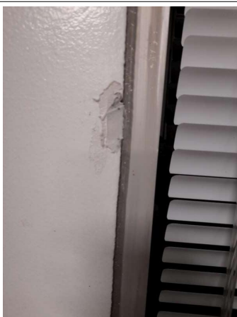
Prélèvement - P334 : COUR D'APPEL / R+0 / Pièce 64 - Enduit - (Présence d'amiante)
