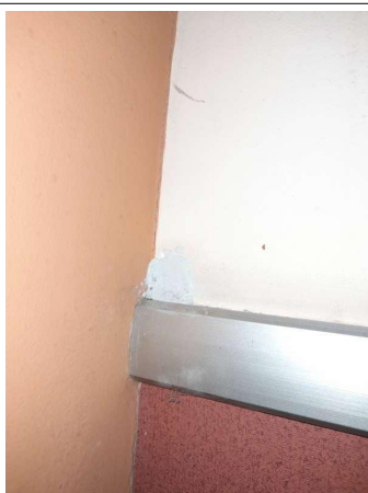
Prélèvement - P343 : COUR D'APPEL / R+1 / Pièce 68 - Enduit - (Présence d'amiante)
