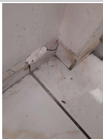
Prélèvement - P082 : COUR D'APPEL / R+0 / Pièce 17 - Colle de plinthe- (Présence d'amiante)
