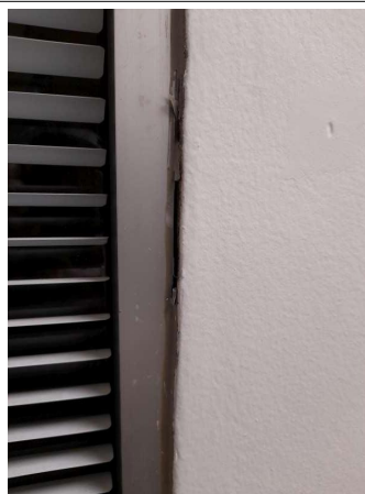
Prélèvement - P325 : COUR D'APPEL / R+0 / Pièce 62 - Joint- (Absence d'amiante)
