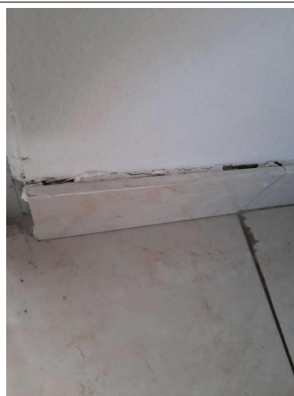
Prélèvement - P222 : COUR D'APPEL / R+1 / Pièce 41 - Colle de plinthe- (Présence d'amiante)
