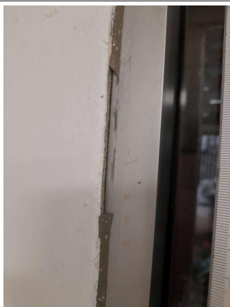
Prélèvement - P025 : COUR D'APPEL / R+0 / Pièce 05 - Joint- (Absence d'amiante)
