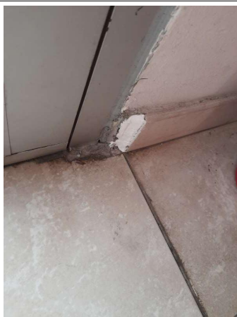
Prélèvement - P097 : COUR D'APPEL / R+0 / Pièce 20 - Colle de plinthe- (Absence d'amiante)
