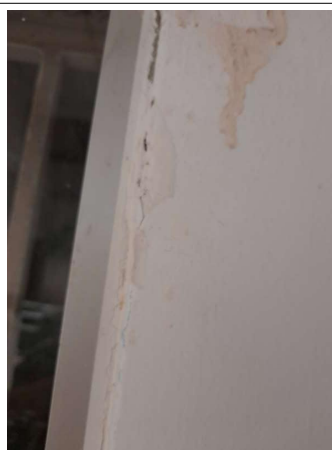
Prélèvement - P119 : COUR D'APPEL / R+0 / Pièce 24 - Enduit - (Présence d'amiante)
