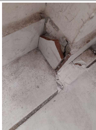
Prélèvement - P042 : COUR D'APPEL / R+0 / Pièce 09 - Colle de plinthe- (Présence d'amiante)
