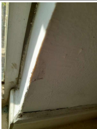
Prélèvement - P134 : COUR D'APPEL / R+0 / Pièce 26 - Enduit - (Présence d'amiante)
