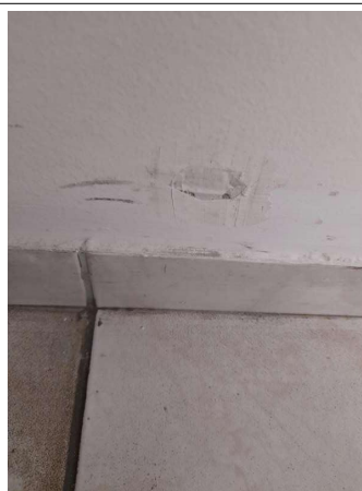
Prélèvement - P088 : COUR D'APPEL / R+0 / Pièce 18 - Enduit - (Présence d'amiante)
