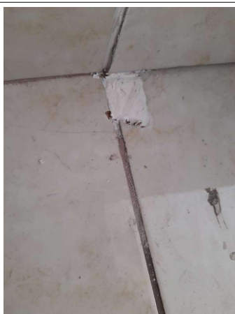
Prélèvement - P136 : COUR D'APPEL / R+0 / Pièce 27 - Colle de carrelage- (Présence d'amiante)
