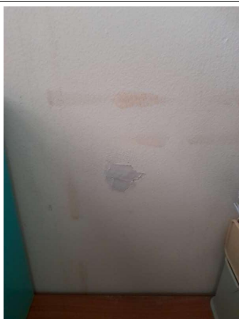
Prélèvement - P253 : COUR D'APPEL / R+1 / Pièce 47 - Enduit - (Présence d'amiante)
