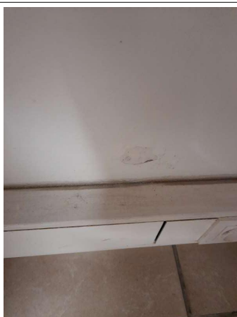
Prélèvement - P183 : COUR D'APPEL / R+1 / Pièce 32 - Enduit - (Présence d'amiante)
