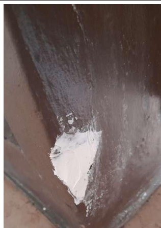
Prélèvement - P150 : COUR D'APPEL / R+1 / Coursives - Enduit- (Absence d'amiante)
