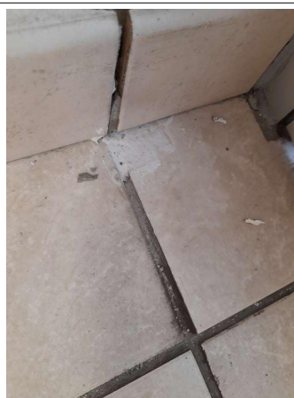
Prélèvement - P276 : COUR D'APPEL / R+1 / Pièce 52 - Colle de carrelage- (Absence d'amiante)
