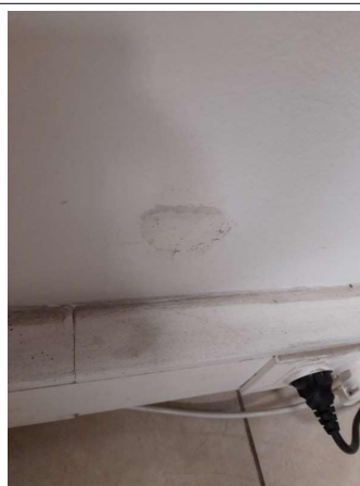
Prélèvement - P244 : COUR D'APPEL / R+1 / Pièce 45 - Enduit - (Présence d'amiante)
