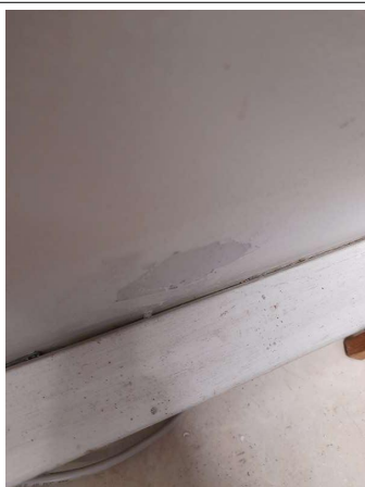
Prélèvement - P259 : COUR D'APPEL / R+1 / Pièce 48 - Enduit - (Présence d'amiante)
