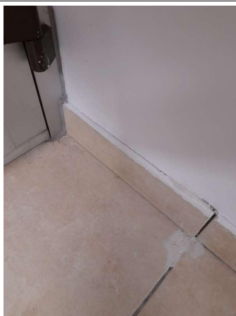
Prélèvement - P267 : COUR D'APPEL / R+1 / Pièce 50 - Colle de plinthe- (Présence d'amiante)
