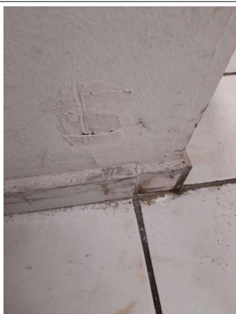
Prélèvement - P083 : COUR D'APPEL / R+0 / Pièce 17 - Enduit - (Présence d'amiante)
