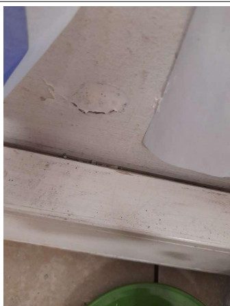
Prélèvement - P179 : COUR D'APPEL / R+1 / Pièce 31 - Enduit - (Présence d'amiante)
