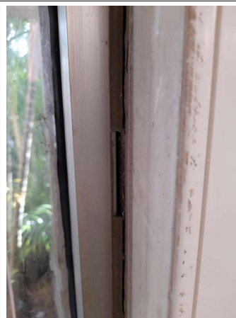
Prélèvement - P050 : COUR D'APPEL / R+0 / Pièce 10 - Joint- (Absence d'amiante)
