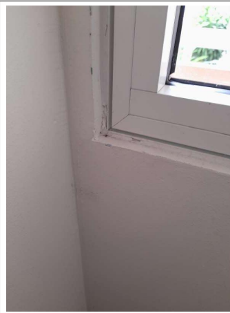
Prélèvement - P200 : COUR D'APPEL / R+1 / Pièce 35 - Joint- (Absence d'amiante)
