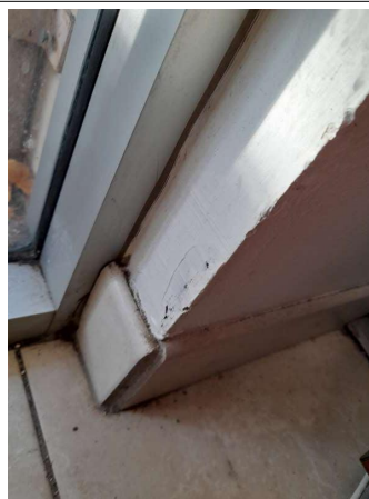
Prélèvement - P104 : COUR D'APPEL / R+0 / Pièce 21 - Enduit - (Présence d'amiante)
