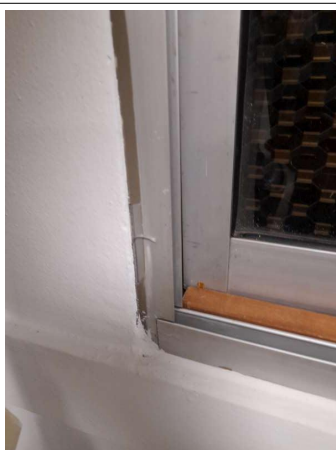
Prélèvement - P275 : COUR D'APPEL / R+1 / Pièce 51 - Joint- (Absence d'amiante)
