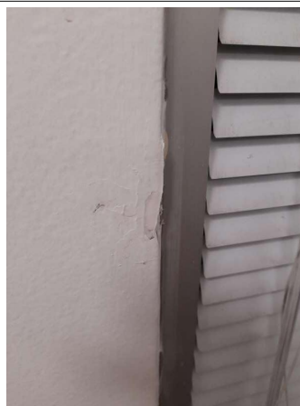
Prélèvement - P044 : COUR D'APPEL / R+0 / Pièce 09 - Enduit - (Présence d'amiante)
