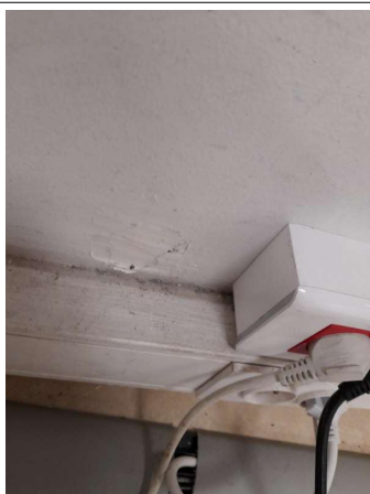
Prélèvement - P239 : COUR D'APPEL / R+1 / Pièce 44 - Enduit - (Présence d'amiante)
