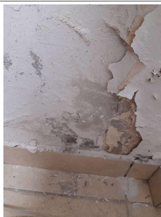
Prélèvement - P323 : COUR D'APPEL / R+0 / Pièce 62 - Enduit - (Présence d'amiante)
