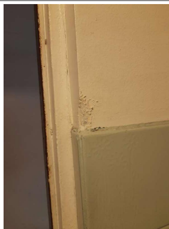
Prélèvement - P349 : COUR D'APPEL / R+0 / WC - Enduit- (Absence d'amiante)
