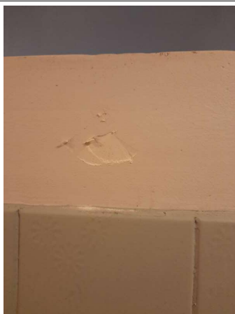
Prélèvement - P348 : COUR D'APPEL / R+0 / WC - Enduit- (Absence d'amiante)
