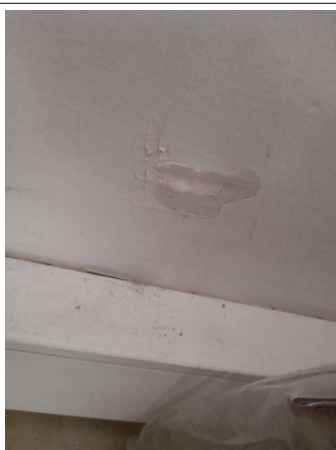
Prélèvement - P219 : COUR D'APPEL / R+1 / Pièce 40 - Enduit - (Présence d'amiante)
