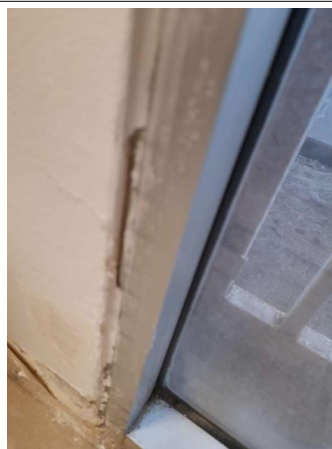
Prélèvement - P110 : COUR D'APPEL / R+0 / Pièce 22 - Joint- (Présence d'amiante)
