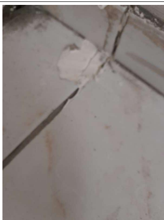
Prélèvement - P021 : COUR D'APPEL / R+0 / Pièce 05 - Colle de carrelage- (Absence d'amiante)
