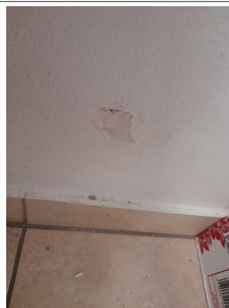
Prélèvement - P234 : COUR D'APPEL / R+1 / Pièce 43 - Enduit - (Présence d'amiante)
