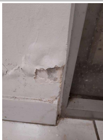
Prélèvement - P004 : COUR D'APPEL / R+0 / Pièce 01 - Enduit - (Présence d'amiante)
