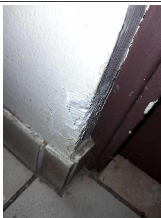
Prélèvement - P125 : COUR D'APPEL / R+0 / Coursives - Enduit- (Absence d'amiante)
