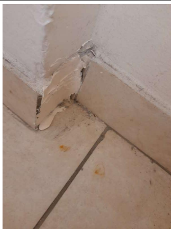
Prélèvement - P007 : COUR D'APPEL / R+0 / Pièce 02 - Colle de plinthe- (Présence d'amiante)
