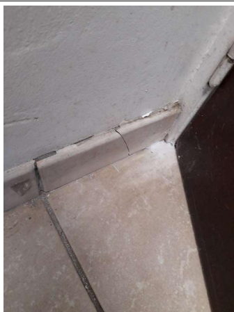
Prélèvement - P187 : COUR D'APPEL / R+0 / Pièce 33 - Colle de plinthe- (Absence d'amiante)
