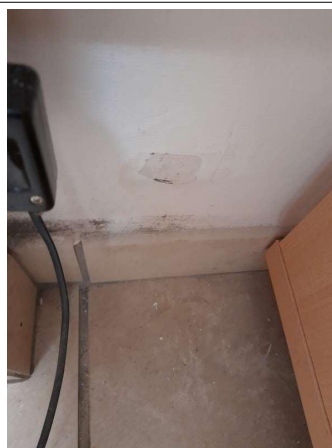
Prélèvement - P174 : COUR D'APPEL / R+1 / Pièce 30 - Enduit - (Présence d'amiante)
