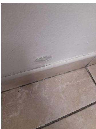
Prélèvement - P293 : COUR D'APPEL / R+1 / Pièce 55 - Enduit - (Présence d'amiante)
