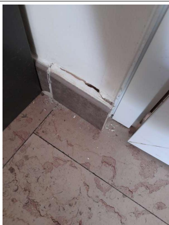
Prélèvement - P197 : COUR D'APPEL / R+1 / Pièce 35 - Colle de plinthe- (Absence d'amiante)
