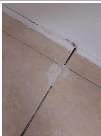
Prélèvement - P266 : COUR D'APPEL / R+1 / Pièce 50 - Colle de carrelage- (Absence d'amiante)
