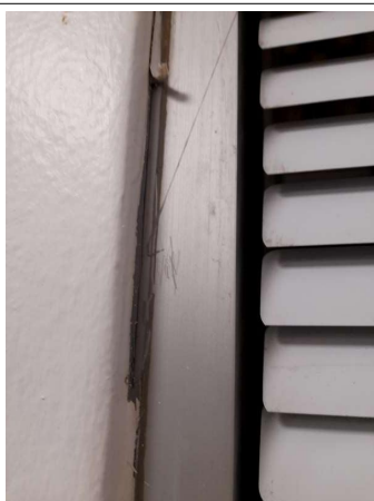
Prélèvement - P045 : COUR D'APPEL / R+0 / Pièce 09 - Joint- (Absence d'amiante)
