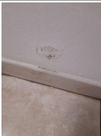
Prélèvement - P163 : COUR D'APPEL / R+1 / Pièce 28 - Enduit - (Présence d'amiante)
