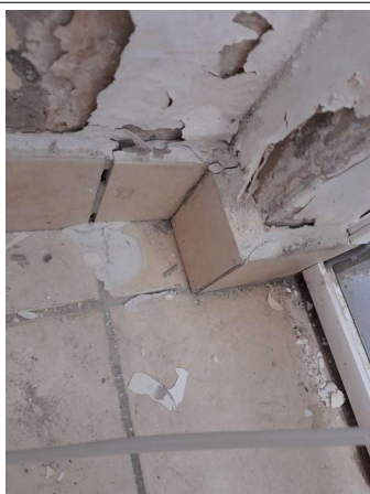
Prélèvement - P322 : COUR D'APPEL / R+0 / Pièce 62 - Colle de plinthe- (Absence d'amiante)
