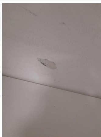
Prélèvement - P178 : COUR D'APPEL / R+1 / Pièce 31 - Enduit - (Présence d'amiante)
