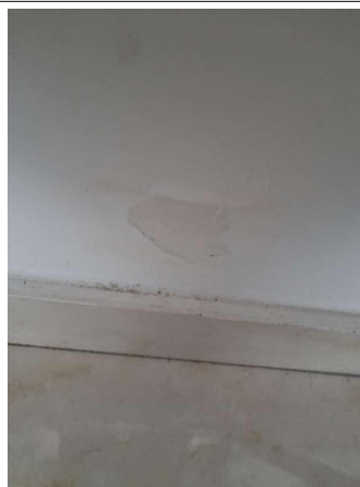
Prélèvement - P224 : COUR D'APPEL / R+1 / Pièce 41 - Enduit - (Présence d'amiante)
