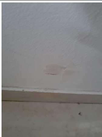
Prélèvement - P223 : COUR D'APPEL / R+1 / Pièce 41 - Enduit - (Présence d'amiante)
