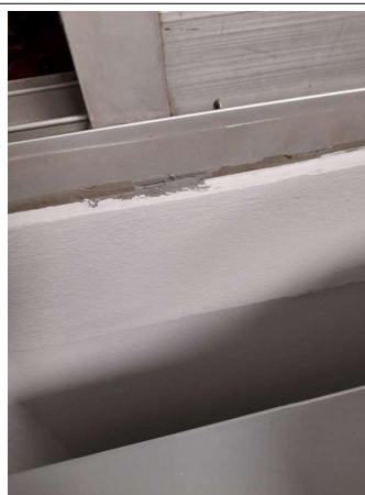
Prélèvement - P270 : COUR D'APPEL / R+1 / Pièce 50 - Joint- (Absence d'amiante)
