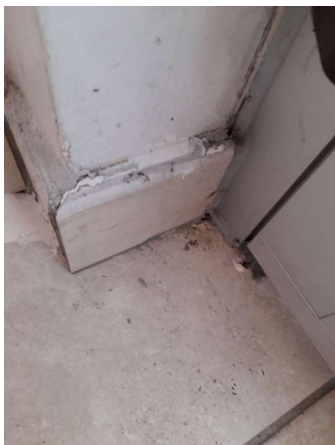
Prélèvement - P132 : COUR D'APPEL / R+0 / Pièce 26 - Colle de plinthe- (Absence d'amiante)
