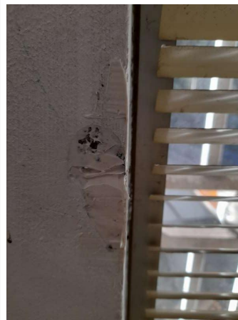
Prélèvement - P129 : COUR D'APPEL / R+0 / Pièce 25 - Enduit - (Présence d'amiante)
