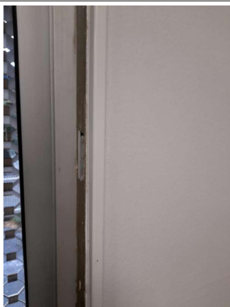
Prélèvement - P285 : COUR D'APPEL / R+1 / Pièce 53 - Joint- (Présence d'amiante)
