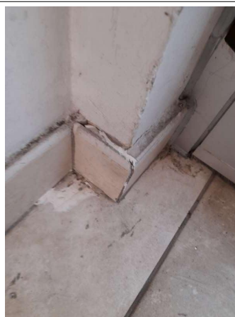
Prélèvement - P127 : COUR D'APPEL / R+0 / Pièce 25 - Colle de plinthe- (Présence d'amiante)
