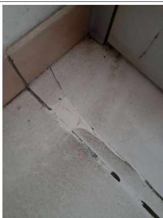
Prélèvement - P051 : COUR D'APPEL / R+0 / Pièce 11 - Colle de carrelage- (Absence d'amiante)
