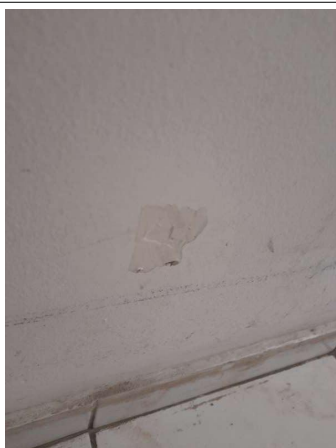
Prélèvement - P023 : COUR D'APPEL / R+0 / Pièce 05 - Enduit - (Présence d'amiante)
