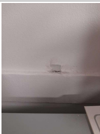
Prélèvement - P269 : COUR D'APPEL / R+1 / Pièce 50 - Enduit - (Présence d'amiante)
