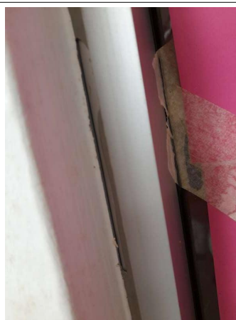
Prélèvement - P040 : COUR D'APPEL / R+0 / Pièce 08 - Joint- (Absence d'amiante)
