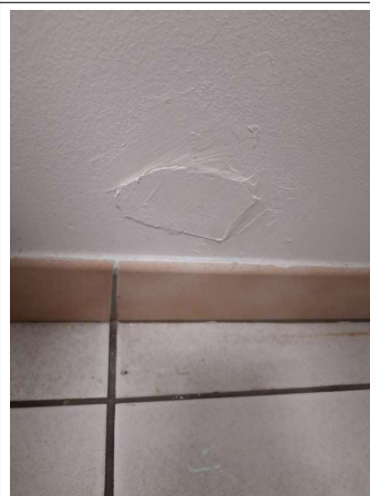
Prélèvement - P078 : COUR D'APPEL / R+0 / Pièce 16 - Enduit - (Absence d'amiante)
