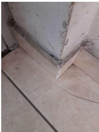
Prélèvement - P297 : COUR D'APPEL / R+1 / Pièce 56 - Colle de plinthe- (Absence d'amiante)
