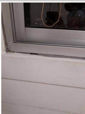
Prélèvement - P320 : COUR D'APPEL / R+1 / Pièce 60 - Joint- (Absence d'amiante)
