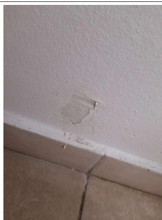
Prélèvement - P028 : COUR D'APPEL / R+0 / Pièce 06 - Enduit - (Présence d'amiante)
