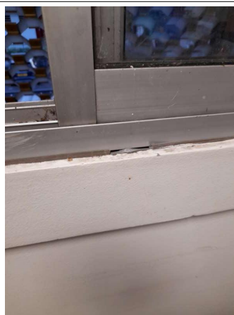
Prélèvement - P260 : COUR D'APPEL / R+1 / Pièce 48 - Joint- (Absence d'amiante)
