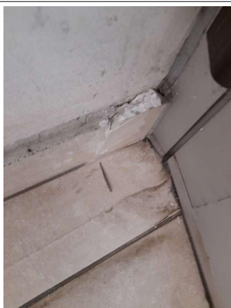
Prélèvement - P017 : COUR D'APPEL / R+0 / Pièce 04 - Colle de plinthe- (Présence d'amiante)
