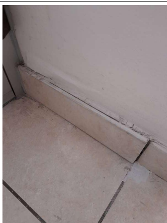
Prélèvement - P257 : COUR D'APPEL / R+1 / Pièce 48 - Colle de plinthe- (Absence d'amiante)
