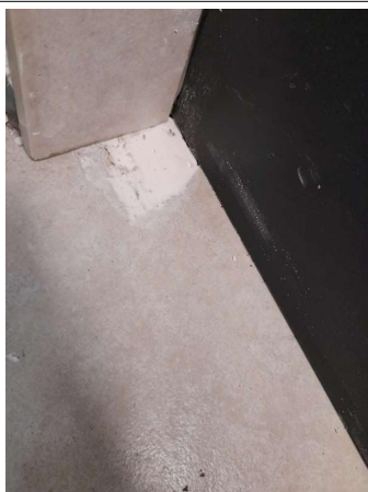
Prélèvement - P116 : COUR D'APPEL / R+0 / Pièce 24 - Colle de carrelage- (Absence d'amiante)
