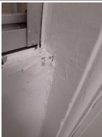
Prélèvement - P079 : COUR D'APPEL / R+0 / Pièce 16 - Enduit - (Absence d'amiante)
