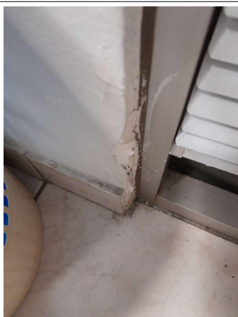
Prélèvement - P089 : COUR D'APPEL / R+0 / Pièce 18 - Enduit - (Présence d'amiante)
