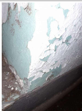
Prélèvement - P112 : COUR D'APPEL / R+0 / Patio 02 - Enduit- (Absence d'amiante)
