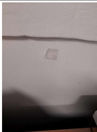
Prélèvement - P164 : COUR D'APPEL / R+1 / Pièce 28 - Enduit - (Présence d'amiante)
