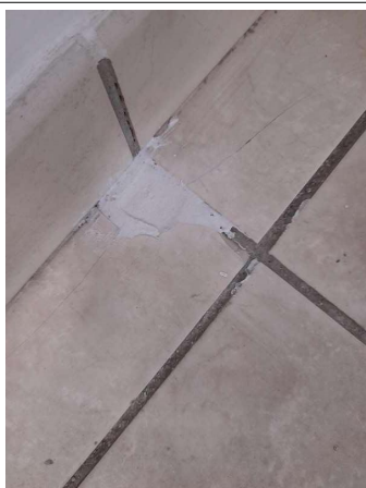
Prélèvement - P271 : COUR D'APPEL / R+1 / Pièce 51 - Colle de carrelage- (Absence d'amiante)
