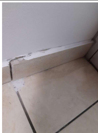
Prélèvement - P262 : COUR D'APPEL / R+1 / Pièce 49 - Colle de plinthe- (Présence d'amiante)
