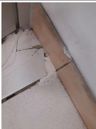
Prélèvement - P061 : COUR D'APPEL / R+0 / Pièce 13 - Colle de carrelage- (Absence d'amiante)
