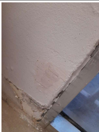
Prélèvement - P109 : COUR D'APPEL / R+0 / Pièce 22 - Enduit - (Présence d'amiante)
