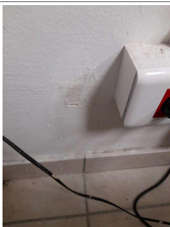
Prélèvement - P033 : COUR D'APPEL / R+0 / Pièce 07 - Enduit - (Présence d'amiante)
