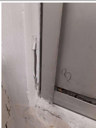
Prélèvement - P065 : COUR D'APPEL / R+0 / Pièce 13 - Joint- (Absence d'amiante)
