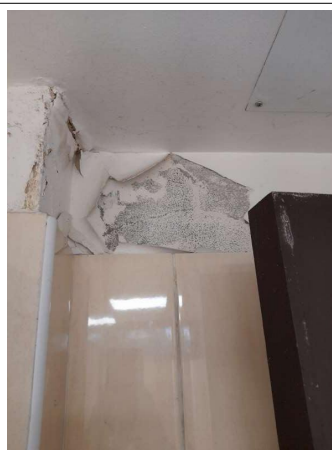
Prélèvement - P344 : COUR D'APPEL / R+1 / Sanitaire - Enduit - (Présence d'amiante)
