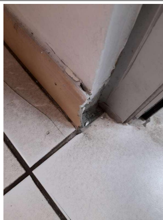
Prélèvement - P062 : COUR D'APPEL / R+0 / Pièce 13 - Colle de plinthe- (Absence d'amiante)
