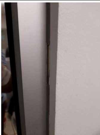
Prélèvement - P330 : COUR D'APPEL / R+0 / Pièce 63 - Joint- (Absence d'amiante)
