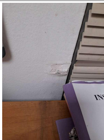
Prélèvement - P084 : COUR D'APPEL / R+0 / Pièce 17 - Enduit - (Présence d'amiante)
