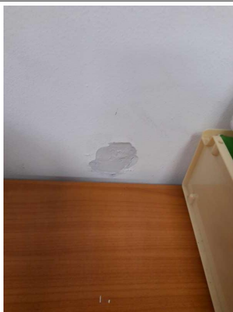
Prélèvement - P279 : COUR D'APPEL / R+1 / Pièce 52 - Enduit - (Présence d'amiante)
