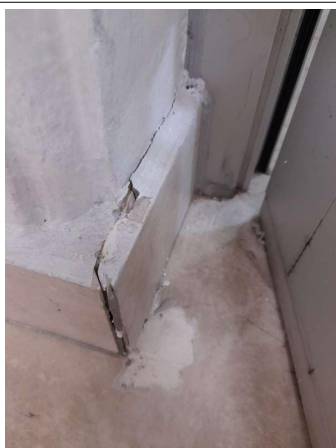
Prélèvement - P227 : COUR D'APPEL / R+1 / Pièce 42 - Colle de plinthe- (Absence d'amiante)
