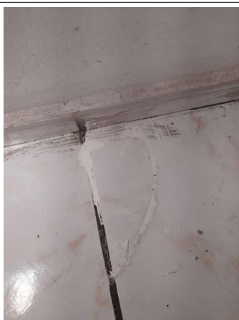
Prélèvement - P081 : COUR D'APPEL / R+0 / Pièce 17 - Colle de carrelage- (Absence d'amiante)
