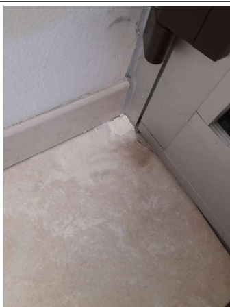
Prélèvement - P161 : COUR D'APPEL / R+1 / Pièce 28 - Colle de carrelage- (Absence d'amiante)
