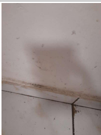
Prélèvement - P093 : COUR D'APPEL / R+0 / Pièce 19 - Enduit - (Présence d'amiante)
