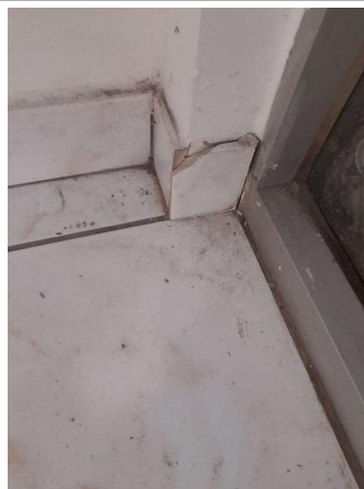
Prélèvement - P002 : COUR D'APPEL / R+0 / Pièce 01 - Colle de plinthe- (Absence d'amiante)
