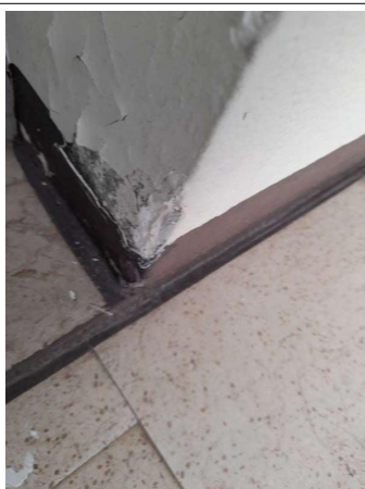
Prélèvement - P143 : COUR D'APPEL / R+1 / Coursives - Enduit- (Présence d'amiante)
