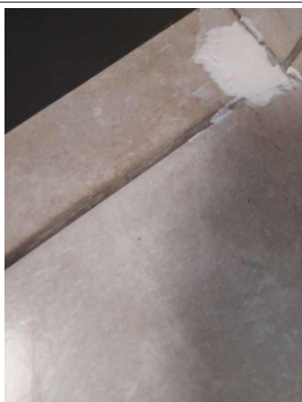
Prélèvement - P011 : COUR D'APPEL / R+0 / Pièce 03 - Colle de carrelage- (Présence d'amiante)
