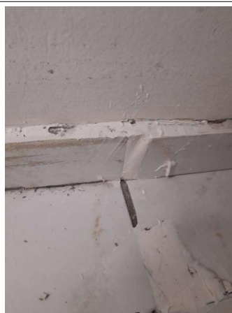
Prélèvement - P072 : COUR D'APPEL / R+0 / Pièce 15 - Colle de plinthe- (Présence d'amiante)
