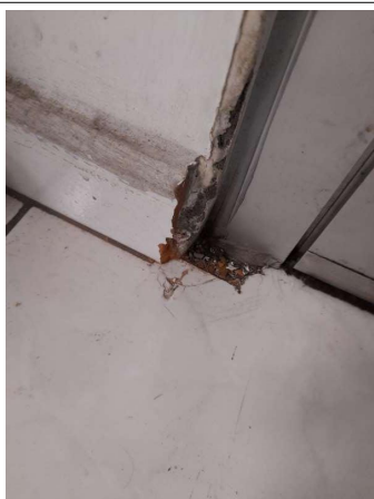
Prélèvement - P167 : COUR D'APPEL / R+1 / Pièce 29 - Colle de plinthe- (Absence d'amiante)
