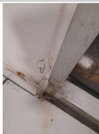
Prélèvement - P094 : COUR D'APPEL / R+0 / Pièce 19 - Enduit - (Présence d'amiante)
