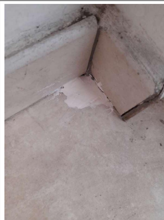
Prélèvement - P131 : COUR D'APPEL / R+0 / Pièce 26 - Colle de carrelage- (Absence d'amiante)
