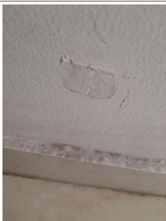
Prélèvement - P138 : COUR D'APPEL / R+0 / Pièce 27 - Enduit - (Présence d'amiante)
