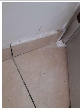
Prélèvement - P232 : COUR D'APPEL / R+1 / Pièce 43 - Colle de plinthe- (Présence d'amiante)
