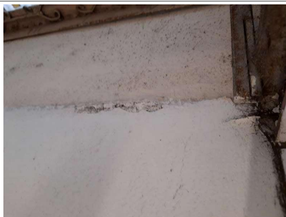
Prélèvement - P346 : COUR D'APPEL / R+0 / Sanitaire - Enduit - (Présence d'amiante)
