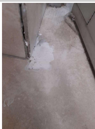
Prélèvement - P226 : COUR D'APPEL / R+1 / Pièce 42 - Colle de carrelage- (Présence d'amiante)
