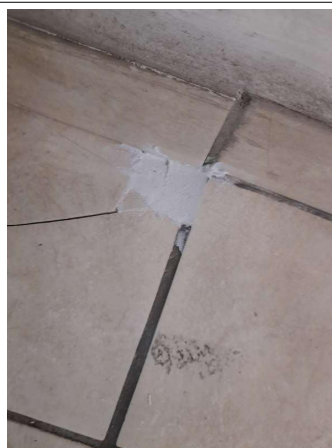
Prélèvement - P296 : COUR D'APPEL / R+1 / Pièce 56 - Colle de carrelage- (Absence d'amiante)
