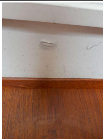
Prélèvement - P319 : COUR D'APPEL / R+1 / Pièce 60 - Enduit - (Présence d'amiante)
