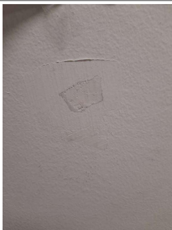
Prélèvement - P013 : COUR D'APPEL / R+0 / Pièce 03 - Enduit - (Présence d'amiante)
