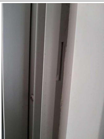
Prélèvement - P225 : COUR D'APPEL / R+1 / Pièce 41 - Joint- (Absence d'amiante)
