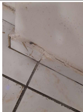
Prélèvement - P092 : COUR D'APPEL / R+0 / Pièce 19 - Colle de plinthe- (Présence d'amiante)
