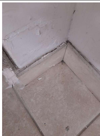
Prélèvement - P032 : COUR D'APPEL / R+0 / Pièce 07 - Colle de plinthe- (Présence d'amiante)
