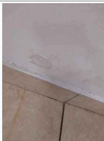
Prélèvement - P238 : COUR D'APPEL / R+1 / Pièce 44 - Enduit - (Présence d'amiante)
