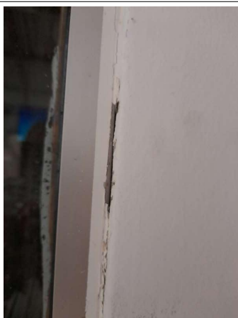
Prélèvement - P120 : COUR D'APPEL / R+0 / Pièce 24 - Joint- (Absence d'amiante)
