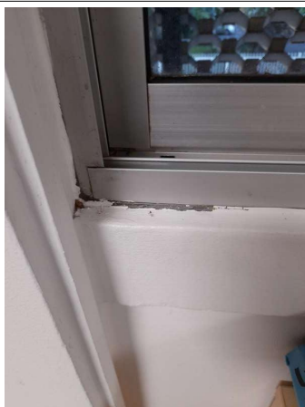
Prélèvement - P175 : COUR D'APPEL / R+1 / Pièce 30 - Joint- (Absence d'amiante)
