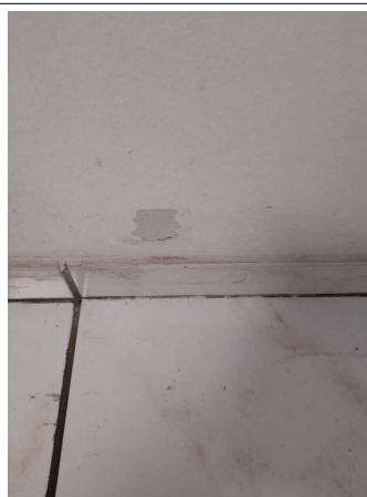
Prélèvement - P288 : COUR D'APPEL / R+1 / Pièce 54 - Enduit - (Absence d'amiante)
