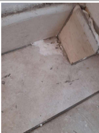
Prélèvement - P126 : COUR D'APPEL / R+0 / Pièce 25 - Colle de carrelage- (Absence d'amiante)
