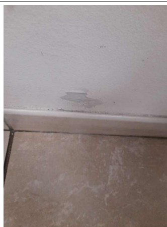
Prélèvement - P294 : COUR D'APPEL / R+1 / Pièce 55 - Enduit - (Présence d'amiante)
