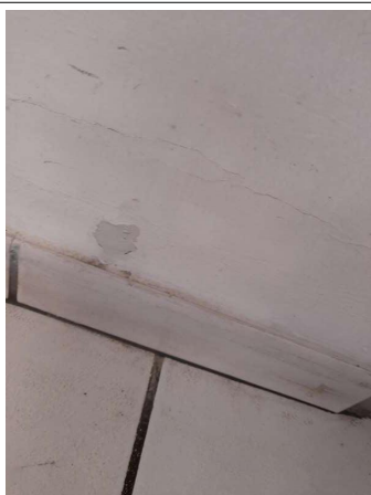
Prélèvement - P283 : COUR D'APPEL / R+1 / Pièce 53 - Enduit - (Présence d'amiante)
