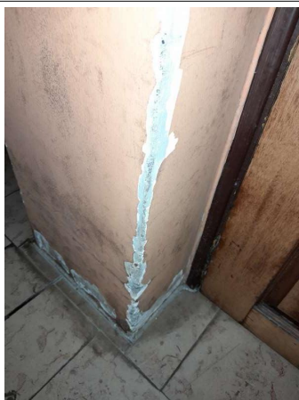
Prélèvement - P341 : COUR D'APPEL / R+1 / Pièce 68 - Enduit - (Présence d'amiante)
