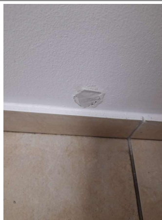
Prélèvement - P268 : COUR D'APPEL / R+1 / Pièce 50 - Enduit - (Présence d'amiante)
