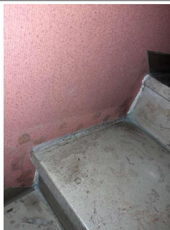
Prélèvement - P342 : COUR D'APPEL / R+1 / Pièce 68 - Colle de plinthe- (Absence d'amiante)
