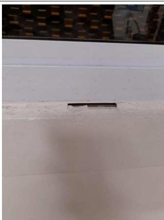
Prélèvement - P245 : COUR D'APPEL / R+1 / Pièce 45 - Joint- (Absence d'amiante)
