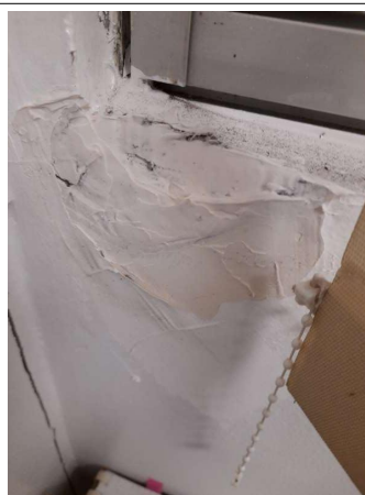
Prélèvement - P064 : COUR D'APPEL / R+0 / Pièce 13 - Enduit - (Absence d'amiante)
