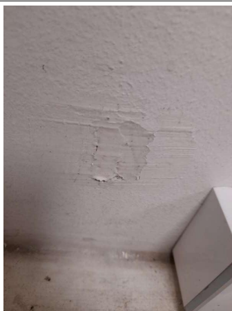
Prélèvement - P049 : COUR D'APPEL / R+0 / Pièce 10 - Enduit - (Présence d'amiante)
