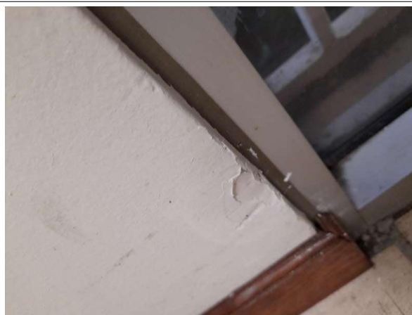
Prélèvement - P114 : COUR D'APPEL / R+0 / Pièce 23 - Enduit - (Présence d'amiante)
