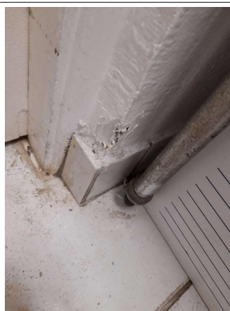
Prélèvement - P333 : COUR D'APPEL / R+0 / Pièce 64 - Enduit - (Absence d'amiante)
