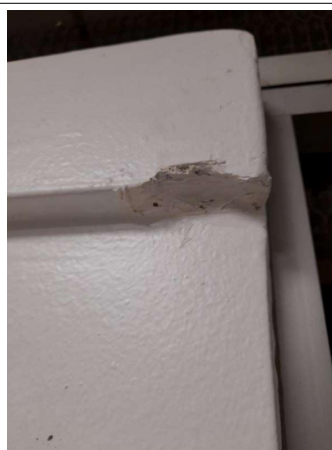
Prélèvement - P034 : COUR D'APPEL / R+0 / Pièce 07 - Enduit - (Présence d'amiante)
