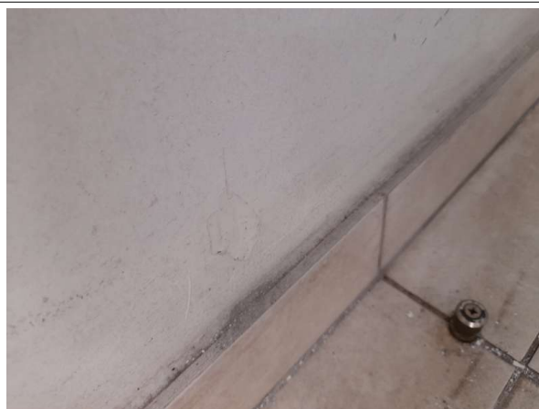
Prélèvement - P018 : COUR D'APPEL / R+0 / Pièce 04 - Enduit - (Présence d'amiante)
