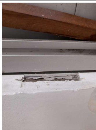
Prélèvement - P060 : COUR D'APPEL / R+0 / Pièce 12 - Joint- (Absence d'amiante)
