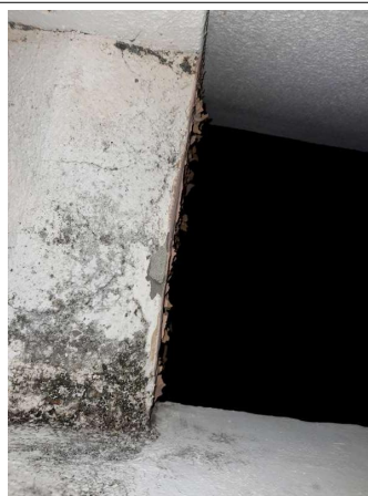
Prélèvement - P154 : COUR D'APPEL / Extérieur / Toiture - Enduit- (Présence d'amiante)
