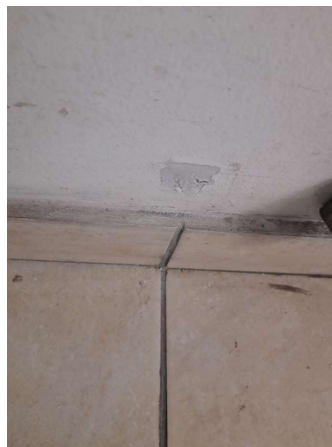
Prélèvement - P298 : COUR D'APPEL / R+1 / Pièce 56 - Enduit - (Présence d'amiante)
