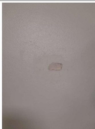
Prélèvement - P108 : COUR D'APPEL / R+0 / Pièce 22 - Enduit - (Présence d'amiante)
