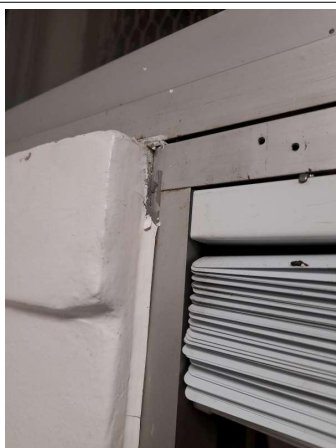
Prélèvement - P095 : COUR D'APPEL / R+0 / Pièce 19 - Joint- (Présence d'amiante)
