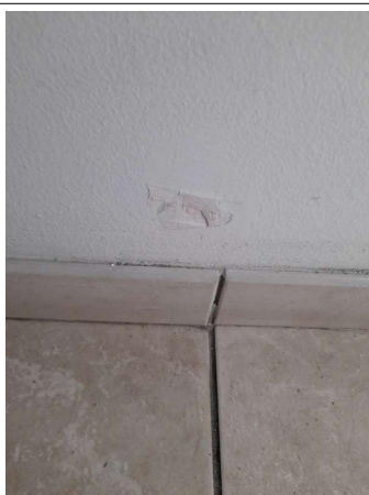
Prélèvement - P213 : COUR D'APPEL / R+1 / Pièce 39 - Enduit - (Présence d'amiante)
