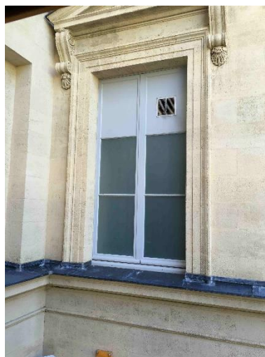
Grille de rejet de la VMC à remplacer
