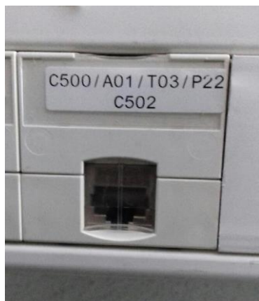
Figure 12 : Plastron d'une prise RJ45 avec Volet et étiquetage conforme.
