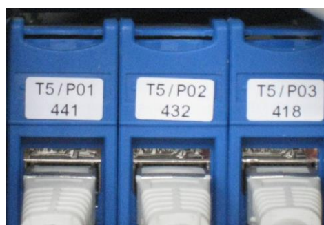
Figure 11 : Etiquette sur noyau prise utilisateur Local Technique
