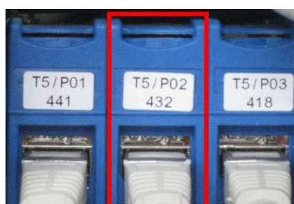
Figure 6 : Plastron individuel démontable par l'avant du bandeau de brassage
