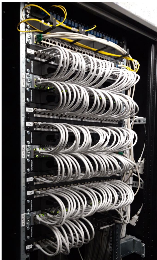
Figure 10 : Armoire de brassage dans le respect des procédures demandées. A noter que les commutateurs du réseau capillaire seront interconnectés avec un lien Uplink en DAC 10G au Commutateur d'Entrée (CE).
