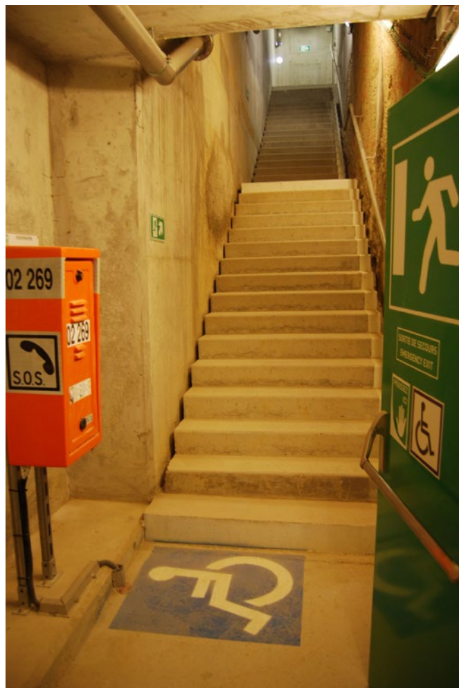
Figure 33 : exemple d'aménagement d'un espace attente PMR sécurisé d'une issue existante dans le cadre d'un programme de rénovation
