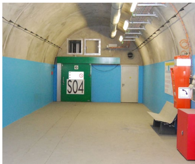
Figure 20 : tunnel du Fréjus, seconde porte du sas de type coulissante
