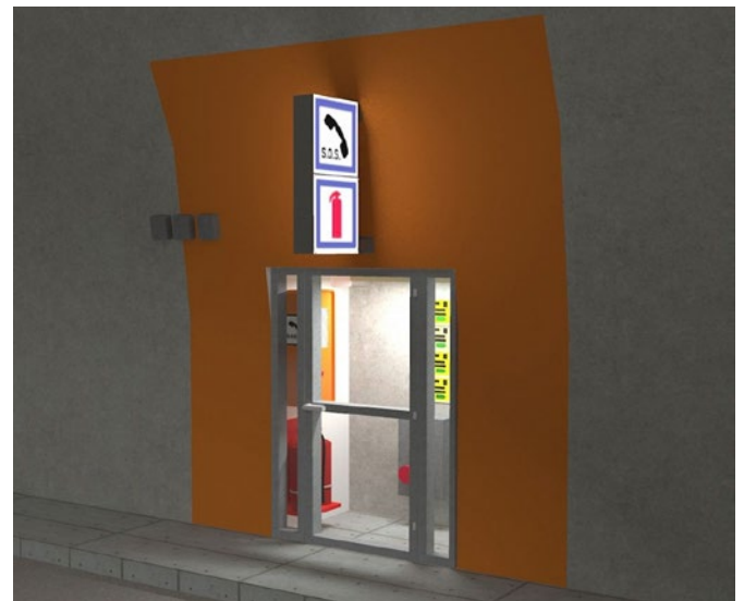
Figure 12 : aménagement d'une niche de sécurité en section courante avec porte
