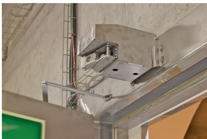
Figure 19 : dispositif d'aide à l'ouverture de porte (position ouverte)
