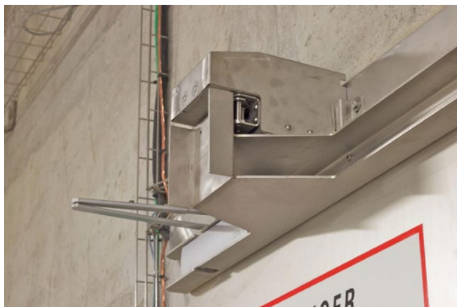
Figure 18 : dispositif d'aide à l'ouverture de porte (position fermée)
