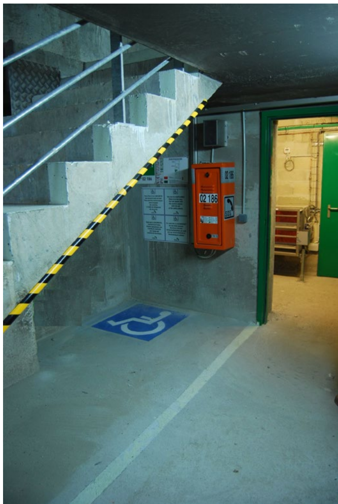
Figure 31 : espace d'attente sécurisé pour une issue de secours débouchant vers l'extérieur avec escalier
