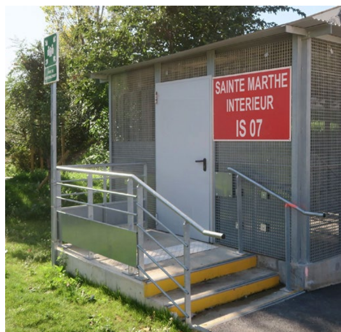
Figure 34 : exemple d'aménagement d'escalier au débouché d'issue de secours
