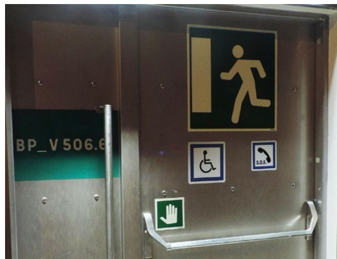
Figure 16 : éléments de signalisation sur la porte de l'issue de secours
