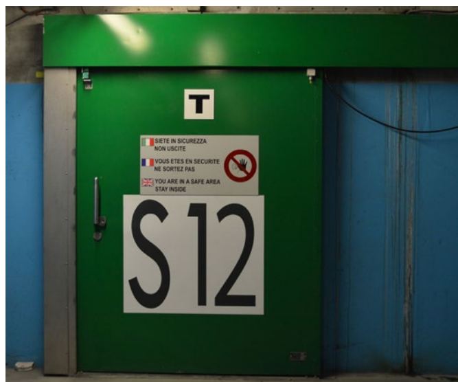
Figure 20 : tunnel du Fréjus, seconde porte du sas de type coulissante
