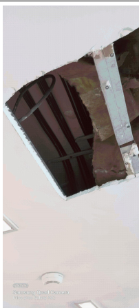
Prélèvement - P072 : Niveau 2/3 / Combles A1 / Plateau de bureau - Enduit- (Absence d'amiante)
