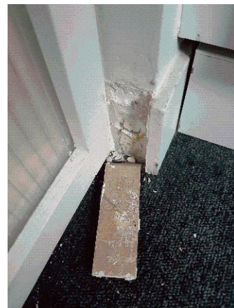
Prélèvement - P013 : Niveau 2/3 / Combles A1 / Plateau de bureau - Colle de plinthe- (Absence d'amiante)
