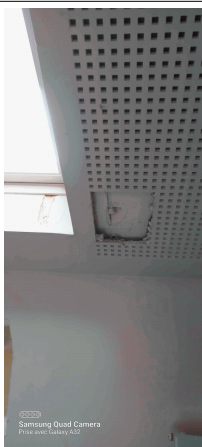
Prélèvement - P057 : Niveau 2/3 / Combles A1 / Bureau 1 - Enduit- (Absence d'amiante)
