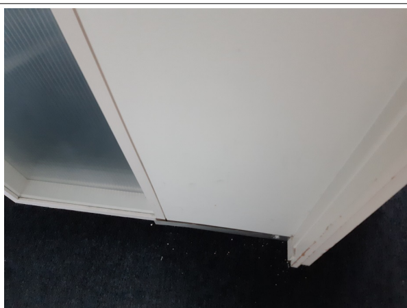
Prélèvement - P035 : Niveau 4/5 / Combles C2 / Plateau de bureau - Colle de plinthe- (Absence d'amiante)
