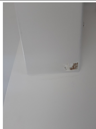
Prélèvement - P027 : Niveau 2/3 / Combles A1 / Réserve - Enduit- (Absence d'amiante)
