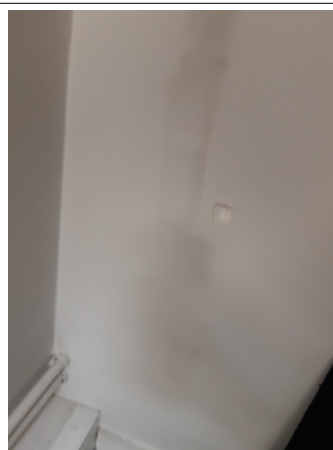
Prélèvement - P023 : Niveau 2/3 / Combles A1 / Plateau de bureau - Enduit- (Absence d'amiante)
