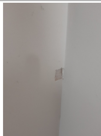
Prélèvement - P025 : Niveau 2/3 / Combles A1 / Réserve - Enduit- (Absence d'amiante)
