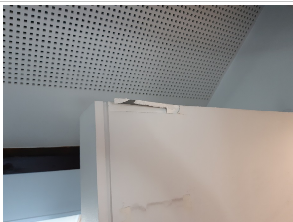
Prélèvement - P037 : Niveau 4/5 / Combles C2 / Plateau de bureau - Bande de plaque de plâtre- (Absence d'amiante)
