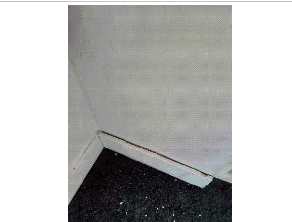
Prélèvement - P038 : Niveau 4/5 / Combles C2 / Plateau de bureau - Colle de plinthe- (Absence d'amiante)
