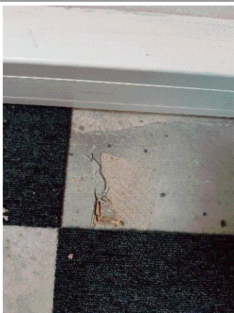
Prélèvement - P020 : Niveau 2/3 / Combles A1 / Plateau de bureau - Ragréage- (Absence d'amiante)
