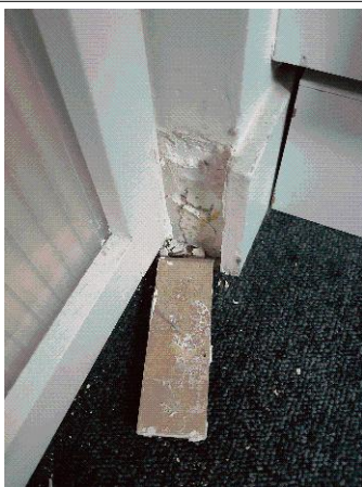
Prélèvement - P014 : Niveau 2/3 / Combles A1 / Plateau de bureau - Bande de plaque de plâtre- (Absence d'amiante)
