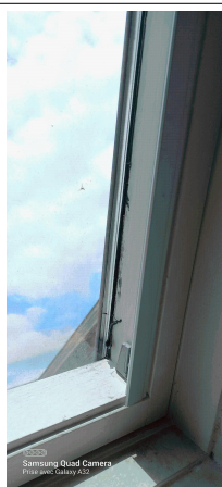
Prélèvement - P067 : Niveau 2/3 / Combles A1 / Plateau de bureau - Joint- (Absence d'amiante)
