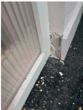
Prélèvement - P012 : Niveau 2/3 / Combles A1 / Plateau de bureau - Bande de plaque de plâtre- (Absence d'amiante)
