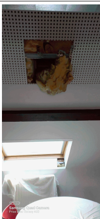
Prélèvement - P055 : Niveau 4/5 / Combles C2 / Plateau de bureau - Isolant- (Absence d'amiante)
