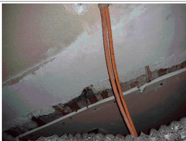
Prélèvement - P049 : Niveau 2/3 / Combles A1 / Sas - Enduit- (Absence d'amiante)
