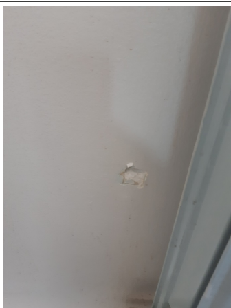
Prélèvement - P024 : Niveau 2/3 / Combles A1 / Plateau de bureau - Enduit- (Absence d'amiante)
