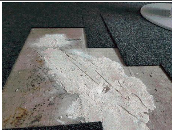
Prélèvement - P033 : Niveau 4/5 / Combles C2 / Bureau 1 - Enduit- (Absence d'amiante)
