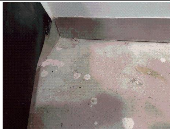
Prélèvement - P046 : Niveau 2/3 / Palier d'ascenseur - Colle, Ragréage- (Absence d'amiante)
