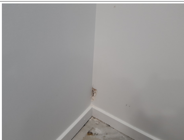
Prélèvement - P031 : Niveau 4/5 / Palier d'ascenseur - Plaque, Bande de plaque de plâtre- (Absence d'amiante)
