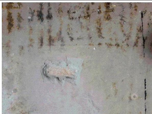
Prélèvement - P001 : Niveau 2/3 / Combles A1 / Bureau 1 - Colle- (Absence d'amiante)
