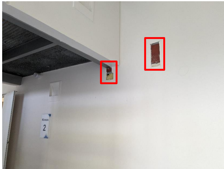
8) Localisation des sondages réalisées dans la cloison à ouvrir
