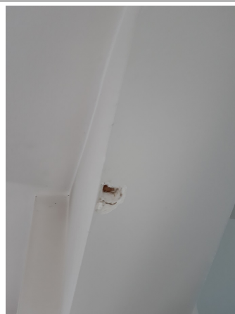
Prélèvement - P015 : Niveau 2/3 / Combles A1 / Plateau de bureau - Enduit- (Absence d'amiante)
