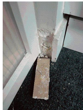
Prélèvement - P013 : Niveau 2/3 / Combles A1 / Plateau de bureau - Colle de plinthe- (Absence d'amiante)
