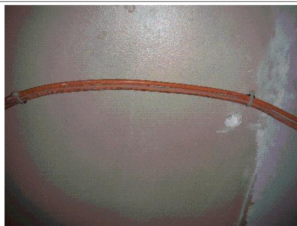
Prélèvement - P048 : Niveau 2/3 / Combles A1 / Sas - Enduit- (Absence d'amiante)
