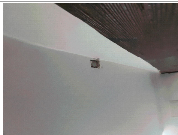
Prélèvement - P043 : Niveau 4/5 / Combles C2 / Plateau de bureau - Plaque, Bande de plaque de plâtre- (Absence d'amiante)
