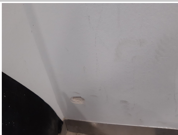
Prélèvement - P047 : Niveau 2/3 / Palier d'ascenseur - Enduit- (Absence d'amiante)
