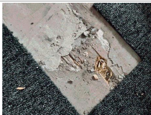
Prélèvement - P032 : Niveau 4/5 / Combles C2 / Bureau 1 - Colle, Ragréage- (Absence d'amiante)
