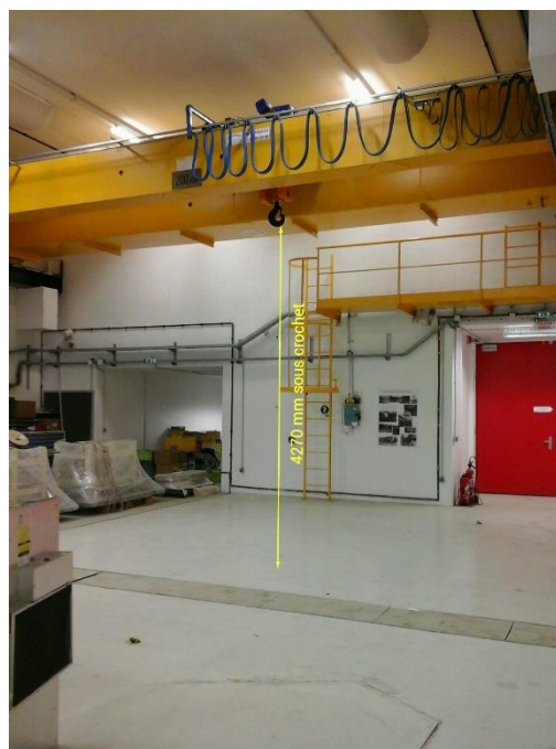
Figure 14 : Photo du pont en HE0 et hauteur sous crochet maximale.
