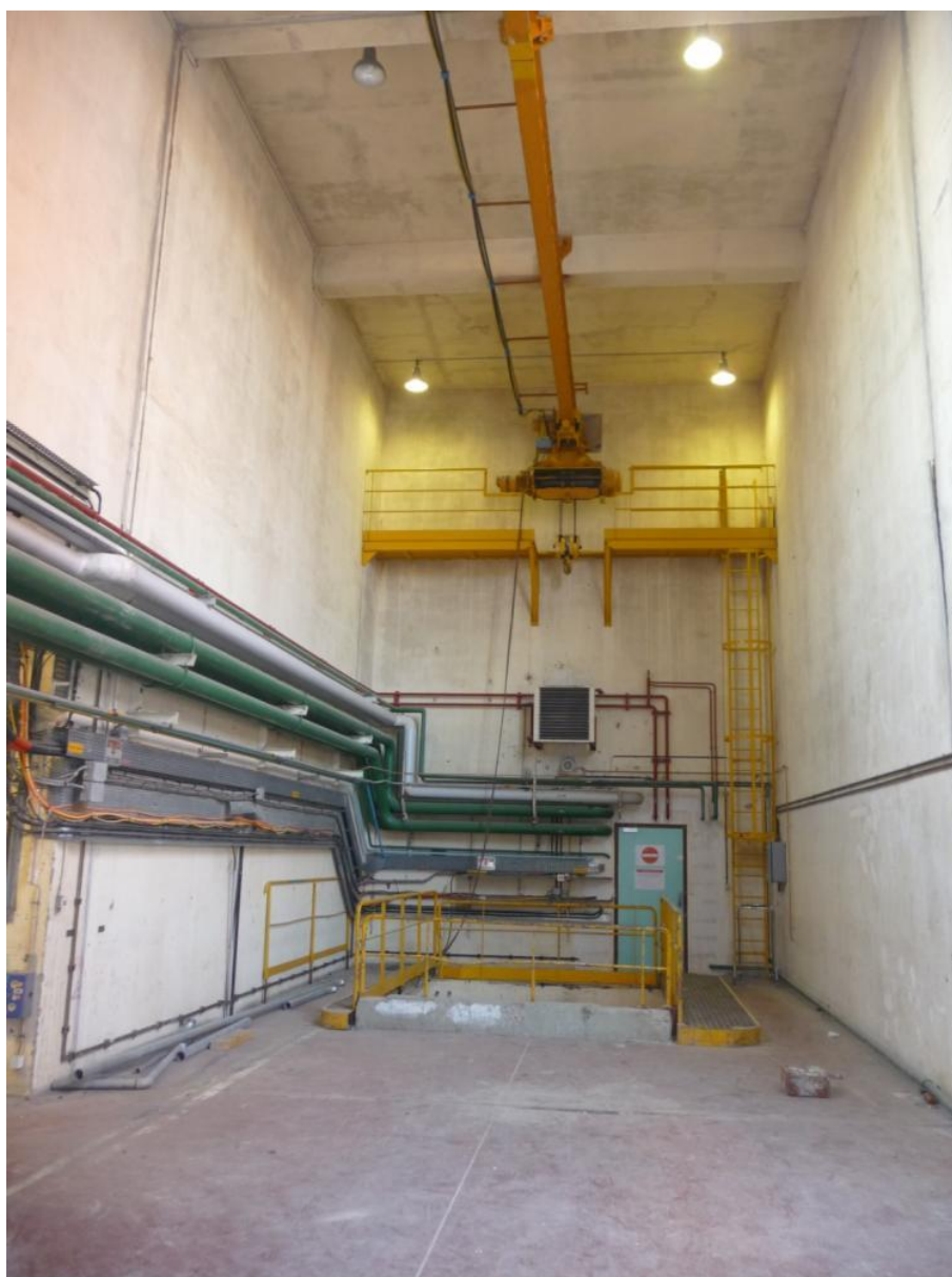
Figure 7 : Vue du Monorail du 707 et de la zone de manutention, CMU 6 [tonnes].
