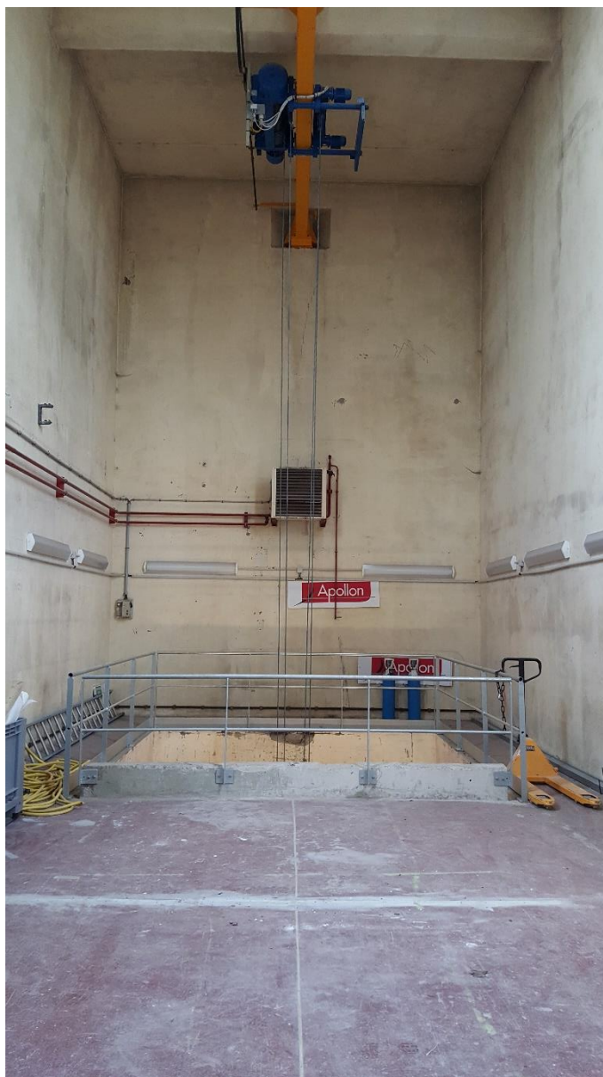
Figure 24 : Vue du Monorail du 708 et de la zone de manutention, CMU 7 [tonnes].
