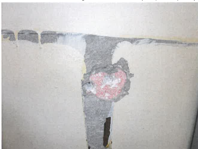
Composant : Panneaux rigides (cloisons, gaines, plafonds) 5 (a) Panneaux rigides en fibrociment des murs et cloisons. Extérieur et intérieur de l'ensemble des murs et cloisons principales des halls (voir plan et photo)
