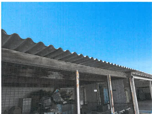
Composant : Plaques ondulées en toiture 1 (N) Plaques ondulées en fibrociment en toiture Toiture appentis de stockage extérieur (voir plan et photo).
