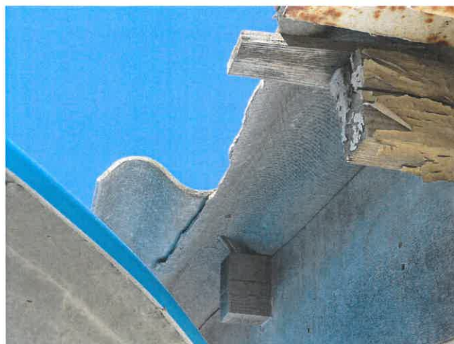
Composant : Plaques ondulées en toiture 2 (N) Plaques ondulées en fibrociment en toiture endommagées. Toiture du hall 1 (voir plan et photo).
