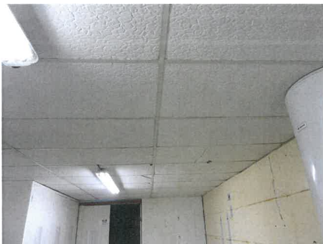
Composant : Faux plafond 4 (N) Dalles de faux plafond rigides blanches à motifs en relief 50 x 100. Plafond des labos algues et local entrée (voir plan et photo).
