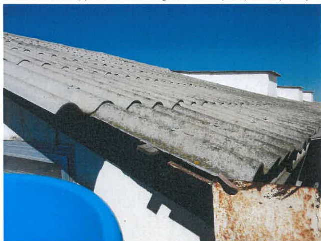
Composant : Plaques ondulées en toiture 3 (N) Plaques ondulées en fibrociment en toiture en bon état. Toiture du hall 1 (voir plan et photo).
