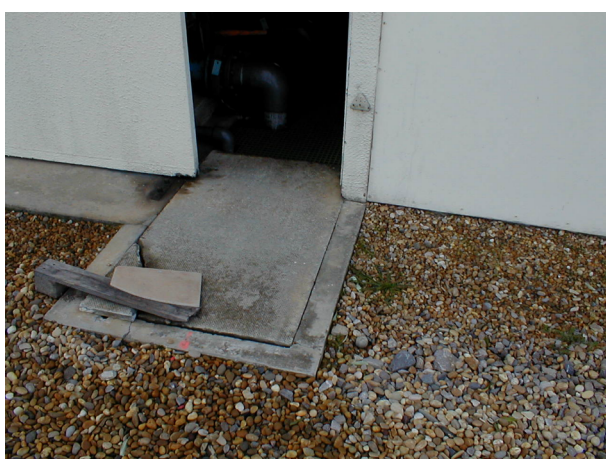
Rebouchages de trémies Plaques en fibrociment sur caniveau extérieur
