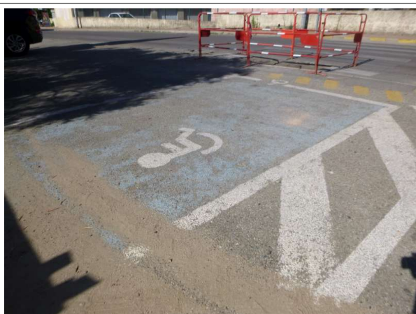
Prélèvement - P005 : EXTERIEUR - Enrobé bitumineux- (Absence d'amiante)
