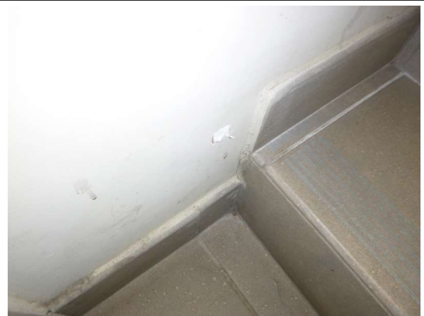
Prélèvement - P010 : RDJ / ESCALIER - Enduit- (Absence d'amiante)
