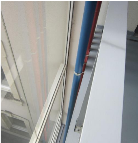
Simple vitrage Conduites de chauffage non isolées
