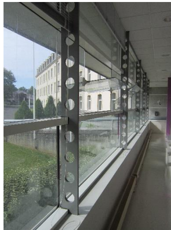
Double vitrage de première génération (lame d'air de faible épaisseur, sans basse émissivité), parfois simple vitrage
