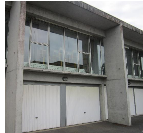
Vitrages toute hauteur orientés Ouest Radiateur devant le vitrage Ponts thermiques liés aux dalles
