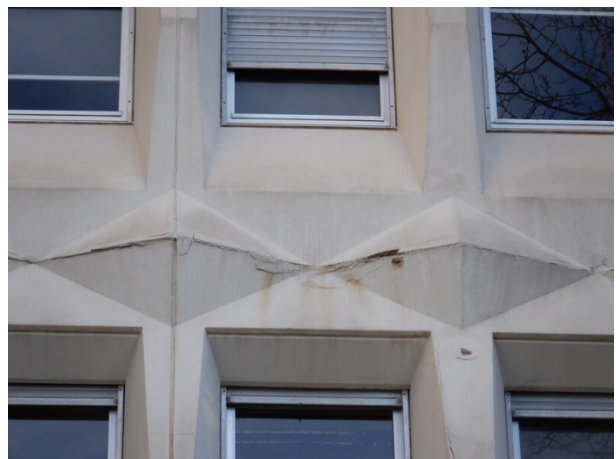
Vue rapprochée d'une fissure avec coulure
