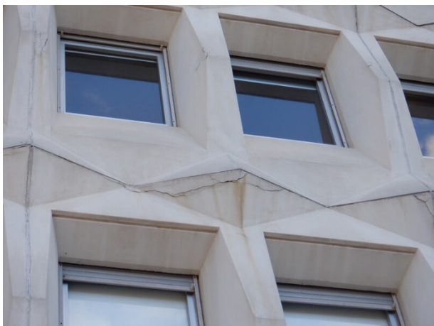
Vue rapprochée d'une fissure avec coulure
