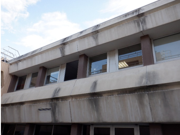
Vue rapprochée des traces de coulure
