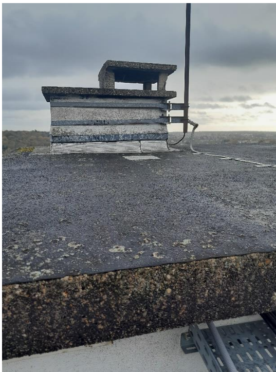
Figure 14 : Toiture terrasse des garages : toiture terrasse avec protection en dalles gravillonnées.
