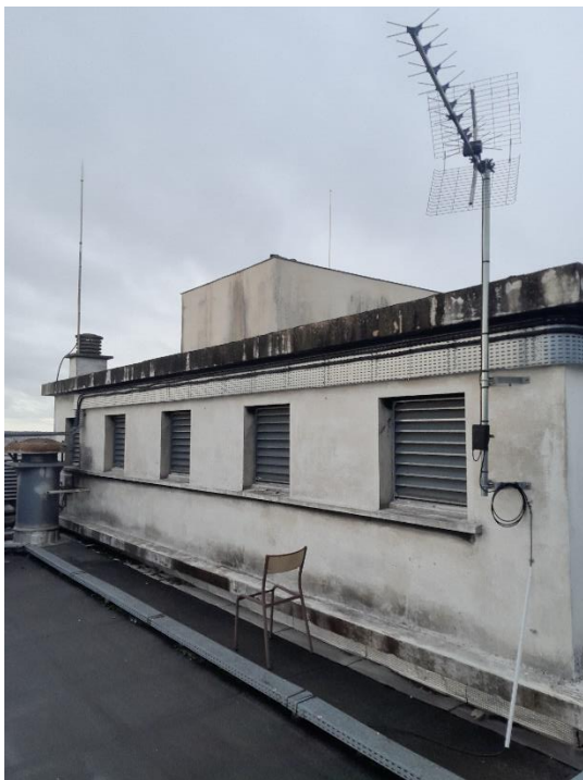
Figure 14 : Toiture terrasse des garages : toiture terrasse avec protection en dalles gravillonnées.
