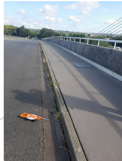
Exemple de linéaire de joints à reprendre
