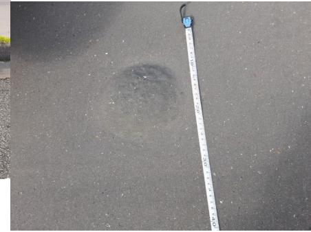
Exemple de boursofflure
