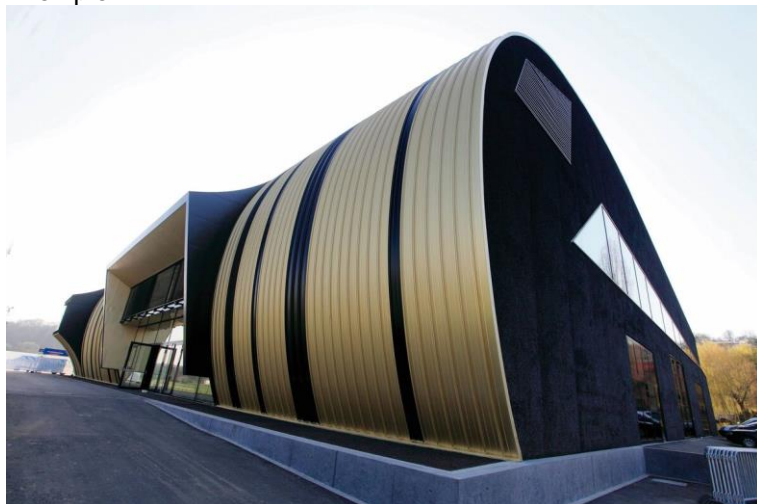
Bac aluminium isolant KALZIP à joint debout (© Doc. Architecte Besch Da Costa)
