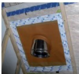
Pièce d'étanchéité autour d'un conduit
