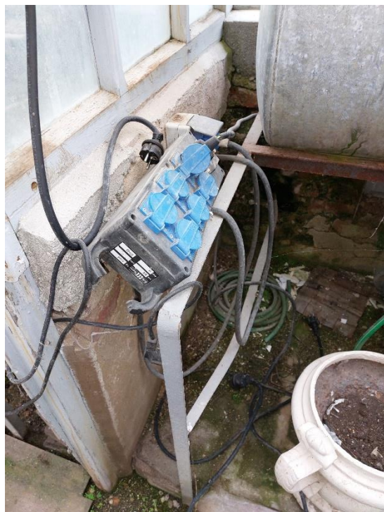
Installation électrique à reprendre
