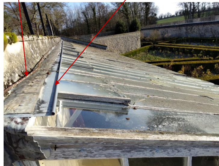
Couvertines zinc et plomb pour protection au faitage Tringle
