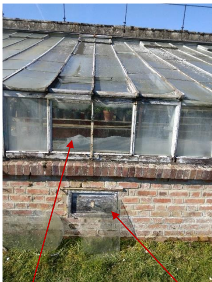
Châssis ouvrant métallique Châssis ouvrant bois dans mur bahut À restaurer
