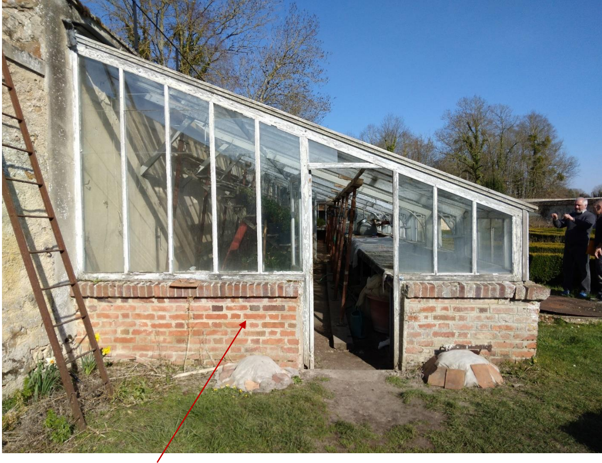
Mur bahut en briques à restaurer, aux 2 faces, toute périphérie et couronnement
