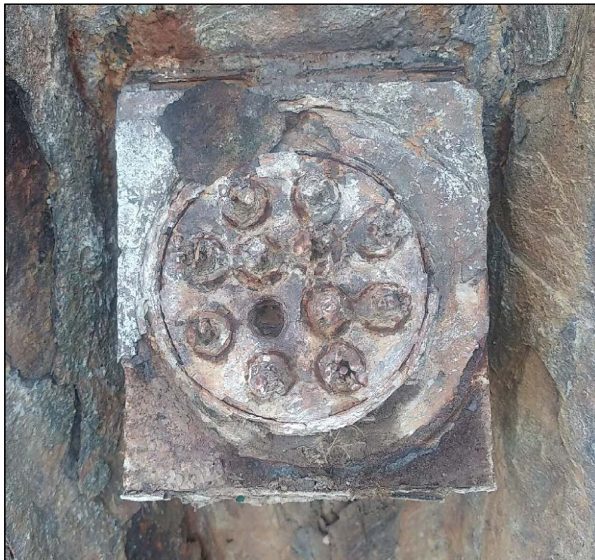
Figure 15 – Tête de tirant, câble très dégradée, (source n°7)
