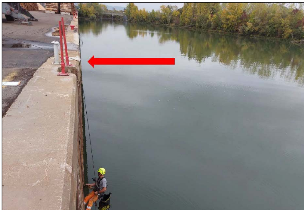
Figure 14 – Rideau de palplanche et niveau de sa déformation indiqué par la flèche rouge (source n°7)
