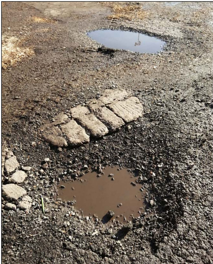
Figure 13 – Photo du site d'étude : nid de poule et dégradation de la chaussée.
