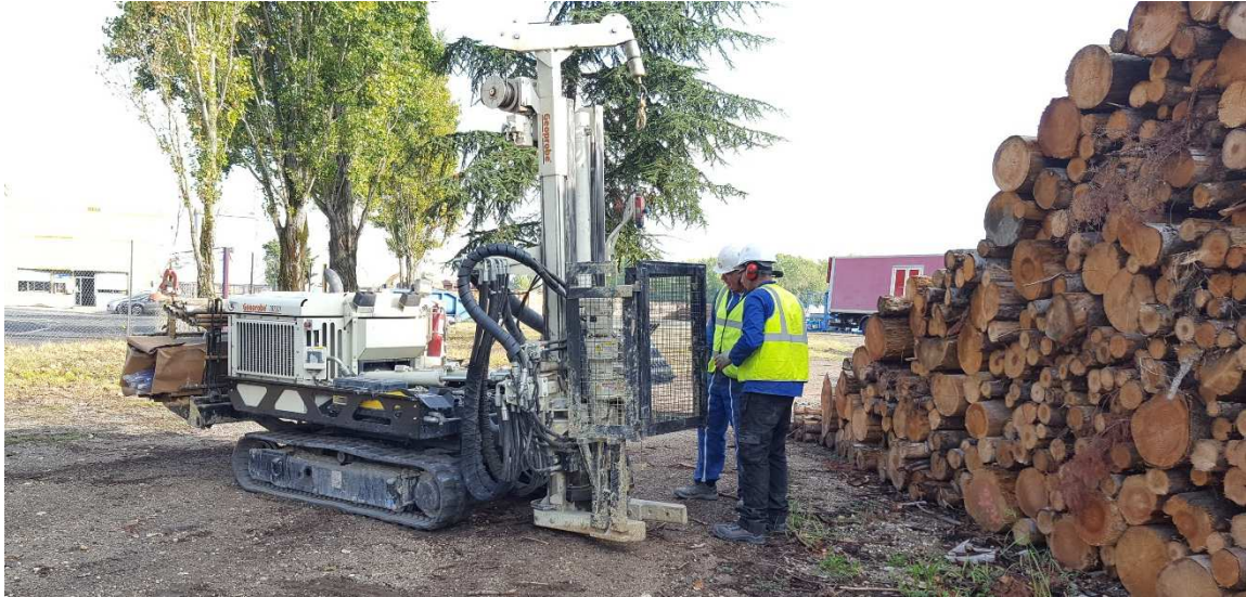
Figure 11 : Réalisation d'un sondage à la Geoprobe
