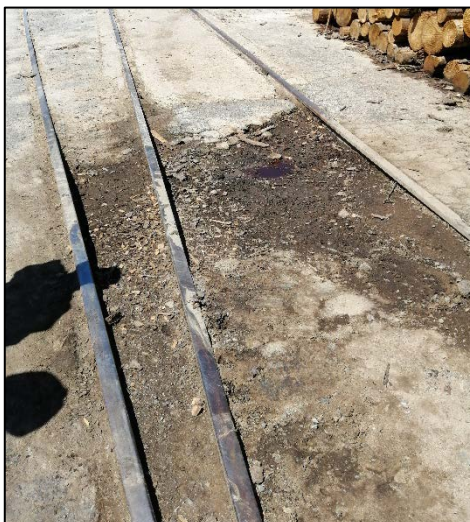
Figure 17 - Plateforme ferroviaire - couche de surface détériorée
