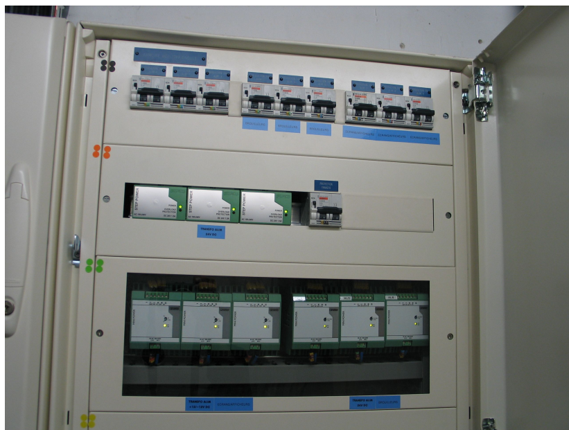
Figure 1 – Solution plastron transparent sur équipements fixés en fond d'armoire
