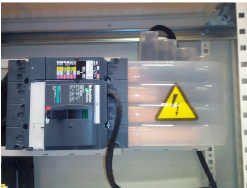
Figure 1bis – Dispositifs de protection transparente de forme 4 sur queues de barres
