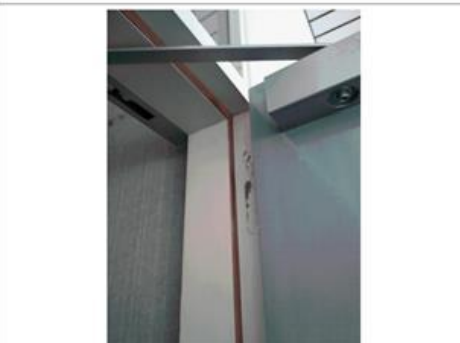
Prélèvement - P005 : R+2 / AILE B / CIRCULATION 2 - Joint- (Absence d'amiante)
