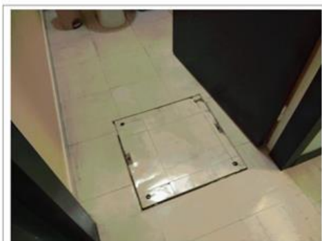
Prélèvement - P017 : RDC / AILE C / LOGEMENT 2 - Dalle de sol - EP- (Présence d'amiante)
