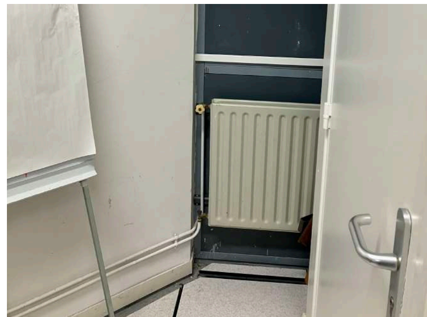
Création d'une porte d'accès au local SSI depuis la rue et déplacement du radiateur vers le local de repos.
