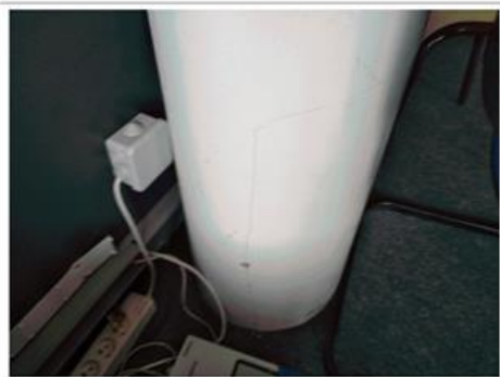
Prélèvement - P009 : R+1 / AILE C / C117 - Entourage de poteau - EP- (Présence d'amiante)
