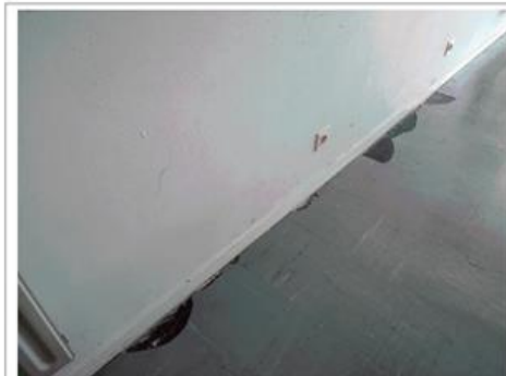
Prélèvement - P004 : R+1 / AILE E / E103 - Dalle de sol - EP- (Présence d'amiante)
