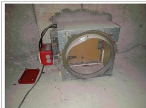
déclaré - : R+3 / AILE D / LOCAL TECHNIQUE 3 - Clapet coupe-feu- (Absence d'amiante)
