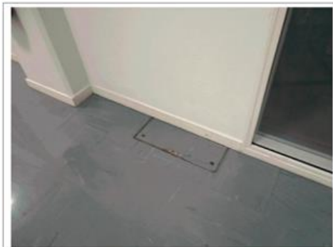
Prélèvement - P015 : RDC / AILE C / CIRCULATION 2 - Dalle de sol- (Absence d'amiante)
