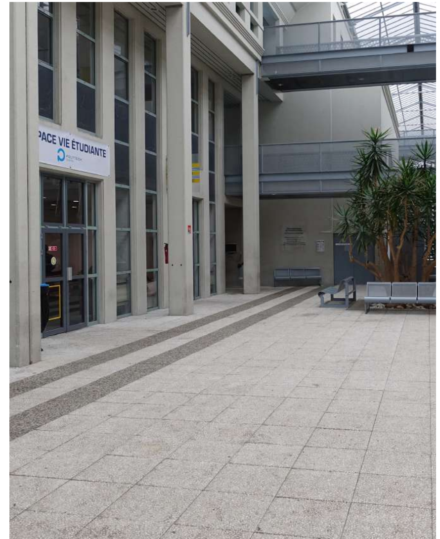
SOL EXISTANT DANS LA RUE INTÉRIEURE DALLES BÉTON DÉSACTIVÉS 50X50CM
