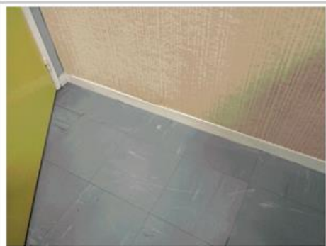
Prélèvement - P014 : RDC / AILE C / C020 - Dalle de sol- (Absence d'amiante)
