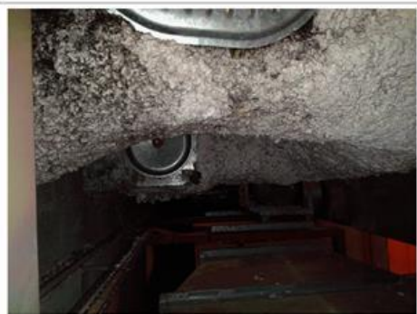
Prélèvement - P012 : R+1 / AILE E / L108 - Flocage- (Absence d'amiante)
