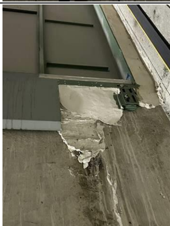
Photo n° PhA037 Localisation : R+7 - TREMIE ASCENSEUR EP 646 Ouvrage : 7 - Ascenseurs, monte-charges et escaliers mécaniques - parois des équipements Partie d'ouvrage : Calfeutrement entre mur et plancher + Calfeutrement entre mur et plancher (joint, bourre) Description : P18 Calfeutrement entre mur et plancher Localisation sur croquis : ZPSO-018
