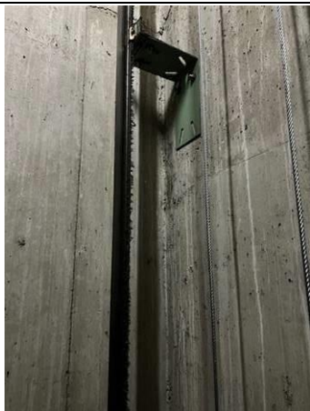
Photo n° PhA036 Localisation : R+5 - TREMIE ASCENSEUR EP 646 Ouvrage : 3 - Parois verticales intérieures - Murs et cloisons maçonnés Partie d'ouvrage : Enduit à base de ciment lissé ou taloché Description : Enduit à base de ciment lissé ou taloché
