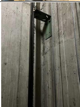
Photo n° PhA031 Localisation : R+5 - TREMIE ASCENSEUR EP 645 Ouvrage : 3 - Parois verticales intérieures - Murs et cloisons maçonnés Partie d'ouvrage : Enduit à base de ciment lissé ou taloché Description : Enduit à base de ciment lissé ou taloché
