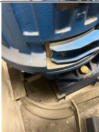
Photo n° PhA029 Localisation : R+8 / LOCAL MACHINERIE ASC - MACHINERIE EP 645 Ouvrage : 7 - Ascenseurs, monte-charges et escaliers mécaniques - Matériels en machinerie Partie d'ouvrage : Frein d'ascenseur Description : Frein d'ascenseur
