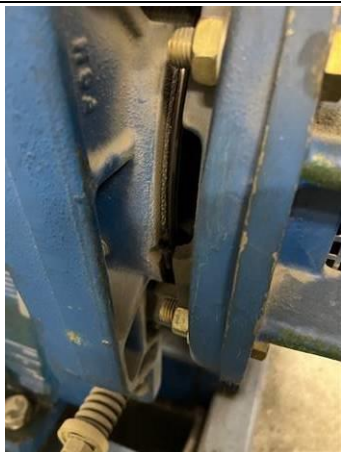
Photo n° PhA005 Localisation : R+8 / LOCAL MACHINERIE ASC - MACHINERIE EP 646 Ouvrage : 7 - Ascenseurs, monte-charges et escaliers mécaniques - Matériels en machinerie Partie d'ouvrage : Frein d'ascenseur Description : P5 Frein d'ascenseur
