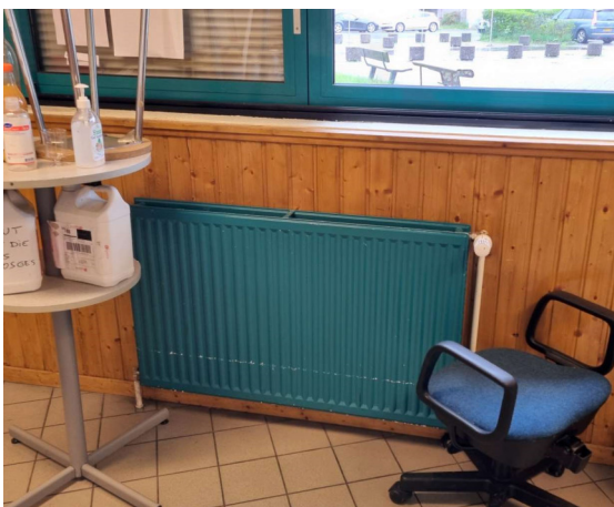
Radiateur existant type panneau acier
