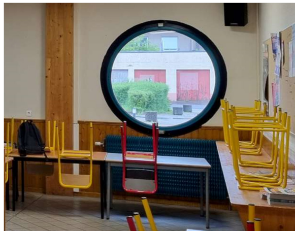
Radiateur existant type « Lamella »
