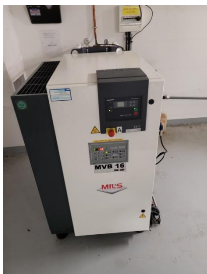
Figures 44 et 45 : Compresseurs air comprimé et pompes à vide PME
