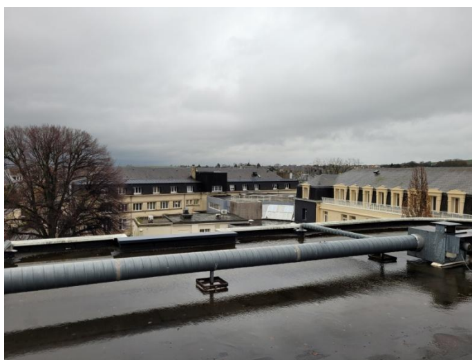
Figures 21 à 24 : CTA et VMC simple flux
