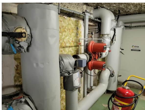
Figures 7 et 8 : Chaudières gaz d'appoints et réseau de distribution
