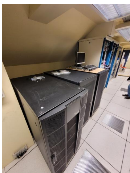
Figures 39 à 40 : Armoire de climatisation et thermostat
