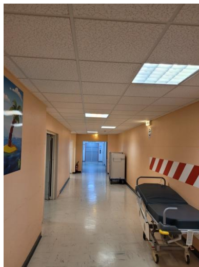
Figures 38 et 39 : Pavé LED et pavés néons 4x18W du Tripode
