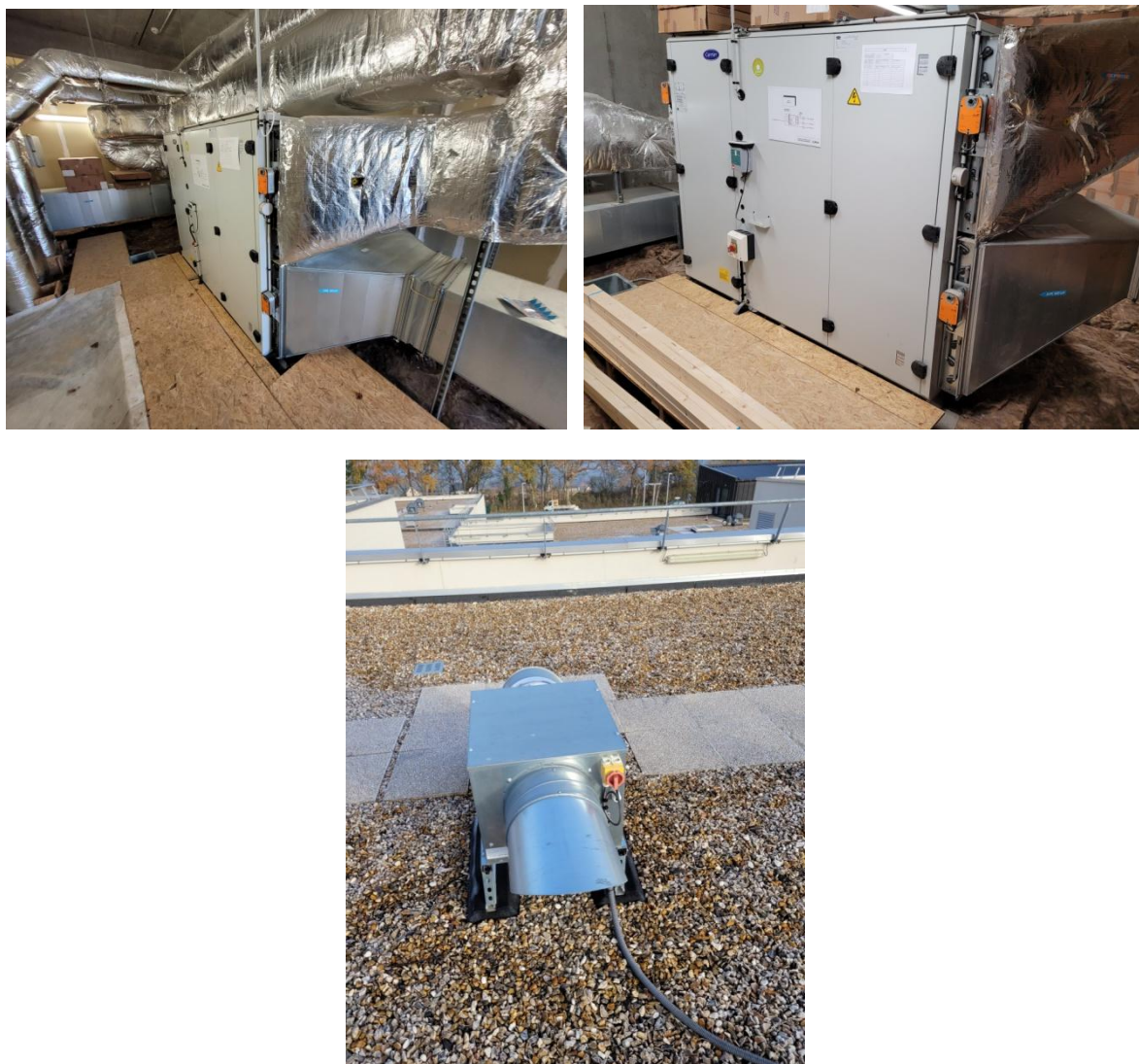
Figures 18 à 20 : CTA et VMC simple flux d'extraction
