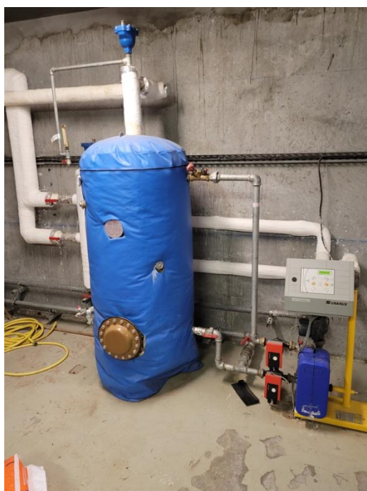
Figures 18 : Ballon de stockage et échangeur
