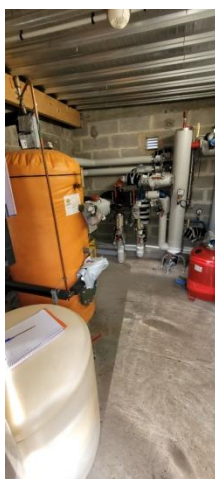
Figures 8 et 9 : Production et distribution d'ECS
