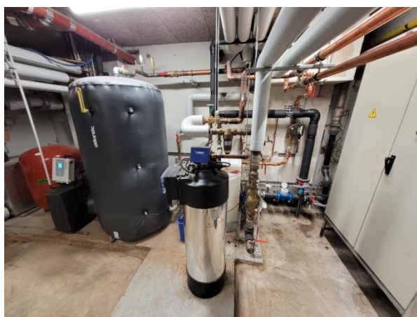
Figure 15 et 16 : Échangeurs et ballon de stockage pour la préparation d'ECS
