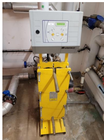
Figures 23 et 24 : Réseau de distribution vers les émetteurs et départ ECS du Tripode
