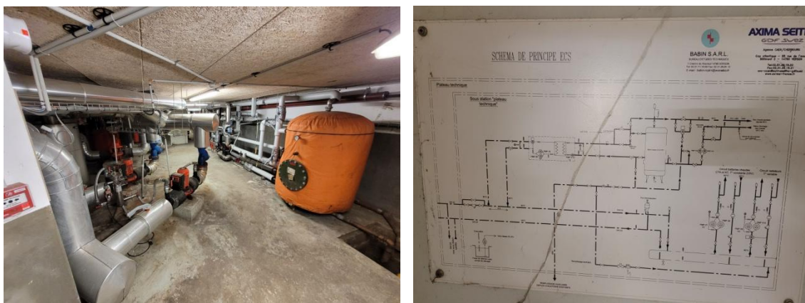
Figures 29 et 30 : Sous-station et schéma de production ECS plateau technique
