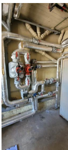
Figures 5 et 6 : Distribution de chauffage, départ colonne montante
