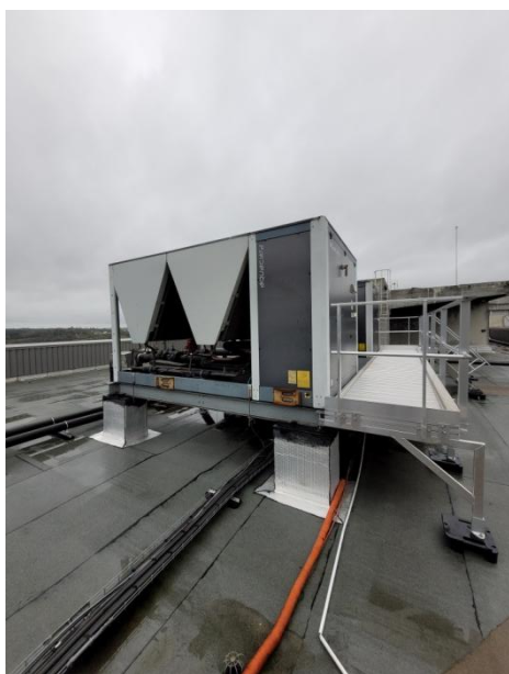
Figures 28 et 29 : Groupe froid en toiture et en extérieur du Tripode
