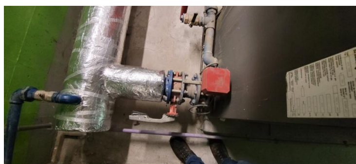
Figure 8 : vannes sur retour
