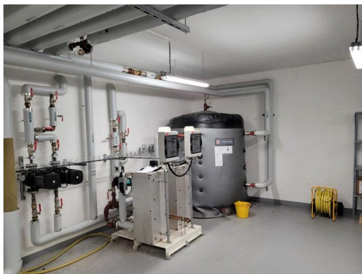
Figures 17 : Ballon de stockage et préparateurs ECS
