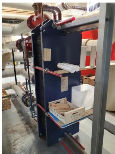
Figures 21 et 22 : Chaufferie Tripode et échangeur entre le primaire et le secondaire
