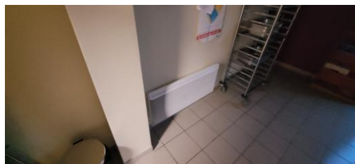
Figure 18 : radiateur électrique
