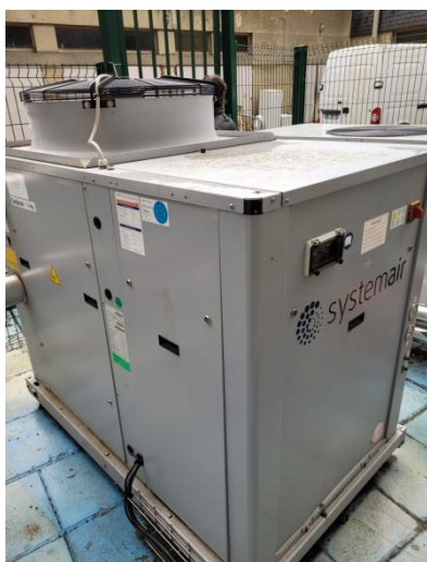
Figures 32 et 33 : Groupe d'eau glacée Tripode et groupe froid en toiture du PME
