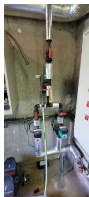
Figures 7 à 8 : Production et distribution d'ECS
