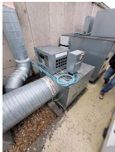
Figures 36 et 37 : CTA et VMC simple flux du PME
