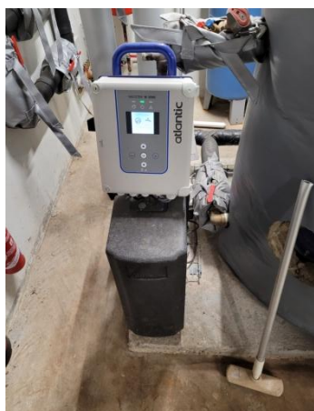
Figure 15 et 16 : Échangeurs et ballon de stockage pour la préparation d'ECS
