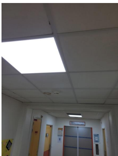
Figures 38 et 39 : Pavé LED et pavés néons 4x18W du Tripode
