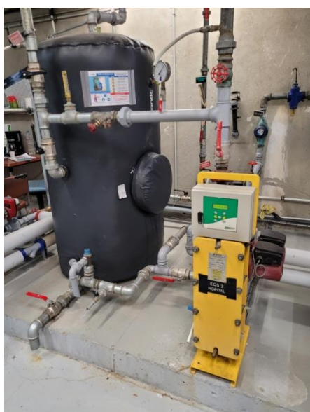
Figures 26 et 27 : Départ ECS Hôpital et sous-station bâtiment Colombe avec sa bouteille de découplage et son échangeur.
