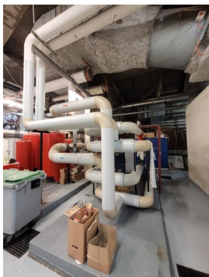
Figures 21 et 22 : Chaufferie Tripode et échangeur entre le primaire et le secondaire
