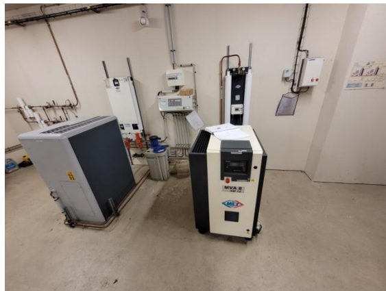
Figures 41 et 42 : Pompes à vide et compresseurs air comprimé
