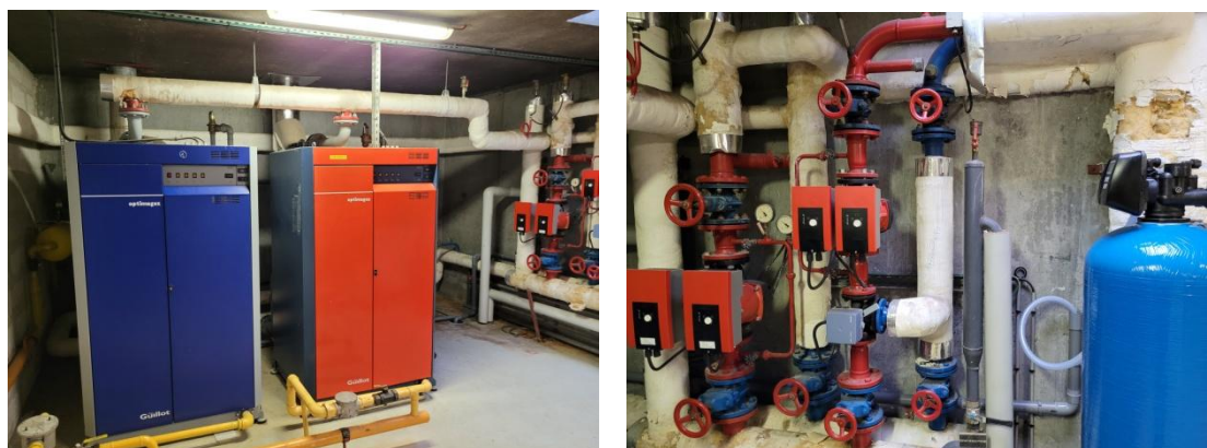
Figures 12 et 13 : Chaudières gaz et réseau de distribution
