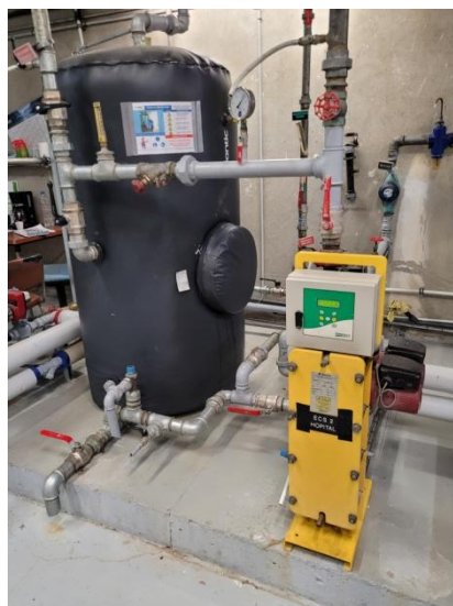
Figures 23 et 24 : Réseau de distribution vers les émetteurs et départ ECS du Tripode
