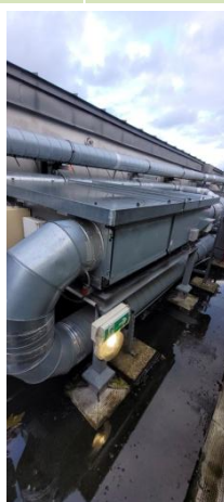
Figures 11 à 13 : CTA double flux, bouche et caisson
