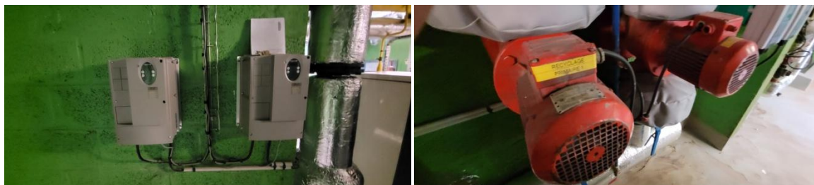
Figures 5 et 6 : pompe primaire, variateur de fréquence
