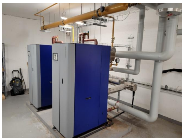
Figures 10 et 11 : Chaudières gaz et réseau de distribution
