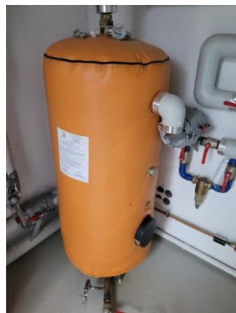
Figure 11 : Échangeurs et ballon de stockage pour la préparation d'ECS
