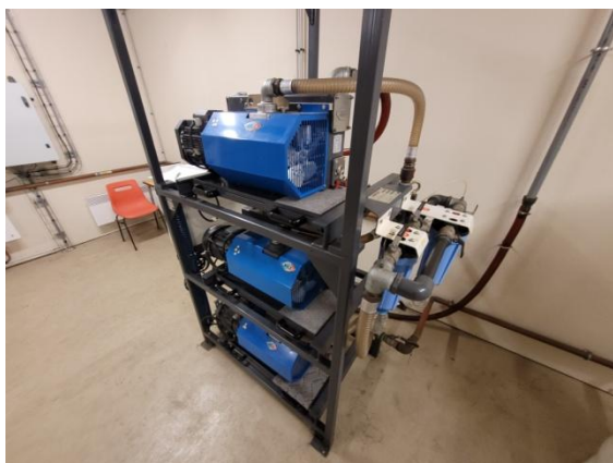
Figures 41 et 42 : Pompes à vide et compresseurs air comprimé
