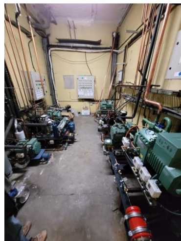
Figures 30 et 31 : Unités de froid pour les chambres froides
