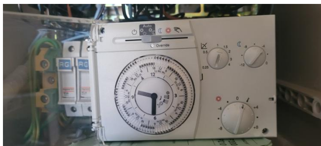
Figure 8 : Régulateur chauffage
