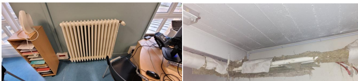
Figures 5 et 6 : émission de chauffage et calorifugeage dégradé
