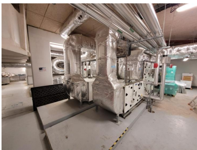
Figures 36 et 37 : CTA et VMC simple flux du PME
