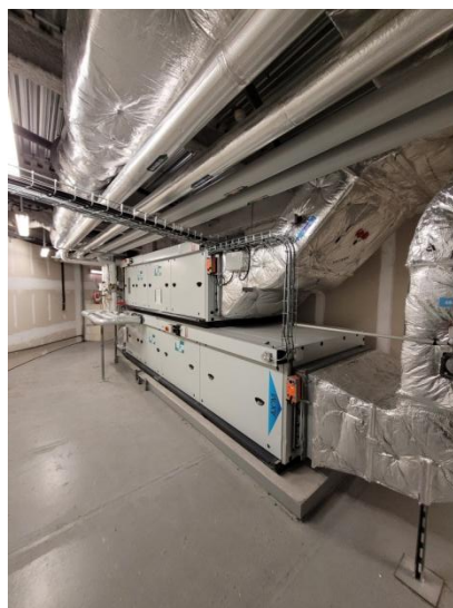
Figures 34 et 35 : Extraction en toiture et CTA du Tripode
