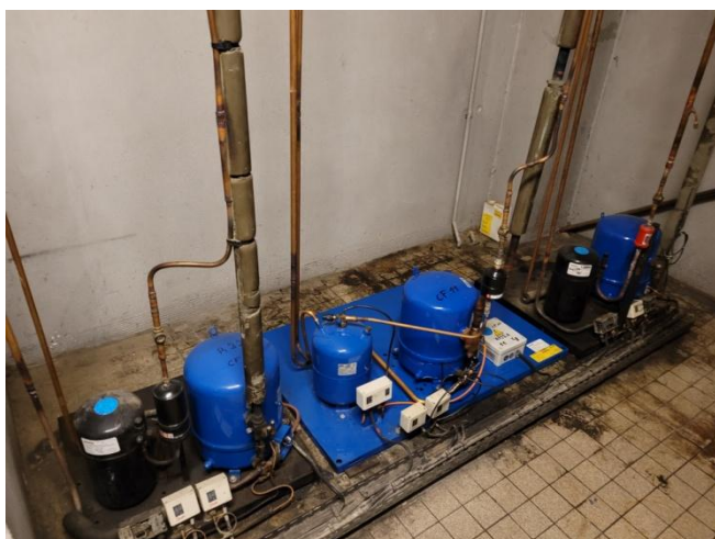
Figures 30 et 31 : Unités de froid pour les chambres froides
