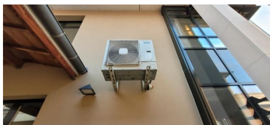
Figures 9 et 10 : Unité extérieure local serveur et étage
