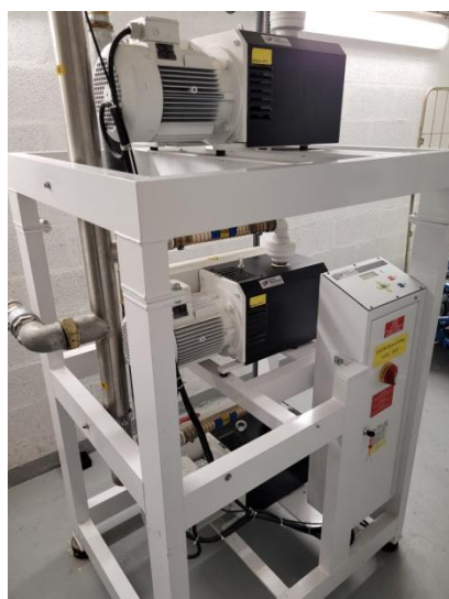
Figures 44 et 45 : Compresseurs air comprimé et pompes à vide PME
