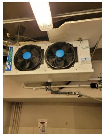
Figures 25 et 26 : Production de vide médical et évaporateur pour chambre froide
