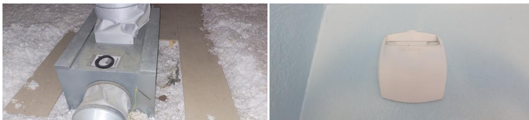
Figures 12 et 13 : caisson, bouche d'extraction
