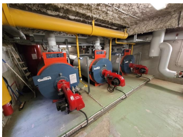
Figures 7 et 8 : Chaudières gaz d'appoints et réseau de distribution
