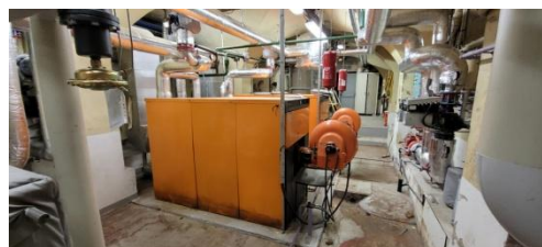
Figure 3 : chaudières de secours
