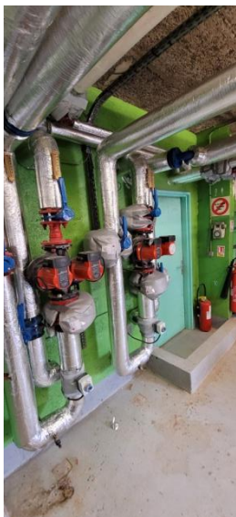
Figures 9 et 10 : Distribution de chauffage, aérotherme kiné
