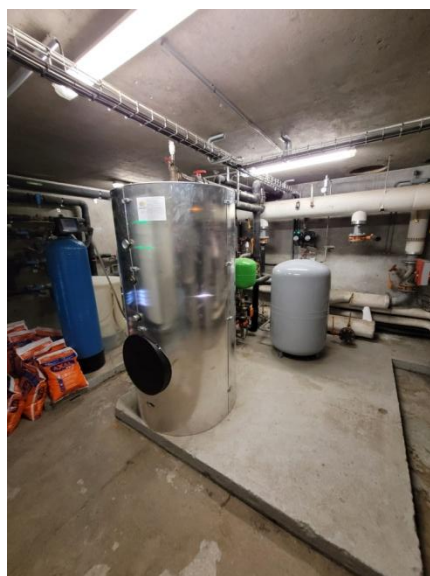
Figures 19 et 20 : Sous-station ECS Maisonnée et Devaux
