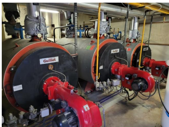
Figures 21 et 22 : Chaudières gaz et réseau de distribution
