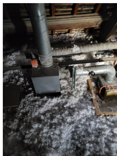
Figures 16 à 19 : CTA et VMC simple flux
