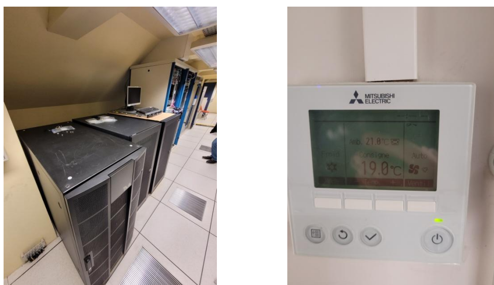
Figures 39 à 40 : Armoire de climatisation et thermostat
