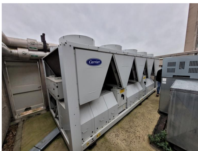
Figures 32 et 33 : Groupe d'eau glacée Tripode et groupe froid en toiture du PME
