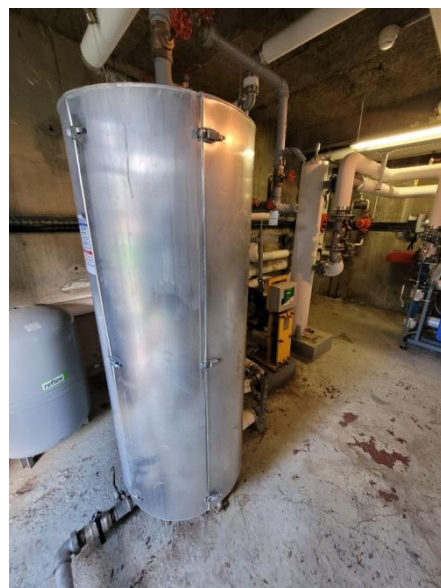
Figures 26 et 27 : Départ ECS Hôpital et sous-station bâtiment Colombe avec sa bouteille de découplage et son échangeur.
