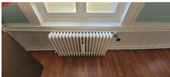
Figure 38 : Radiateur eau chaude
