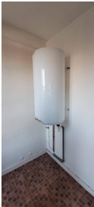
Figure 40 : Ballon électrique
