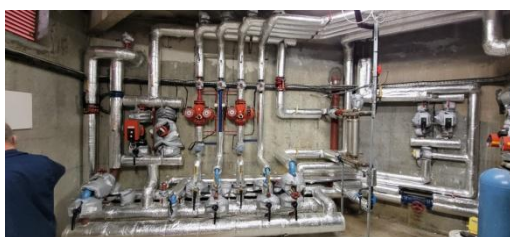
Figures 5 et 6 : Distribution de chauffage, aérothermes
