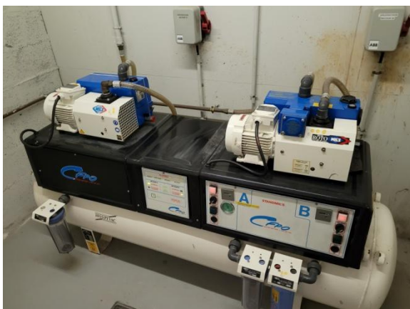
Figures 25 et 26 : Production de vide médical et évaporateur pour chambre froide
