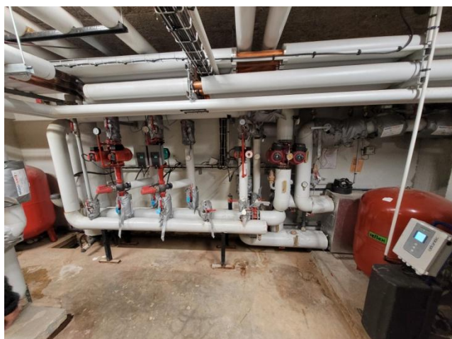
Figures 11 et 12 : Sous-station et réseau de distribution
