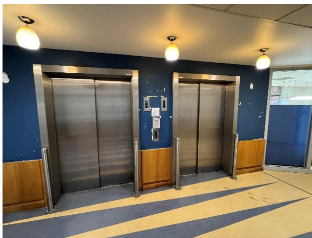
Boîtes à boutons + indicateurs à remplacer
