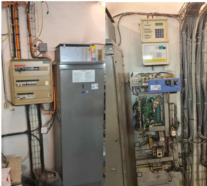
Armoires variateur / commande à déposer
