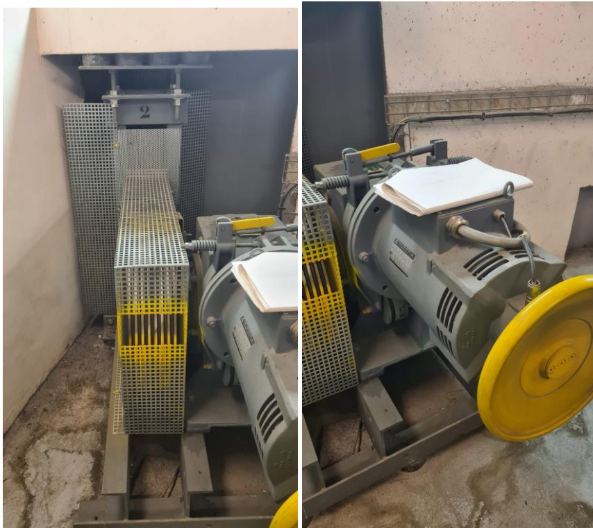
Systèmes d'entrainement à déposer
