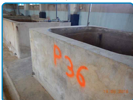
PRLV n° 36 sur bassins Béton Enduit projeté
