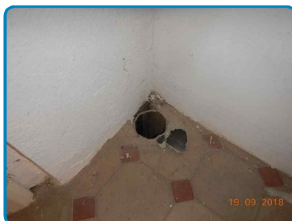
PRLV n° 10 sur Conduit(s) de fluide Fibres ciment Amiante ciment / C
