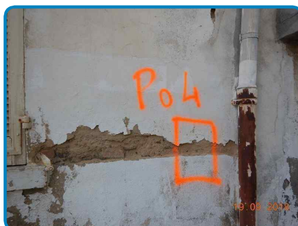
PRLV n° 4 sur Façade ouest Pierres Enduit projeté
