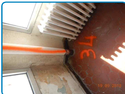
PRLV n° 34 sur Conduit(s) de fluide Fibres ciment Amiante ciment
