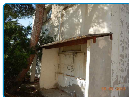
PRLV n° 50 sur Plafond Charpente traditionnelle bois Plaques fibre-ciment
