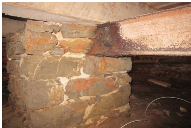
Image 11 : Corrosion profilés
