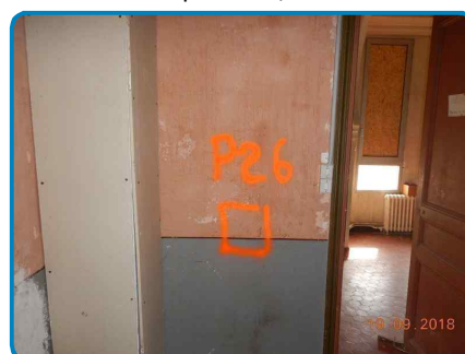
PRLV n° 26 sur Mur(s) Brique Enduit peinture / B
