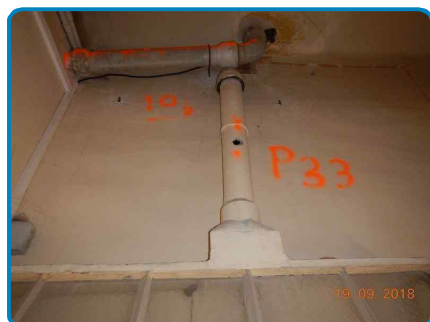
ZSO sur PRLV n° 10 sur Conduit(s) de fluide Fibres ciment Amiante ciment
