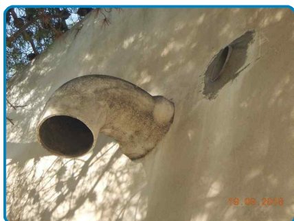
PRLV n° 51 sur Conduit(s) cheminée Fibres ciment Amiante ciment
