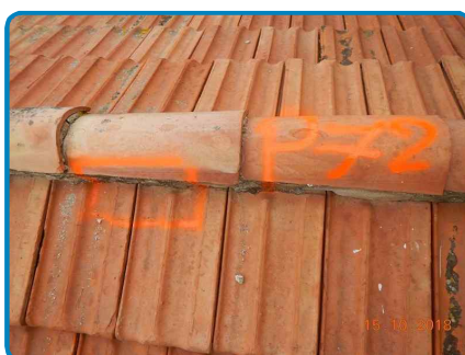
PRLV n° 72 sur Plafond Charpente traditionnelle bois Tuiles faitiâires
