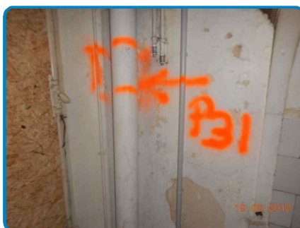
PRLV n° 31 sur Conduit(s) de fluide Fibres ciment Amiante ciment / B
