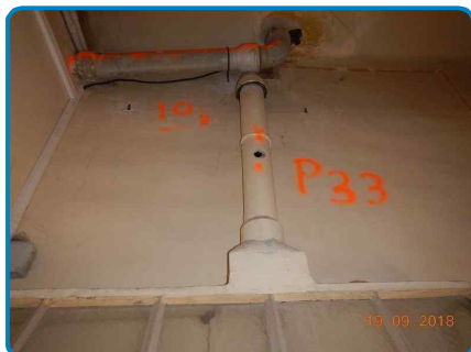
PRLV n° 33 sur Conduit(s) cheminée Fibres ciment Amiante ciment / B
