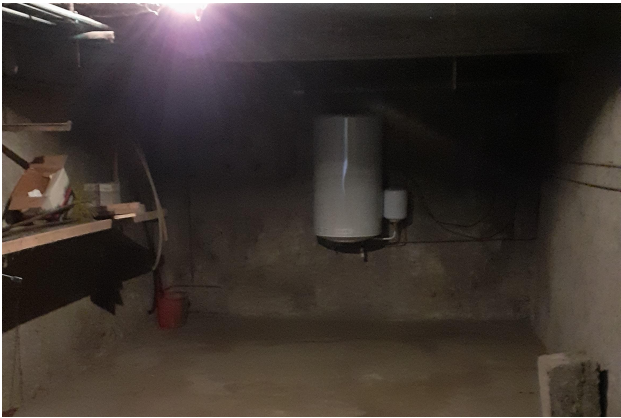
Ballon ECS électrique - partie bureaux ONF
