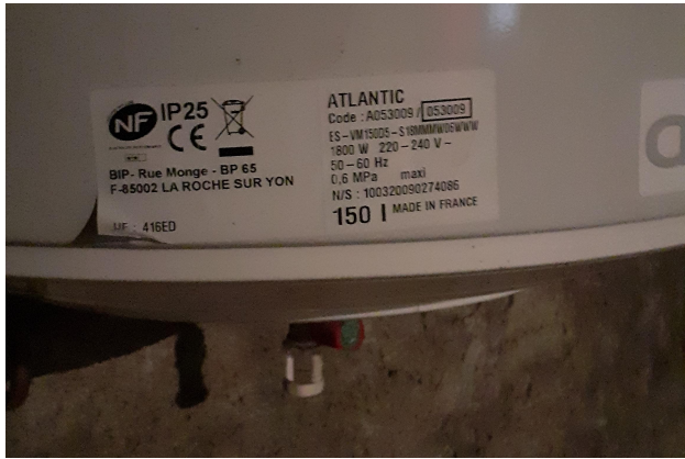
Ballon ECS électrique - partie bureaux ONF
