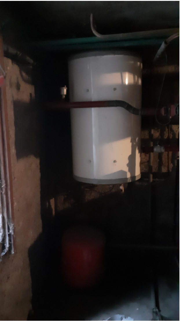
Ballon ECS combiné à la chaudière fioul existante pour le logement
