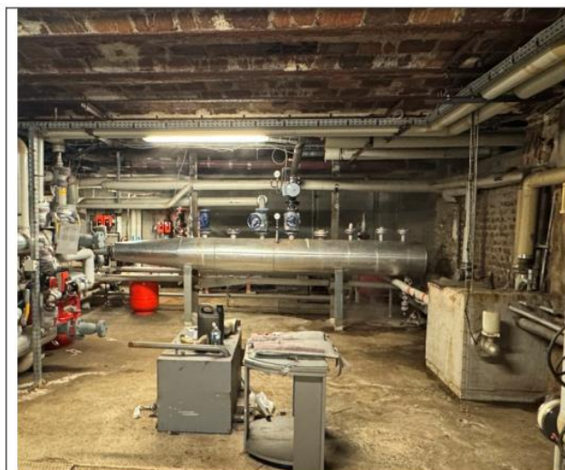
Sous-station chauffage raccordé sur CPCU en sous-sol
