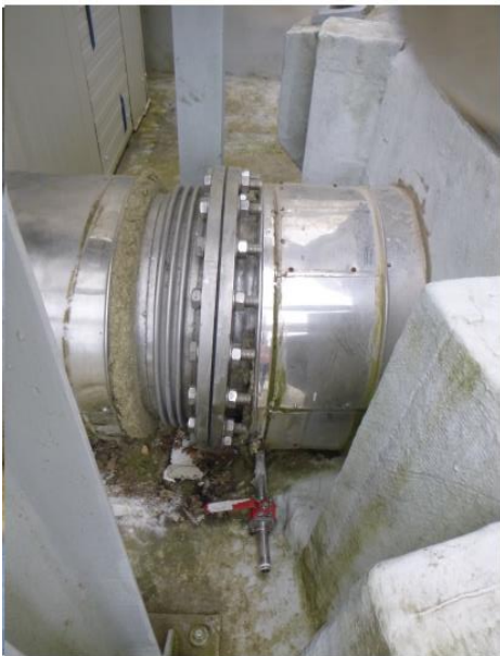
Figure 6 : photo brides DN 600 et purge DE
