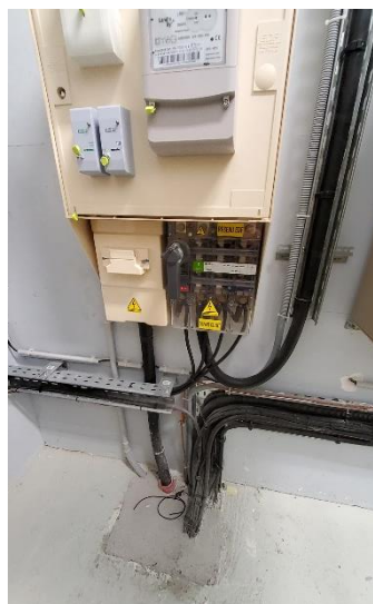
Compteur et disjoncteur général dans le local transformateur
