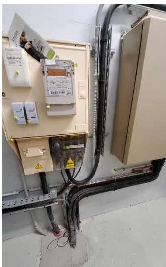
Compteur et disjoncteur général dans le local transformateur
