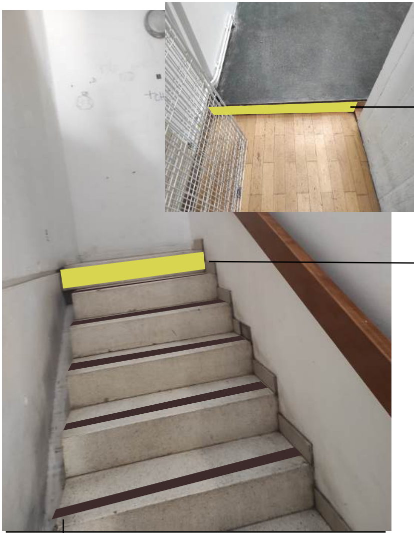
PEINTURE SUR CONTREMARCHES Réalisation d'une couche de peinture sur la première et dernière contremarches des escaliers pour repères visuels contrastés.
