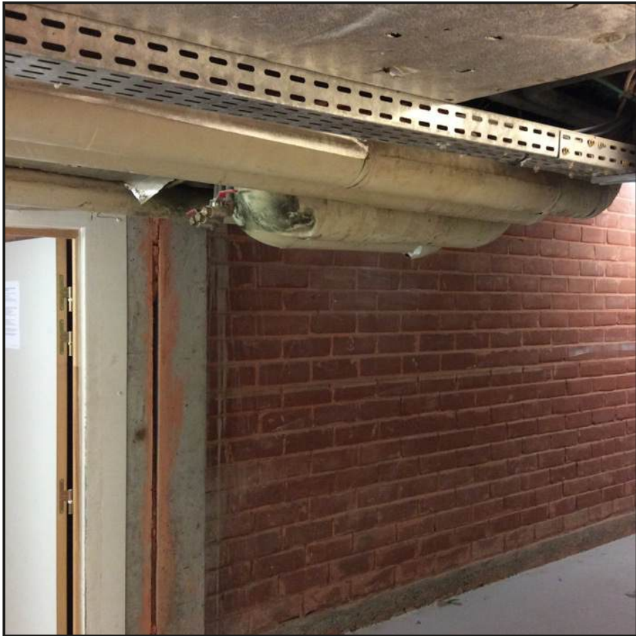
PEINTURE SUR OUVRAGES A HAUTEUR REDUITE Application d’une peinture contrastée sur les ouvrages décrit dans les localisations architectes. Repères visuels sur les ouvrages des gaines techniques situés à des hauteurs de passage réduit.
