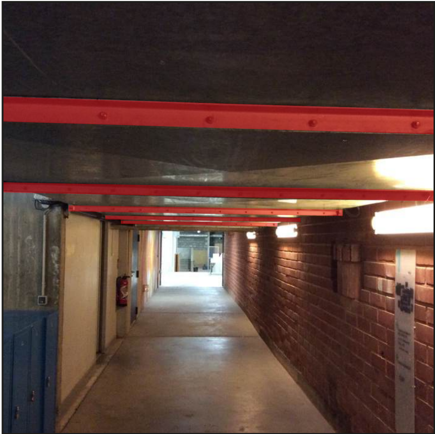
PEINTURE SUR OUVRAGES A HAUTEUR REDUITE Application d’une peinture contrastée sur les ouvrages décrit dans les localisations architectes. Repères visuels sur les ouvrages des gaines techniques situés à des hauteurs de passage réduit.
