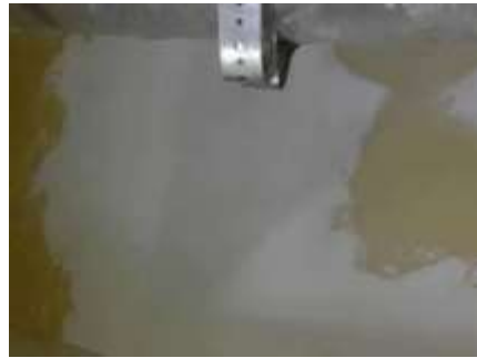
Photo n° PhA008 Localisation : R-1 - Animalerie - Pièce 5 - Salle de repos Ouvrage : 3 - Parois verticales intérieures - Cloisons sèches (assemblées, préfabriquées) Partie d'ouvrage : Bandes calicot Description : Bandes calicot
