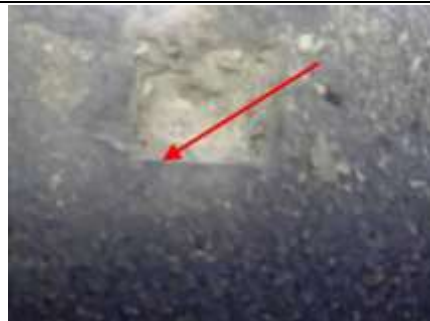
Photo n° PhA010 Localisation : R-1 - Animalerie - Pièce 8 - Salle de stock Ouvrage : 5 - Planchers et planchers techniques - Revêtements de sols Partie d'ouvrage : Colle non bitumineuse Description : Colle non bitumineusemarron de linileum bleu
