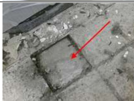
Photo n° PhA007 Localisation : R-1 - Animalerie - Pièce 1 Ouvrage : 5 - Planchers et planchers techniques - Revêtements de sols Partie d'ouvrage : Colle de carrelage Description : Colle grise de carrelage jaune tacheté 5*5
