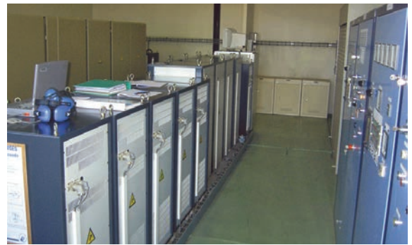
Poste recevant des régulateurs de balisage Aérodrome de Pau
