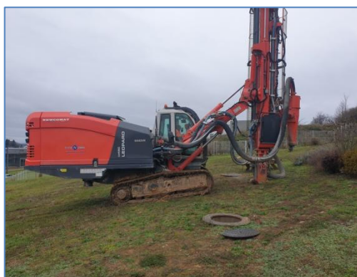
Forage de T2 vers tranchée infiltration initiale
