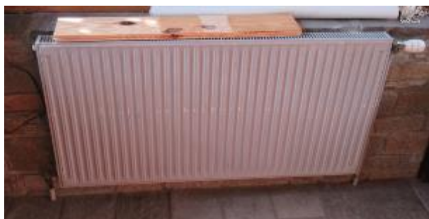
Figure 4: Radiateur en acier de la véranda
