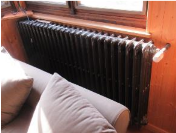
Figure 2 : Radiateur en fonte de la pièce de vie
