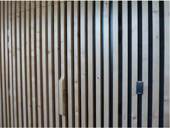
PHOTO CLOISON BOIS - INTEGRATION D'UNE PORTE et SA POIGNEE
