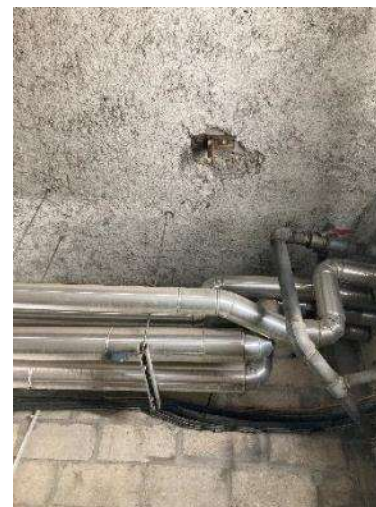
Niveau 0 – Dégradation flocage en plafond
