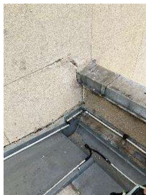
Fissuration toiture
