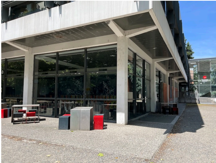
Vue des consoles en béton
