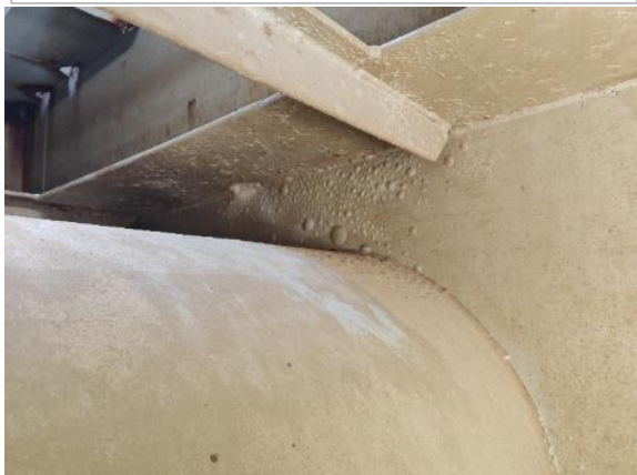
Cloquage de la peinture au niveau des
