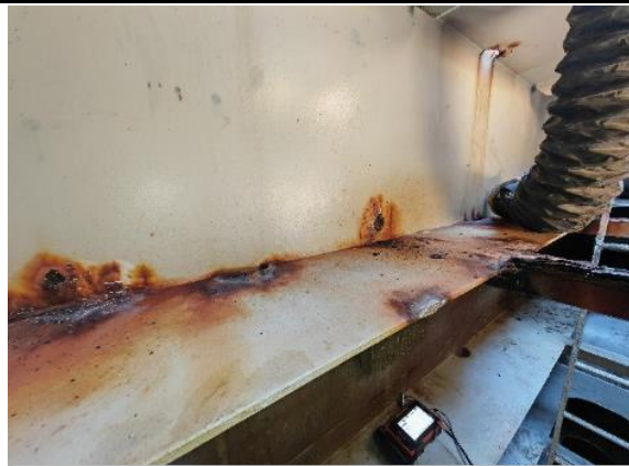
Corrosion en zones de marnage
