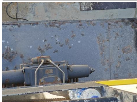
Dégradation pont de ressaut AV (côté bassin)
