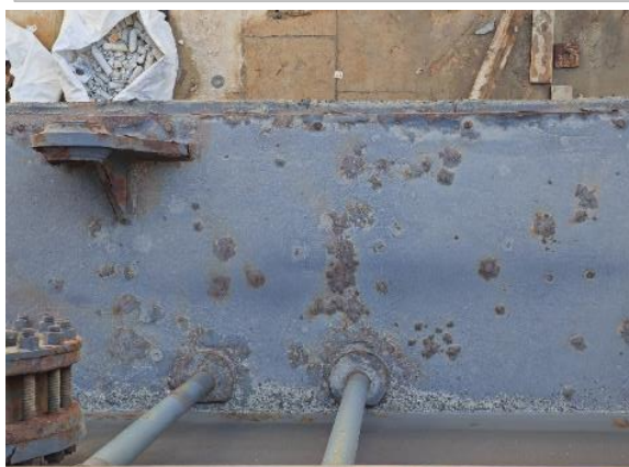
Dégradation pont de ressaut AV (côté bassin)
