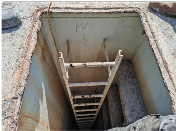
Echelle MV3 dégradée
