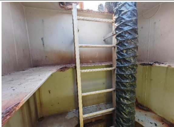
Corrosion en zones de marnage
