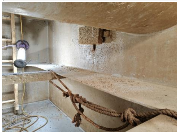
Cloquage de la peinture au niveau des
