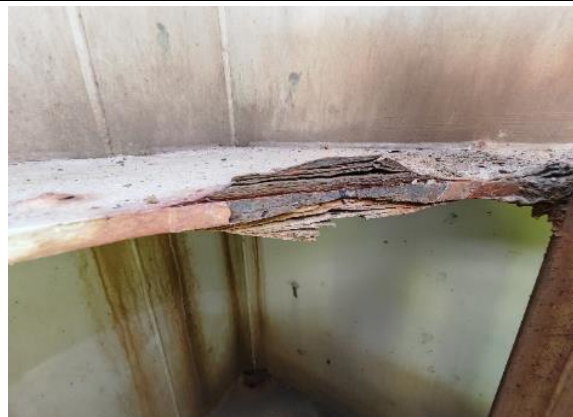
Corrosion en zones de marnage
