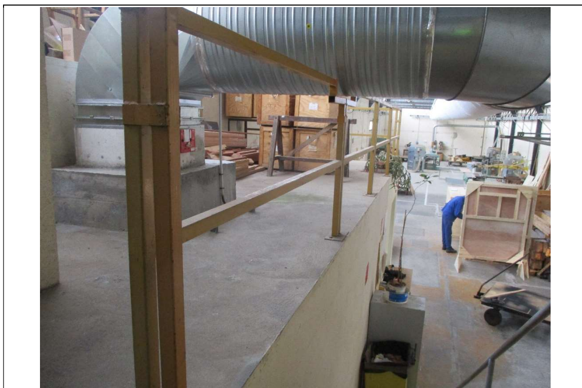
Photo n°19 : Absence de plinthes - Local 015, mezzanine
