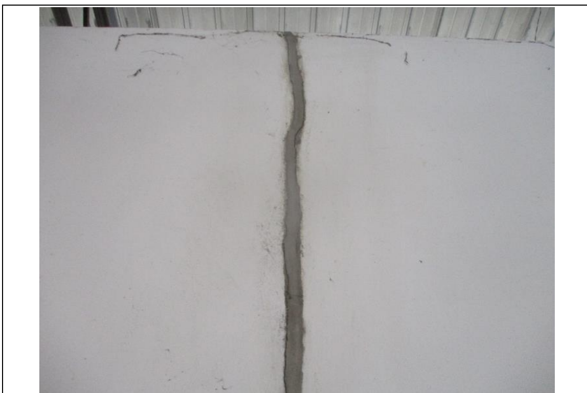
Photo n°30 : Fissures verticales - Local 022
