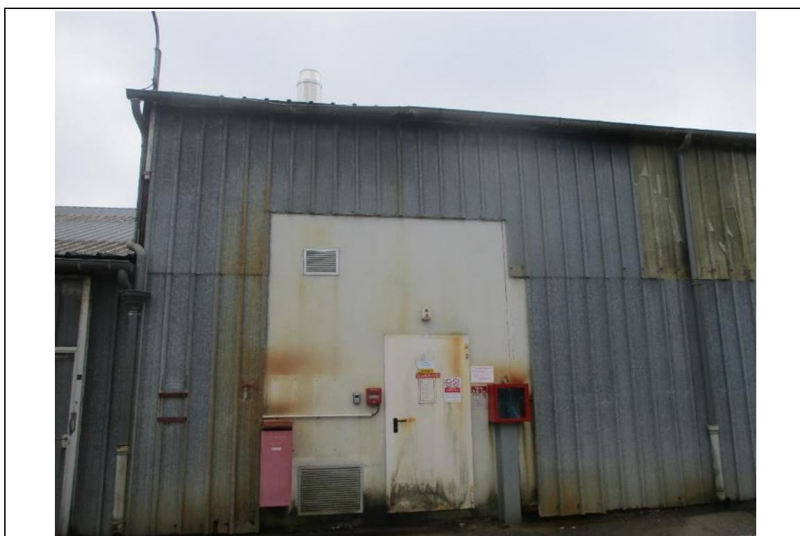
Photo n°26 : Traces de chocs - Côté Ouest, au droit de la chaufferie 159E
