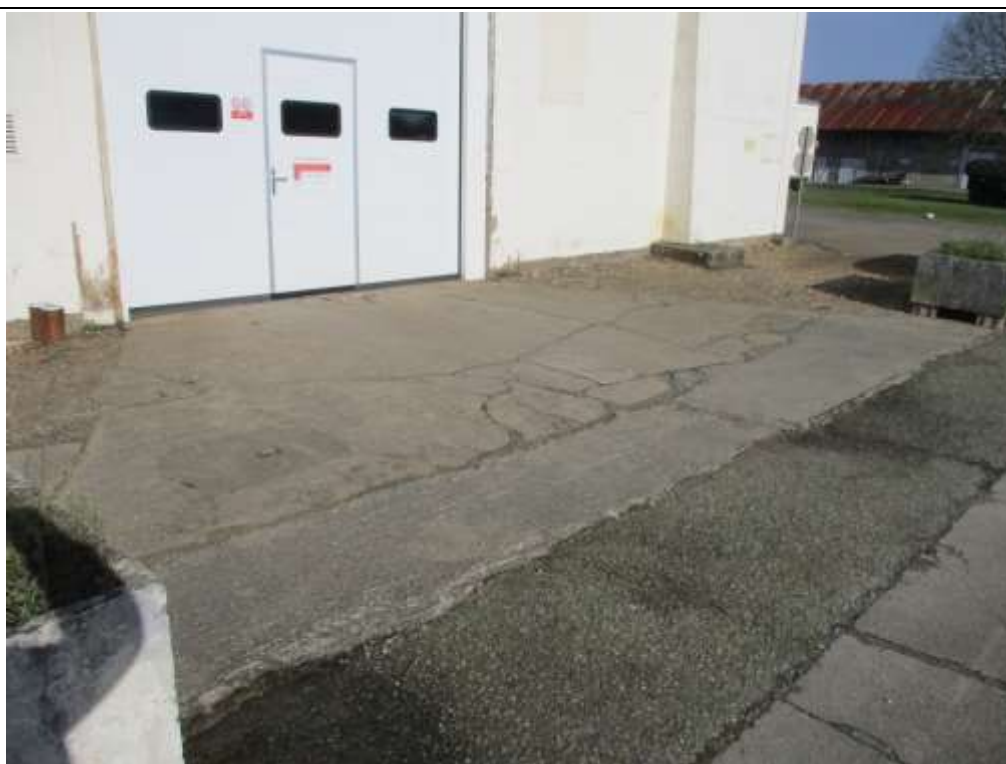
Photo n°2 : Fissures - Réparties sur les dallages
