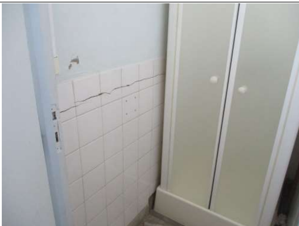
Photo n°17 : Fractures horizontales - Local 018, sur carrelage, partie douche
