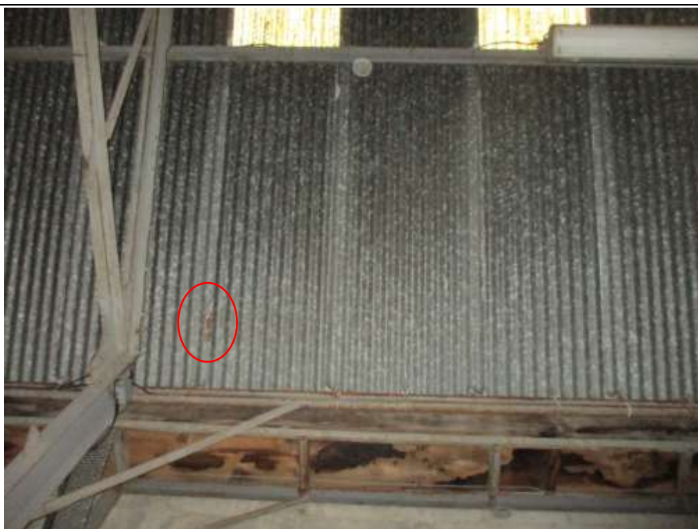
Photo n°9 : Corrosion - Réparties en sous-face de toiture
