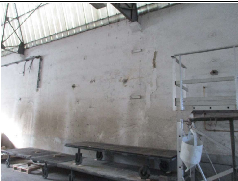
Photo n°8 : Fissures verticales - Local 016, voile de séparation avec local 015
