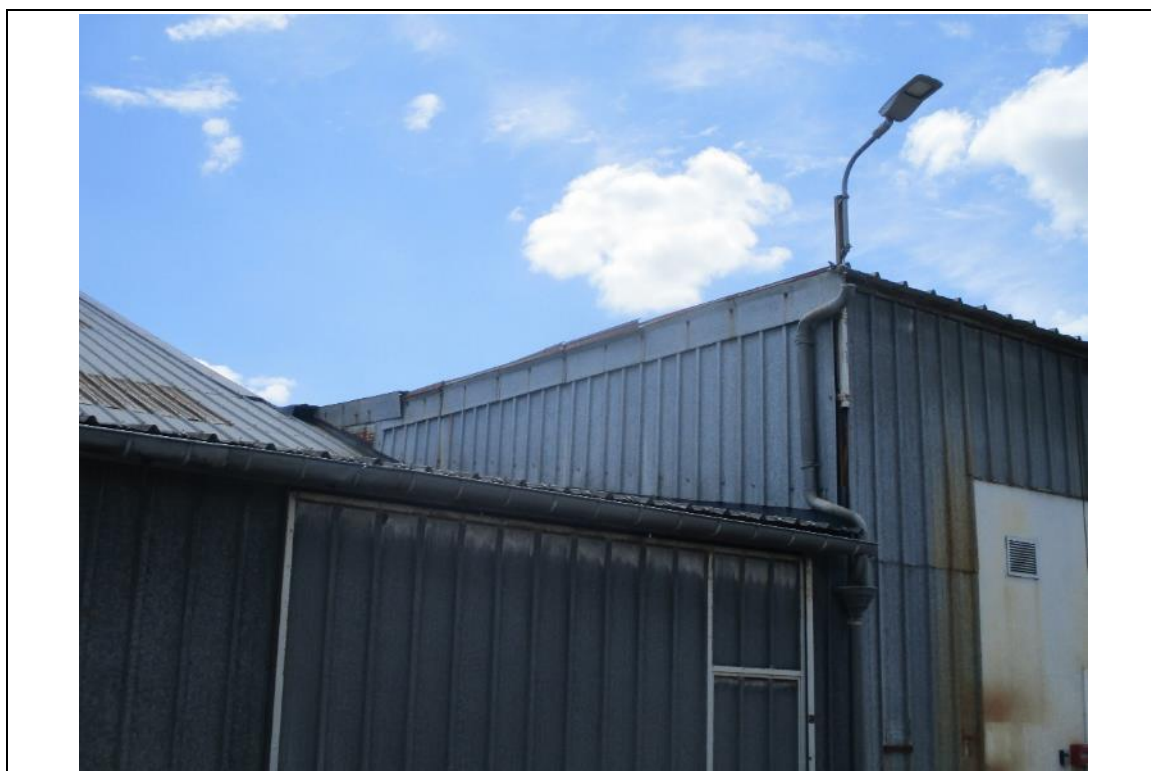
Photo n°3 : Enrouillement - Réparti sur toute la longueur
