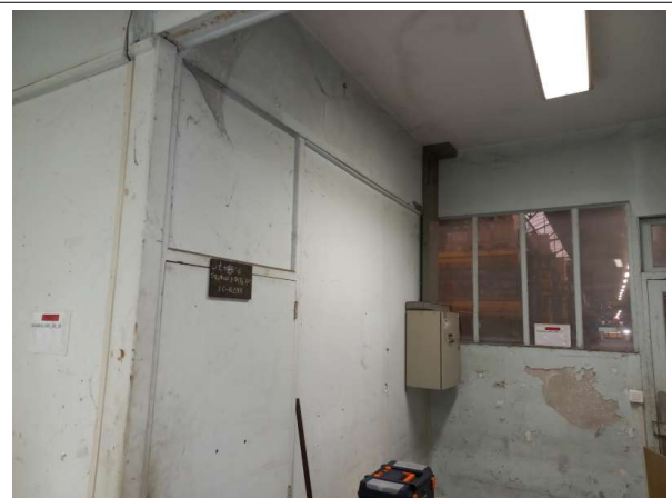
Prélèvement - P23 : Bâtiment 158 / Rez de chaussée / Local 014 - Panneau de cloison- (Présence d'amiante)
