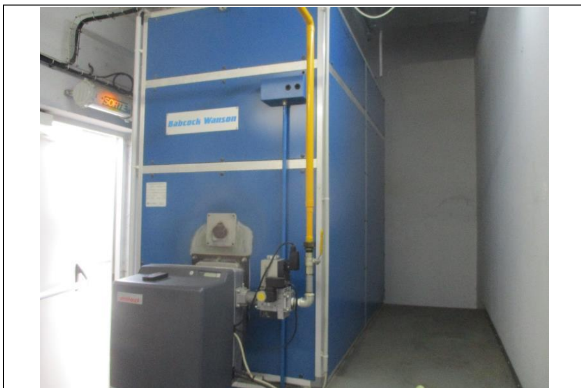
Photo n°36 : Générateur air chaud - Chaufferie 159E vue d'ensemble
