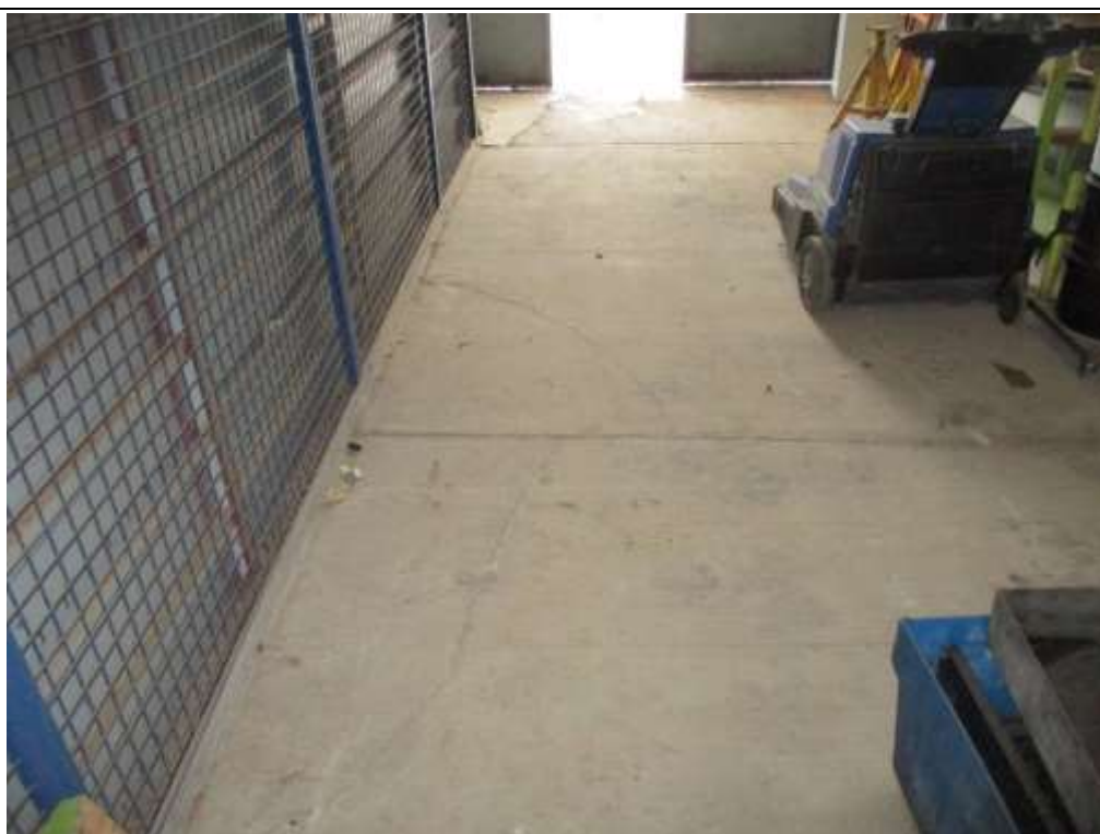
Photo n°8 : Fissures - Réparties sur le dallage
