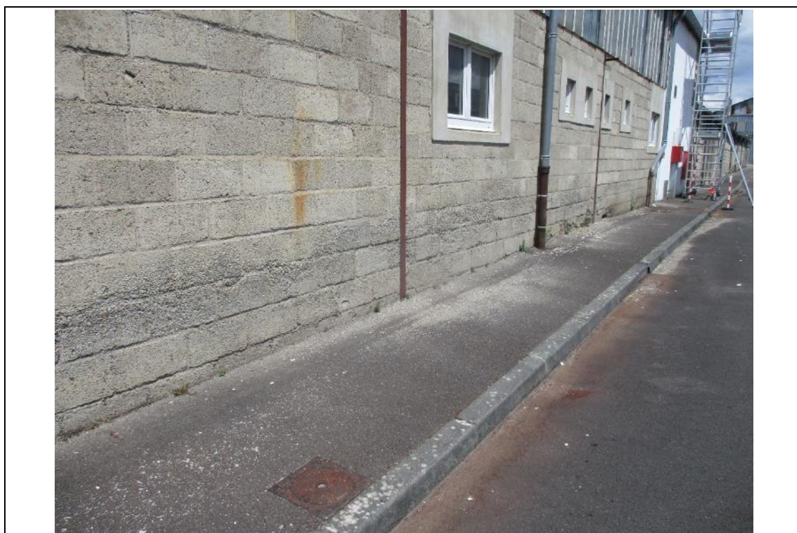
Photo n°8 : Altération des matériaux constitutifs - Réparti sur toute la longueur, en pied
