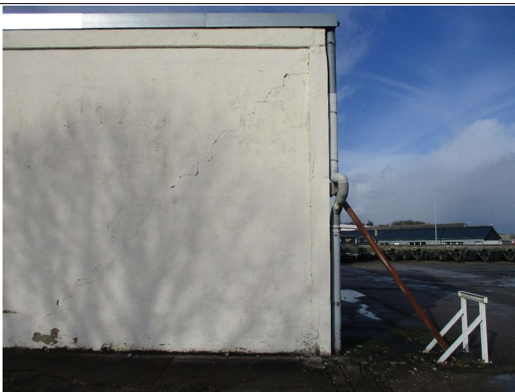
Photo n°4 : Fractures obliques - Local 025, côté Est
