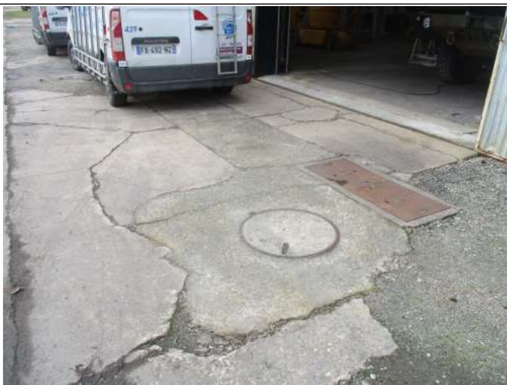
Photo n°2 : Fissures - Réparties sur les dallages béton
