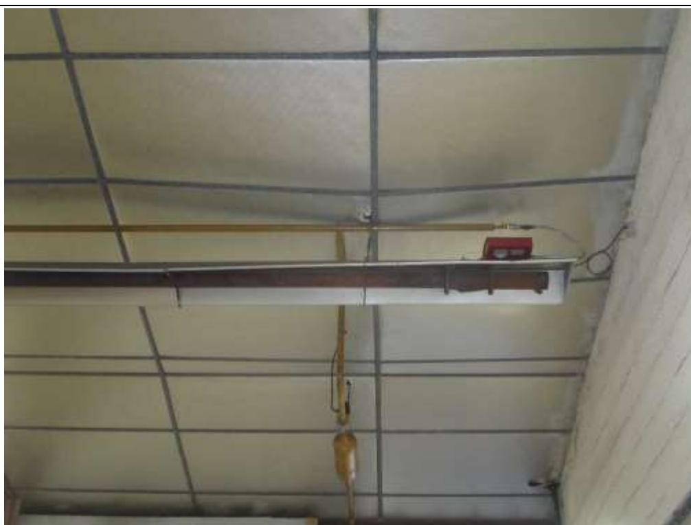
Photo n°16 : Affaissement - Local 019, faux-plafond
