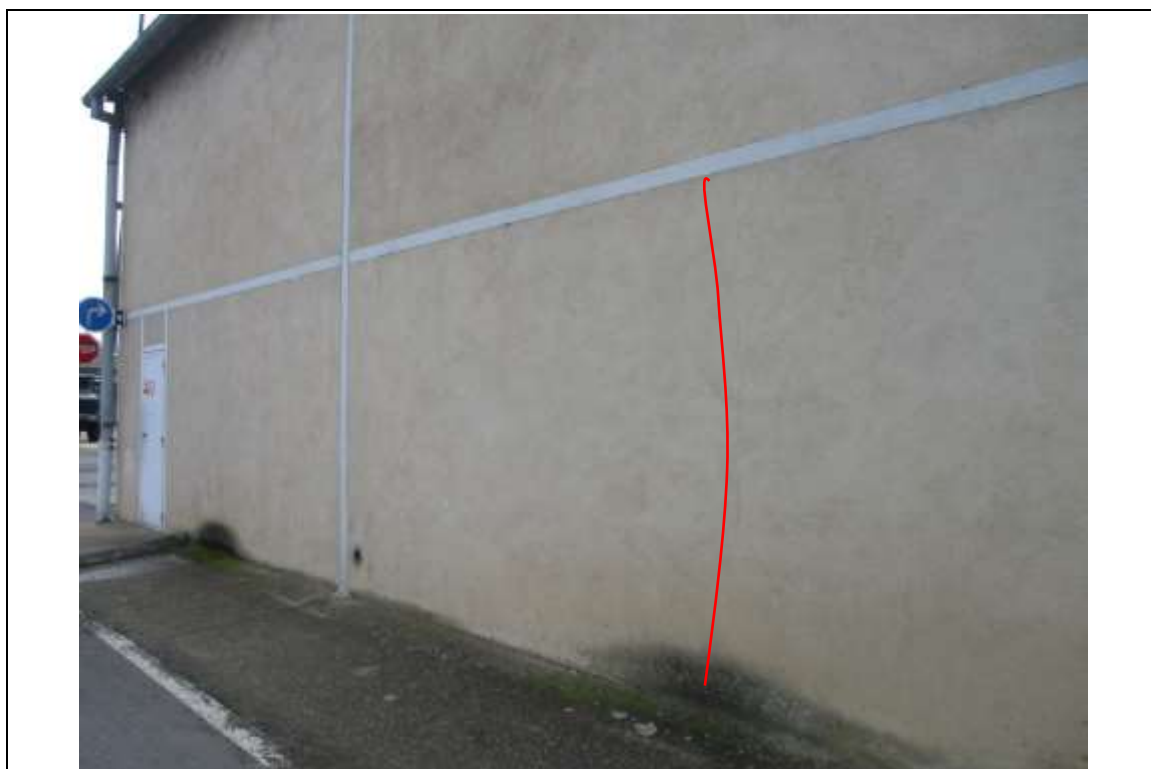
Photo n°7 : Fissures verticales - Partie inférieure de voile maçonné, entre portiques
