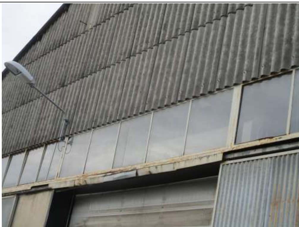
Photo n°11 : Corrosion feuilletante - Côté Sud, châssis de fenêtres
