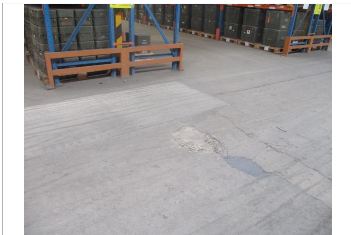
Photo n°12 : Epaufrure du béton - Local 010, réparties sur l'ensemble du dallage
