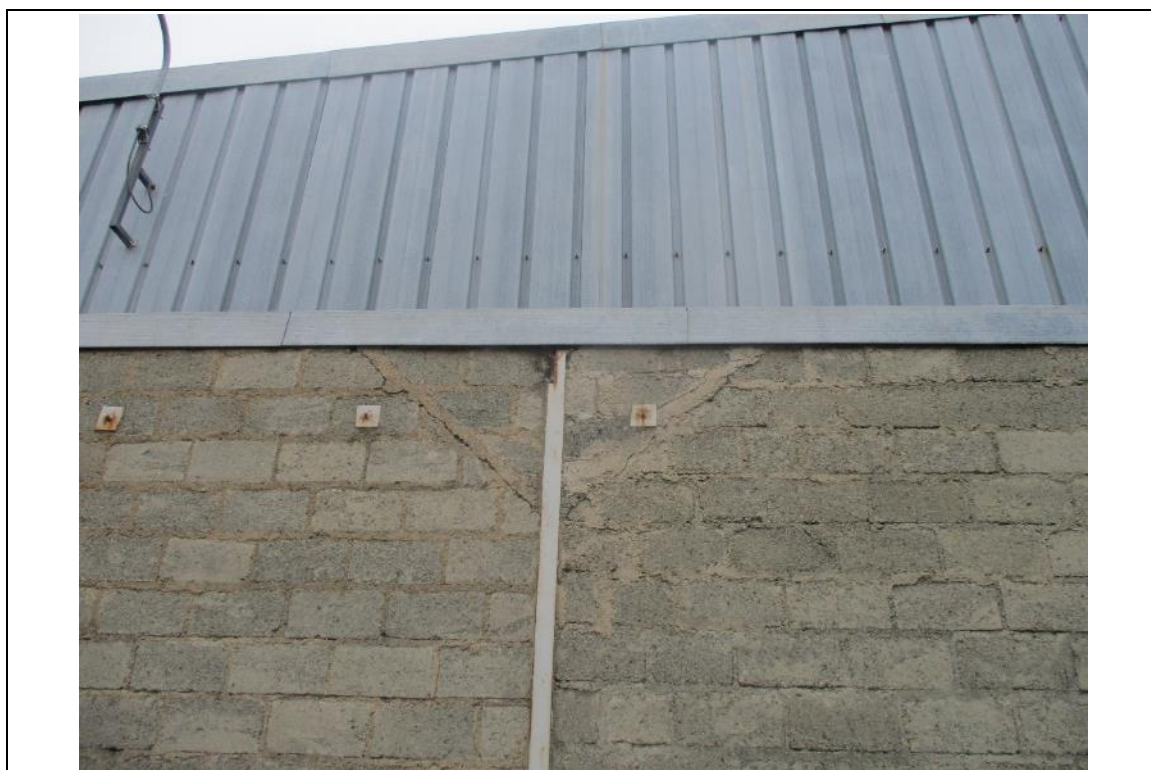
Photo n°4 : Fissures obliques - Au droit de bracons
