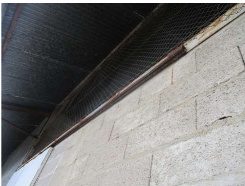
Photo n°10 : Corrosion - Local 08, côté Ouest
