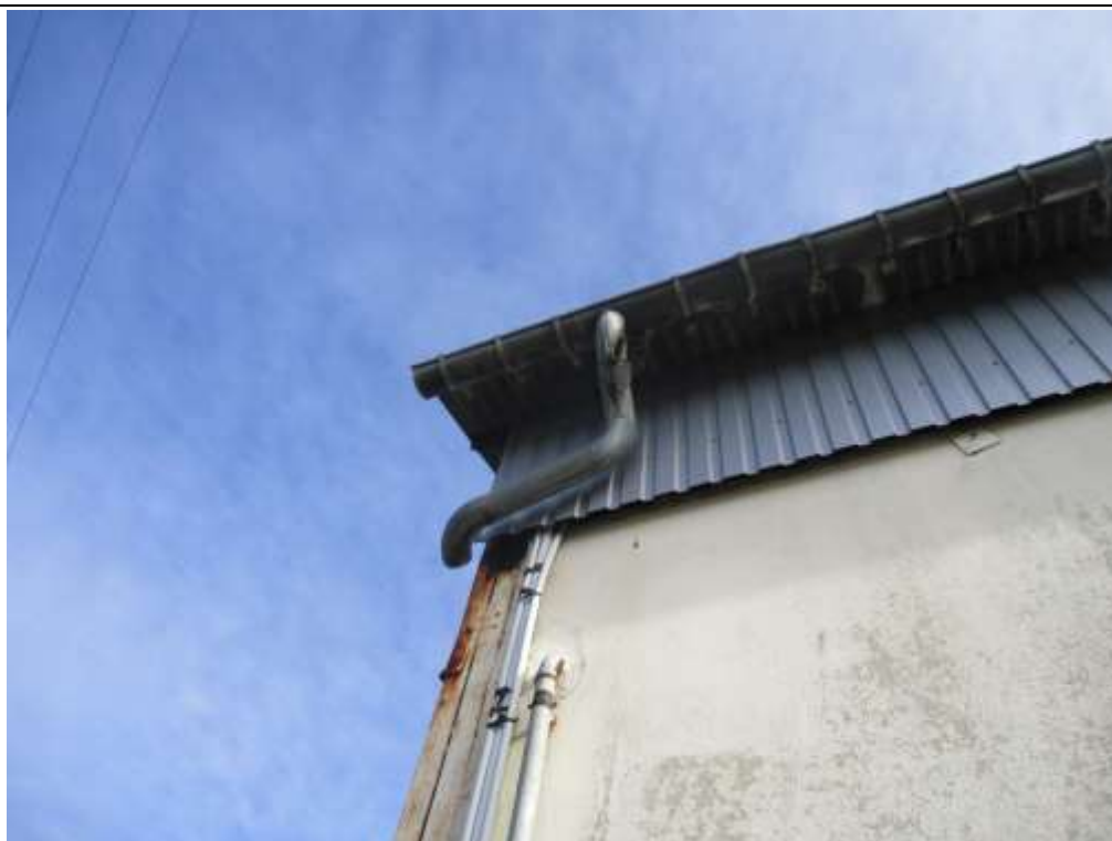
Photo n°11 : Absence de raccordement - Sur descente d'eaux pluviales côté Nord
