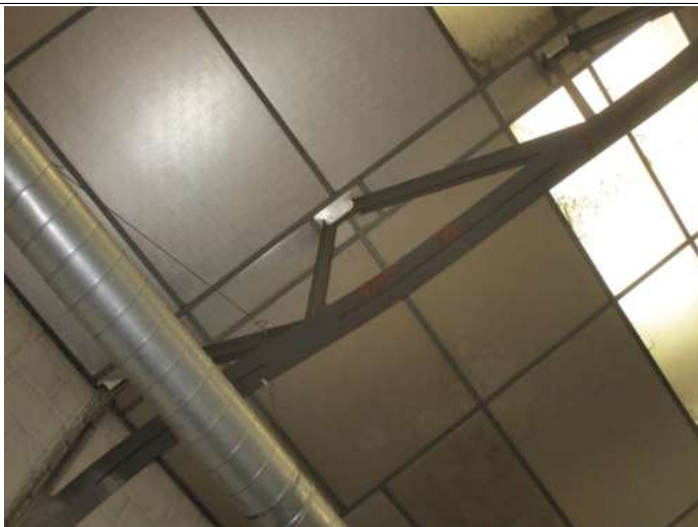
Photo n°9 : Enrouillement - Répartis sur l'ensemble des portiques
