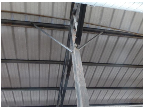
5 - bracons permettant la stabilité hors plan de l'ouvrage sur les poteaux de la ferme principale.
