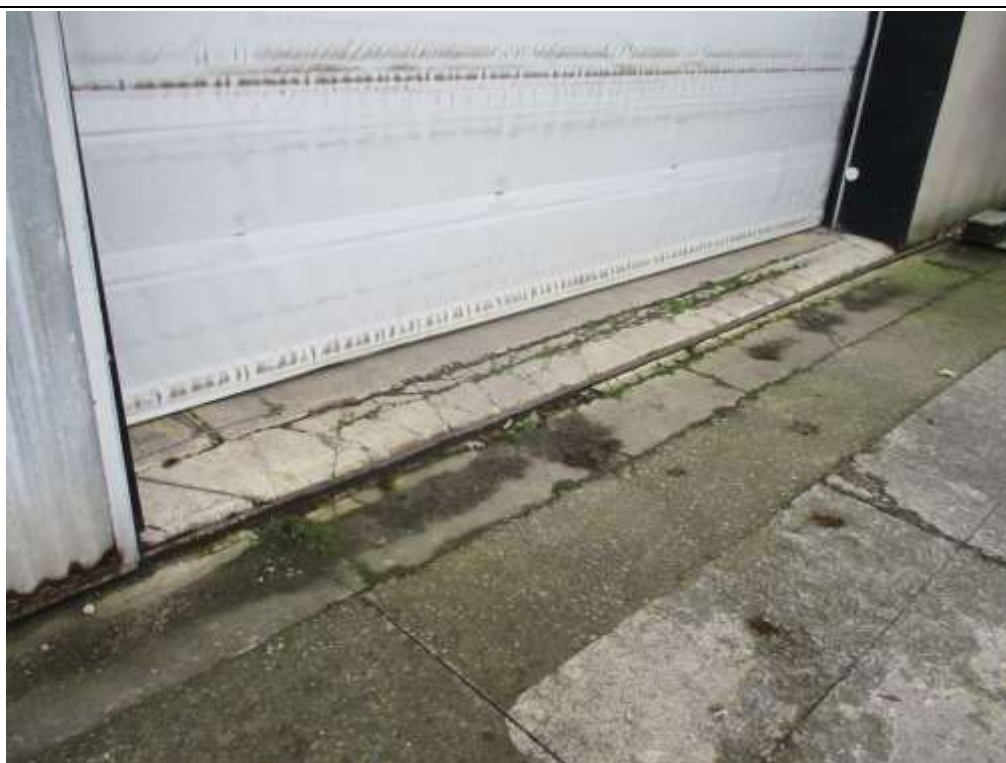
Photo n°3 : Eclats de béton - Porte d'accès côté Nord
