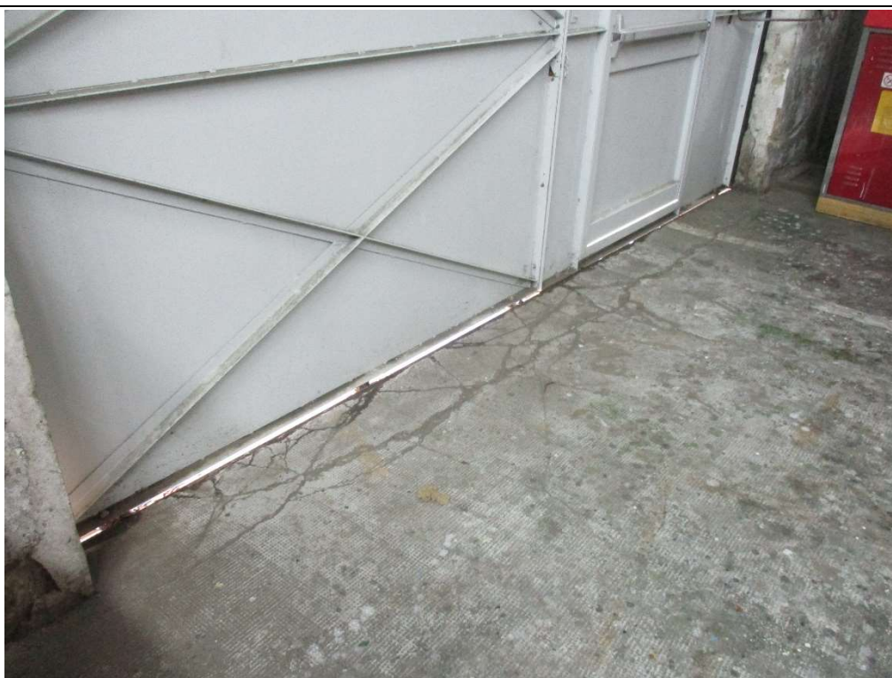
Photo n°10 : Eclats de béton - Local 025, seuil porte d'accès côté Ouest
