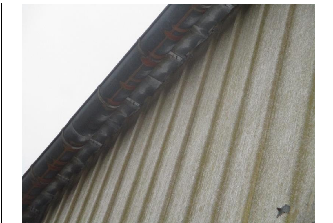
Photo n°24 : Enrouillement - Côté Ouest
