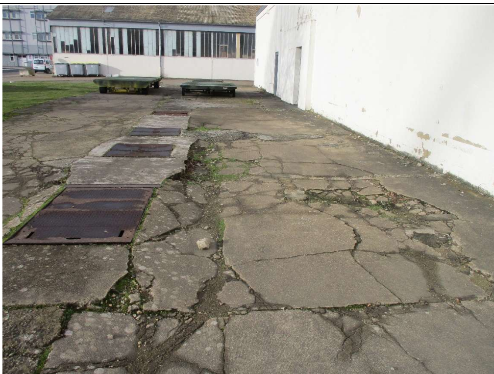
Photo n°2 : Flaches - Répartis sur l'ensemble des dallages
