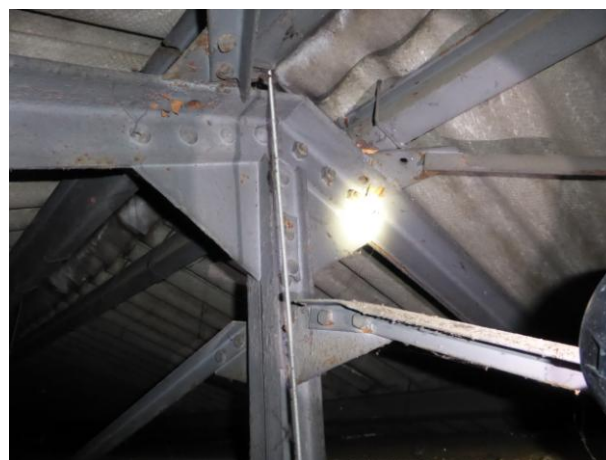
6 - Présence d'une poutre au vent au milieu du bâtiment.
