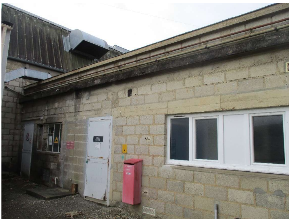
Photo n°6 : Eclats de béton avec mise à nu d'armatures - Locaux 019, 022, 023, sur corniche
