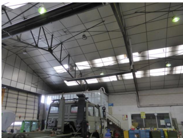
5 - Présence de bardage fibro-ciment au-dessus de la maçonnerie sur les pignons
