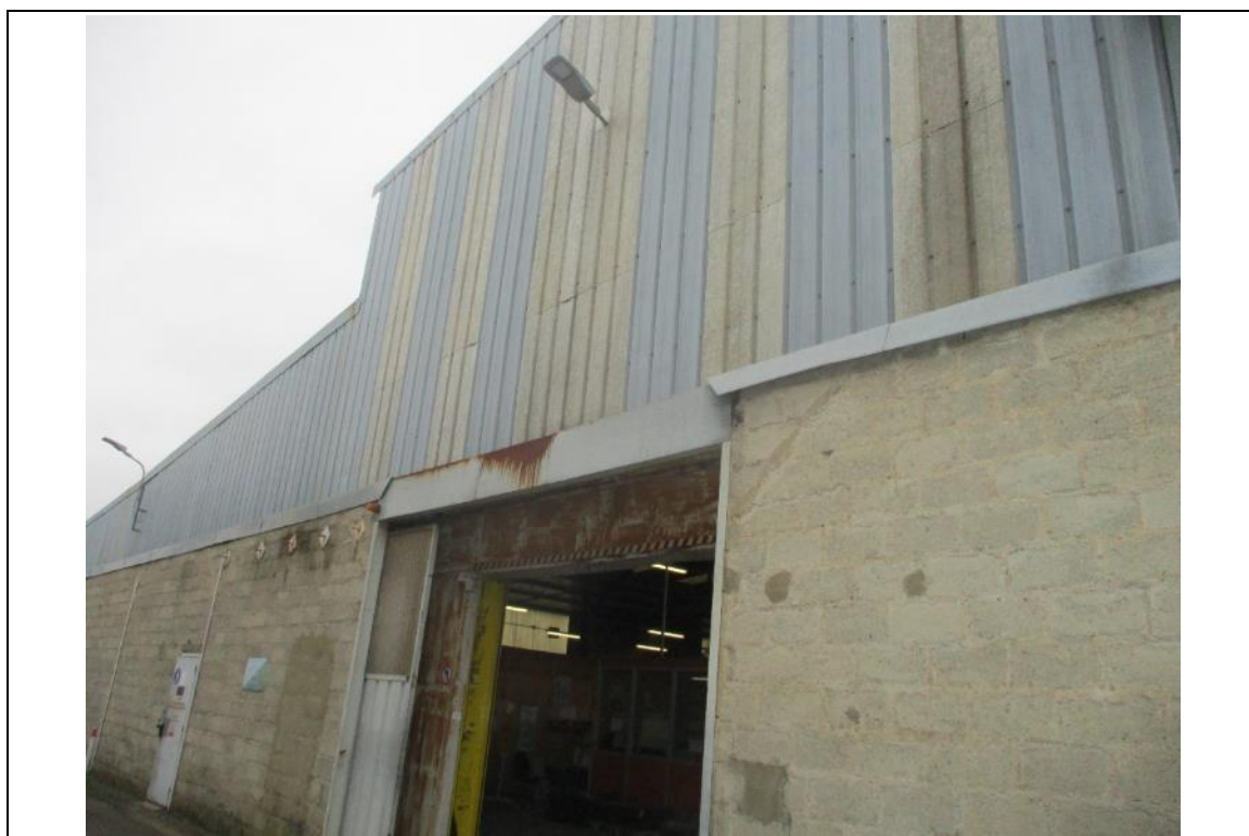
Photo n°27 : Enrouillement - Côté Sud, accès local 010
