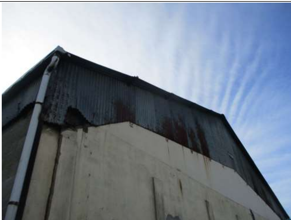
Photo n°3 : Défaut de fixation - Sur bardage côté Est
