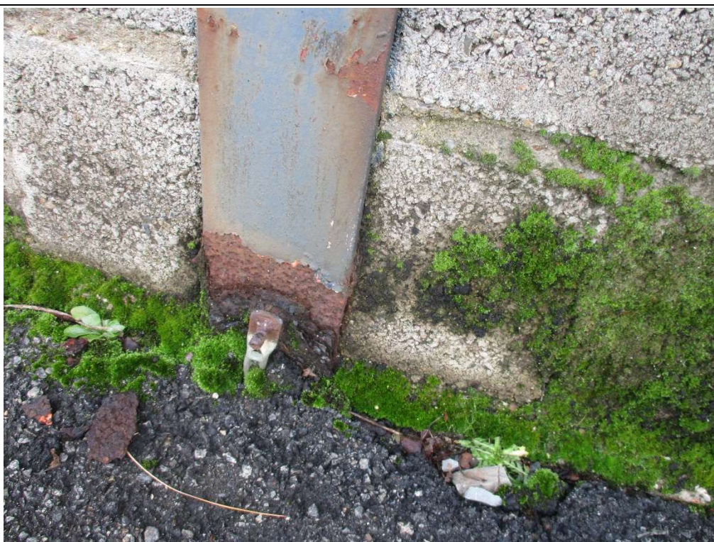
Photo n°3 : Corrosion feuilletante - En pied de poteau d'ossature métallique
