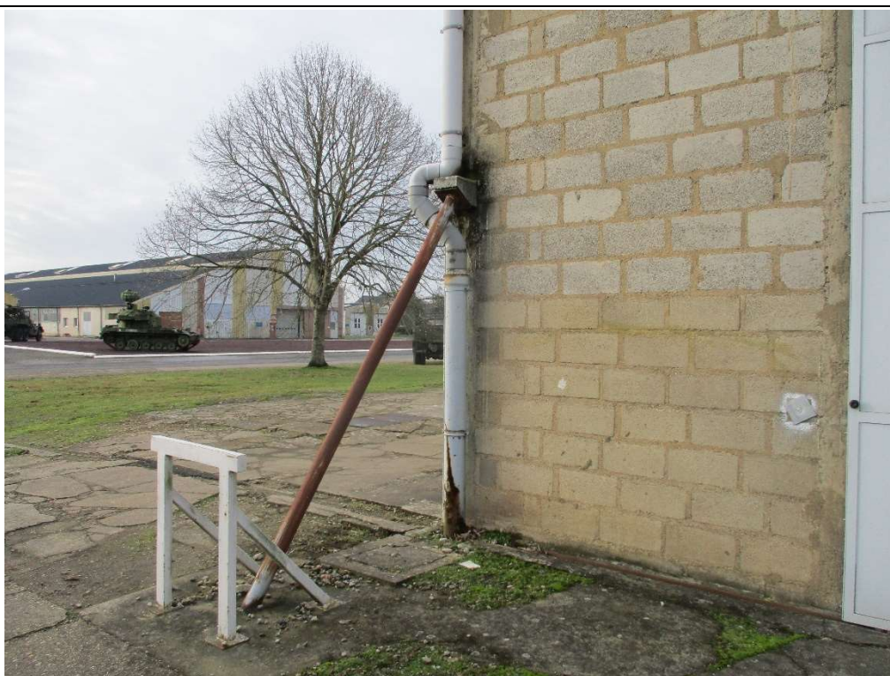
Photo n°7 : Enrouillement - Local 025, sur buton, angle Sud
