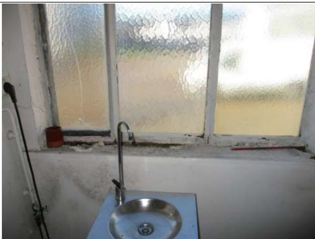
Photo n°13 : Corrosion feuilletante - Local 018, châssis fenêtre
