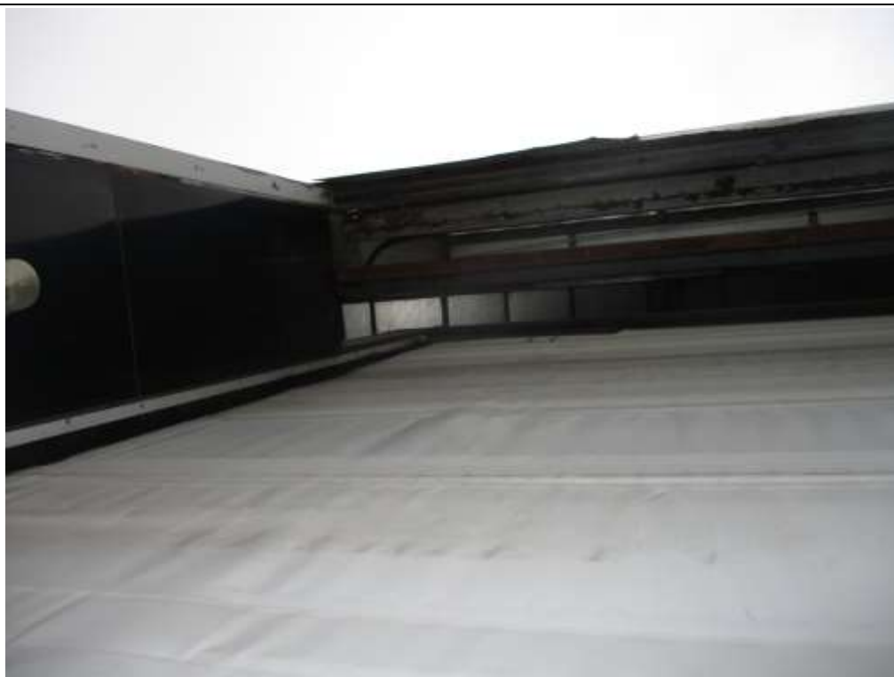
Photo n°12 : Défauts d'étanchéité - Ensemble des encadrements de portes sectionnelles
