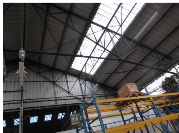
6 - Présence d'une poutre au vent à chaque extrémité du bâtiment.
