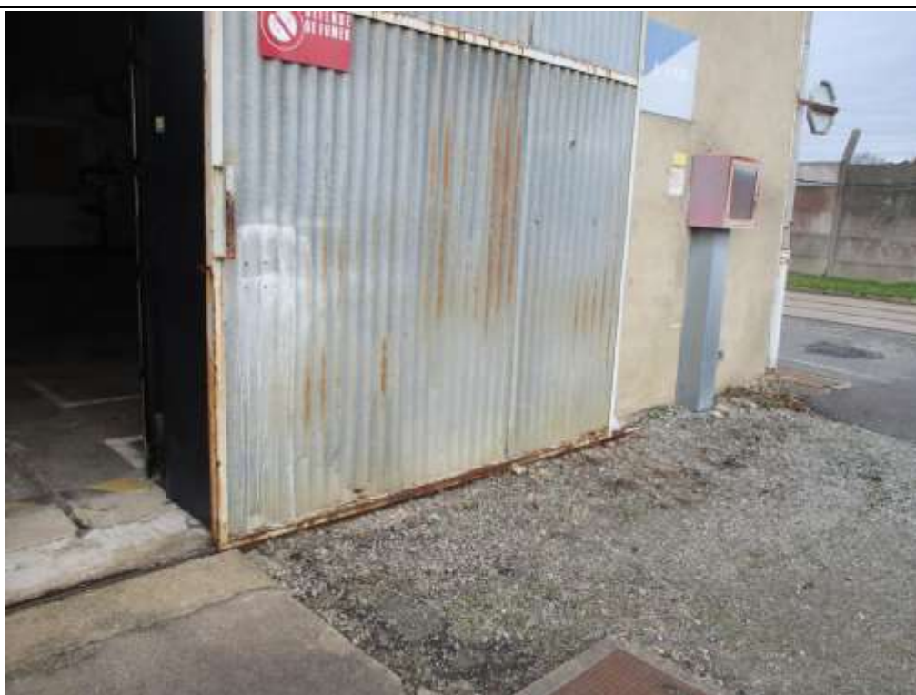
Photo n°10 : Corrosion feuilletante - En pied de portes coulissantes
