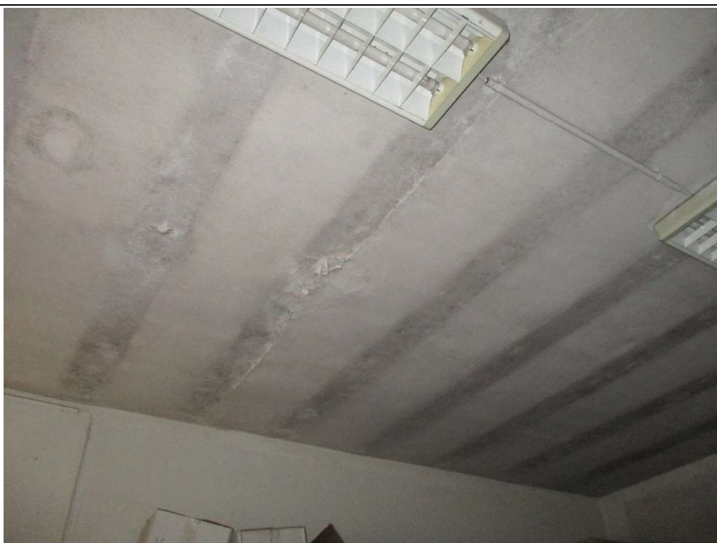
Photo n°15 : Décollement de revêtement - Local 021, au plafond
