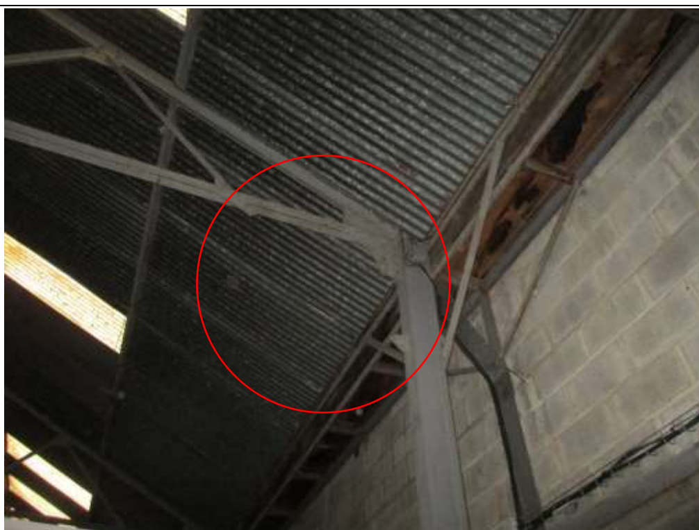
Photo n°6 : Désolidarisation d'élément - Local 014, côté Est, 3e poteau
