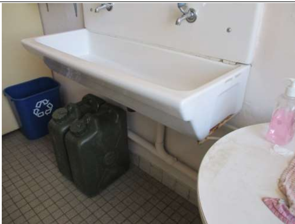
Photo n°20 : Enrouillement - Local 018, support de lavabo
