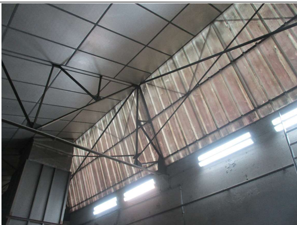
Photo n°11 : Salissures - Ensemble tôles ondulées translucides
