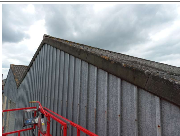
Prélèvement - P03 : Bâtiment 158 / Extérieur / Toiture - Plaque plane- (Présence d'amiante)
