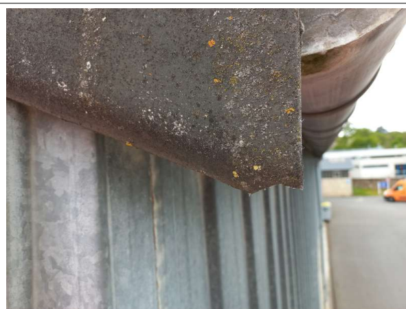
Prélèvement - P03 : Bâtiment 158 / Extérieur / Toiture - Plaque plane- (Présence d'amiante)
