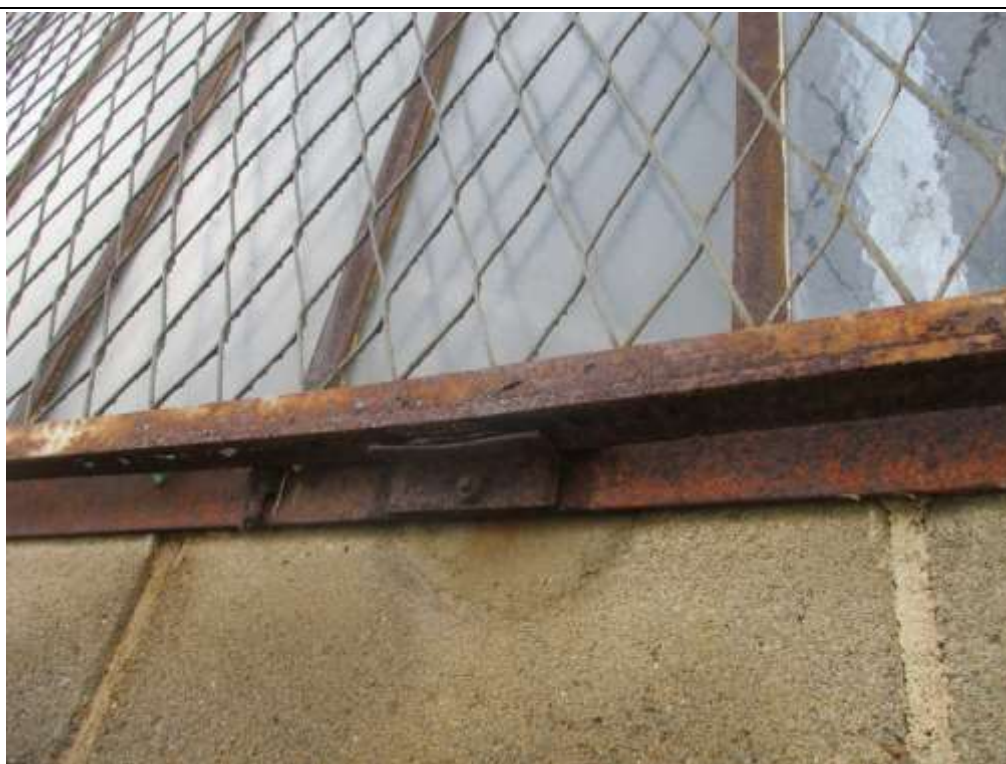
Photo n°14 : Corrosion avec perforation - Façade Est, ensemble des grilles anti-intrusion
