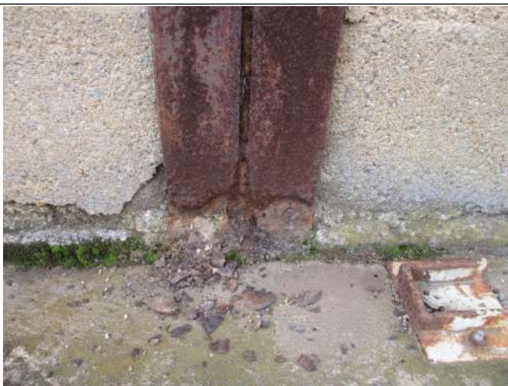
Photo n°6 : Corrosion avec perforation - En pied de poteaux d'ossature métallique
