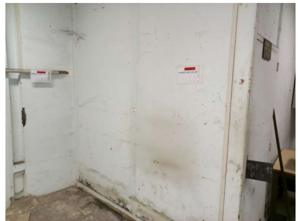
Prélèvement - P22 : Bâtiment 158 / Rez de chaussée / Local 014 - Panneau de cloison- (Présence d'amiante)
