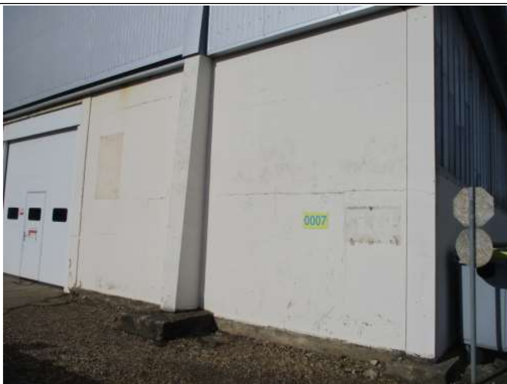
Photo n°5 : Fissures horizontales - Voile maçonné, à mi-hauteur et en tête
