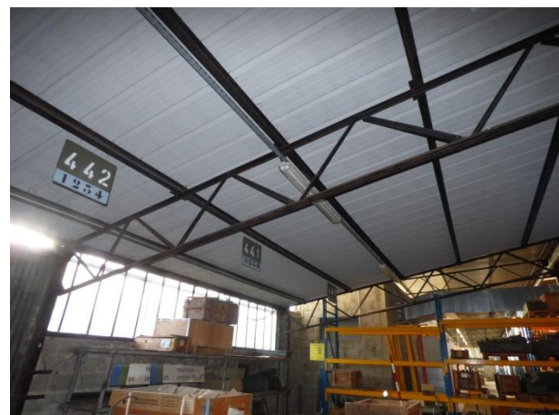
6 - Présence d'une poutre au vent à chaque extrémité du bâtiment.
