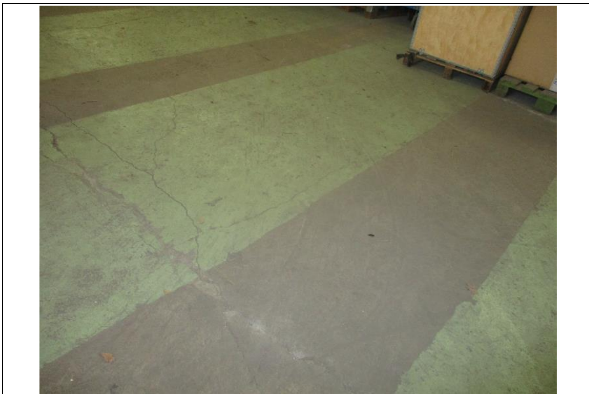
Photo n°13 : Maillage irrégulier de fissures - Local 020, réparties sur l'ensemble du dallage
