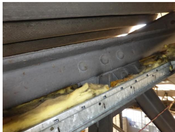
6 - Présence d'une poutre au vent au milieu du bâtiment.
