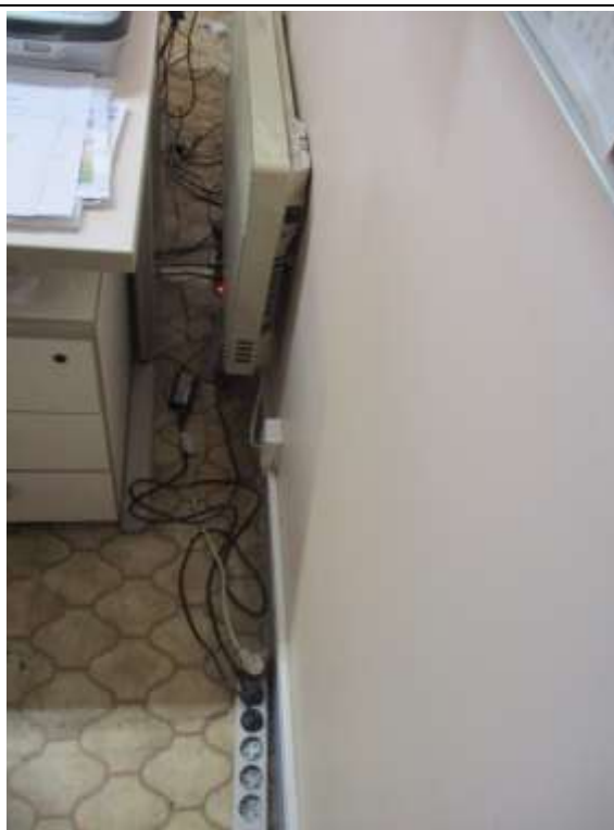
Photo n°19 : Défauts de raccordements - Locaux 016, 017
