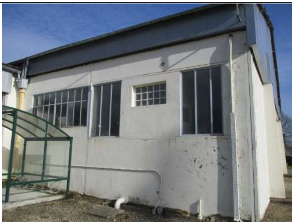
Photo n°8 : Réseau de fissures - Voile maçonné, côté Sud
