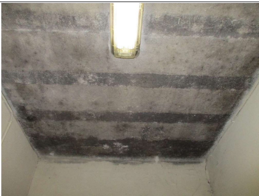
Photo n°16 : Traces d'humidité - Local 022, sous-face de dalle
