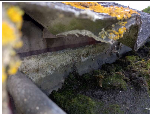
Prélèvement - P04 : Bâtiment 158 / Extérieur / Toiture - Plaque ondulée- (Présence d'amiante)
