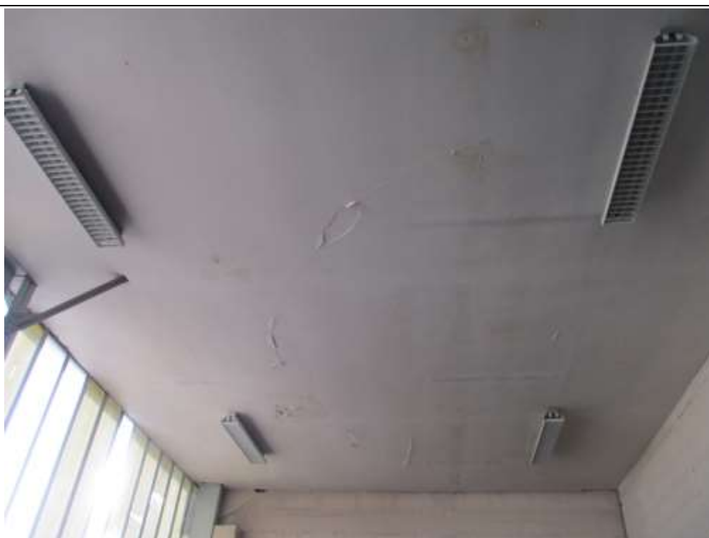
Photo n°18 : Décollement de revêtement - Locaux 011 & 015, plafond plâtre sur lattis bois
