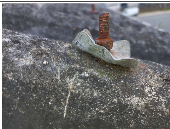
Prélèvement - P05 : Bâtiment 158 / Extérieur / Toiture - Couver-joint- (Présence d'amiante)
