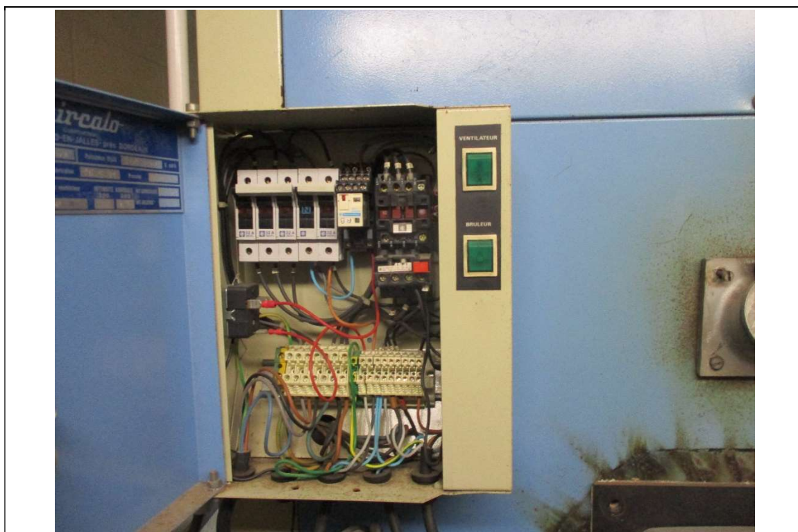
Photo n°17 : Défaut de fermeture - Local 013, sur chaudière
