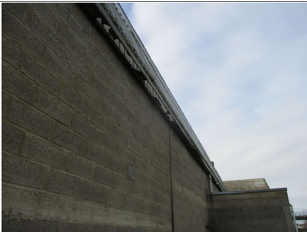
Photo n°13 : Corrosion avec perforation - Local 015, côté Nord
