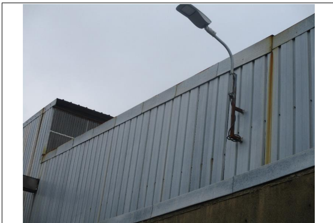
Photo n°19 : Enrouillement - Arêtier côté Sud
