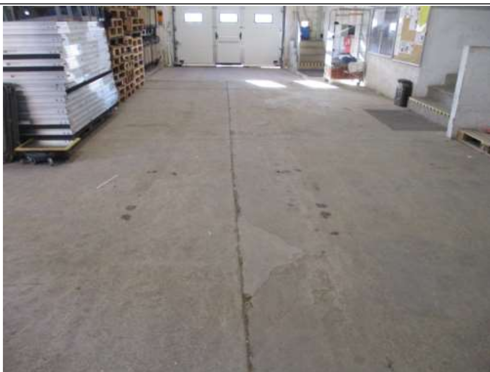
Photo n°10 : Epaufiture du béton - Réparties sur le dallage
