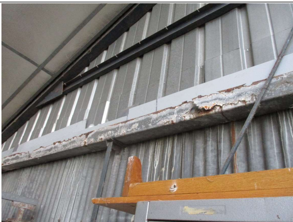
Photo n°12 : Corrosion avec perforation - Local 015, côté Ouest
