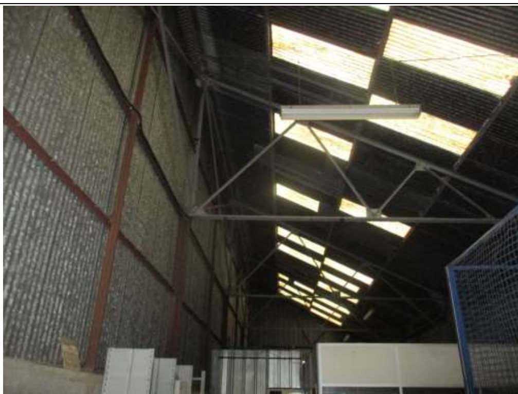
Photo n°11 : Enrouillement - Ossature métallique cloison centrale
