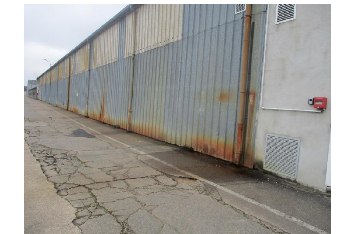
Photo n°9 : Enrouillement - Réparti sur toute la longueur
