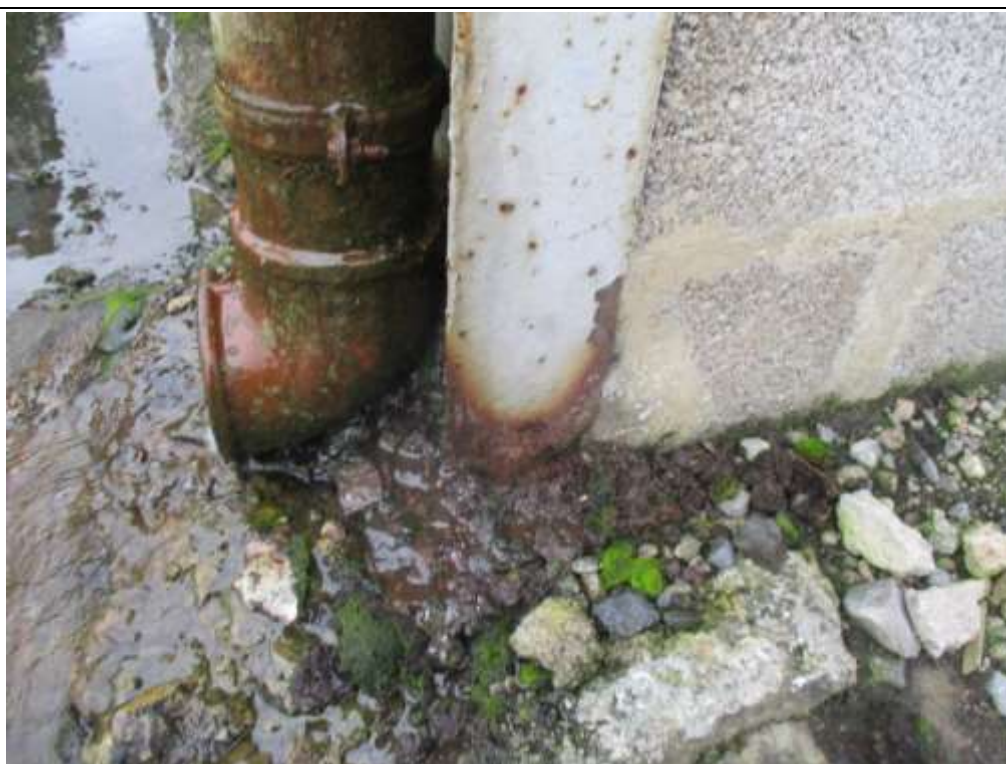
Photo n°4 : Corrosion feuilletante - Poteau arête côté Ouest
