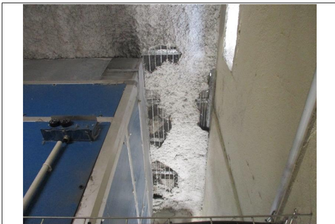
Photo n°32 : Eclats de revêtement - Local 018, chaufferie 162H
