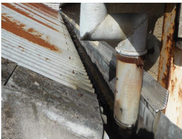
5 – Vue extérieure Chéneau récoltant les eaux du bâtiment 028
