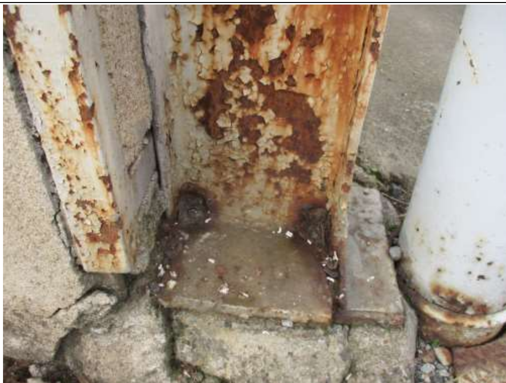
Photo n°6 : Corrosion feuilletante - En pied de poteau côté Est
