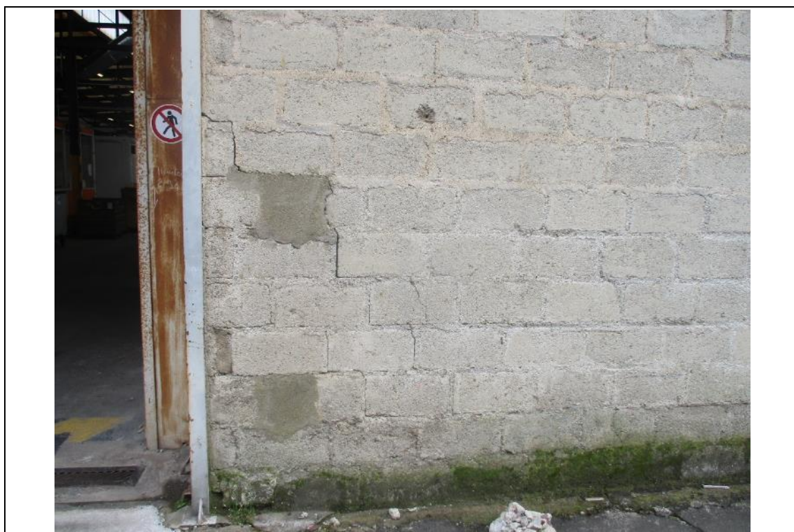
Photo n°5 : Fissures obliques - Au droit accès local 010
