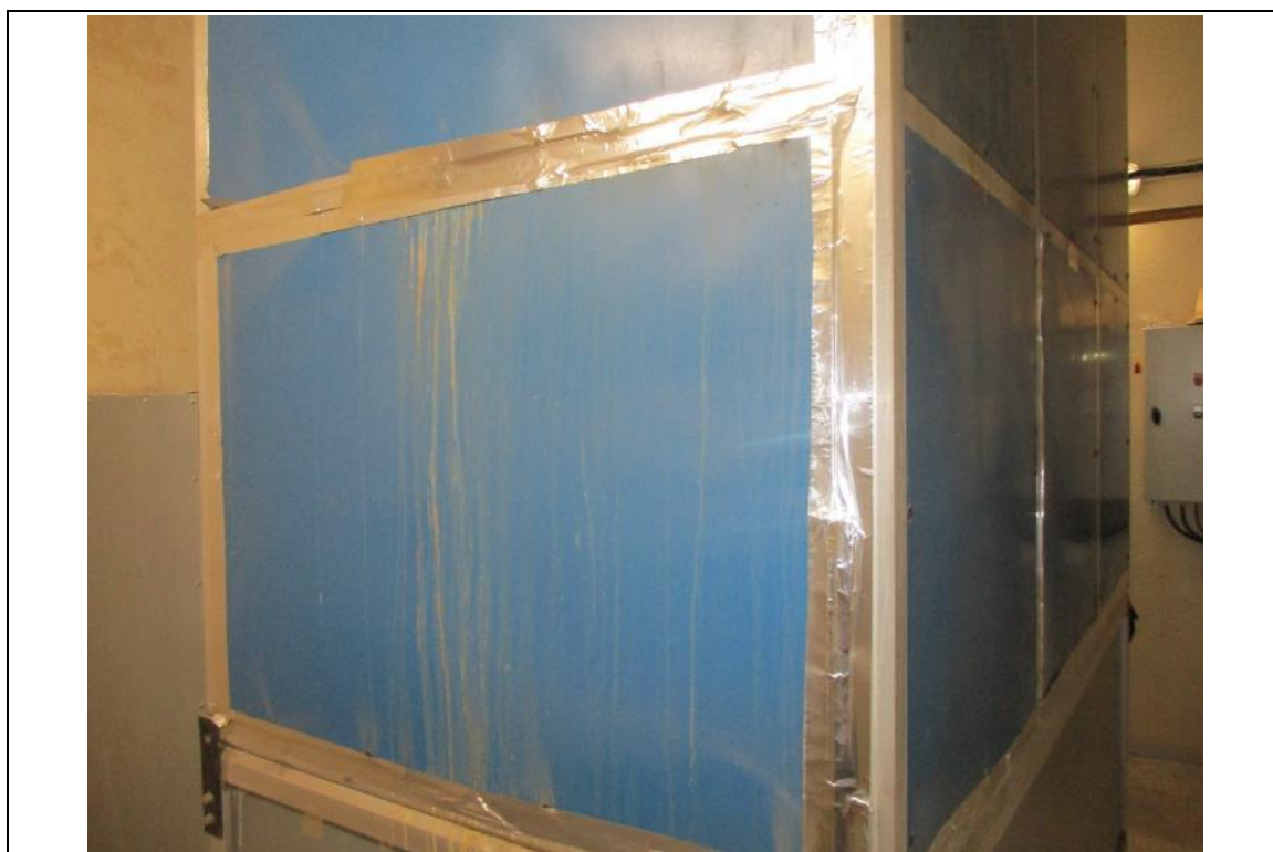
Photo n°38 : Traces de coulures - Local 012, chaufferie 162G
