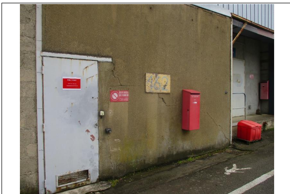
Photo n°6 : Fractures obliques - Au droit des locaux 015 et 021
