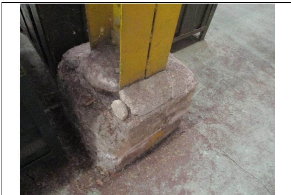
Photo n°18 : Epaufrement du béton - Local 020, B15
