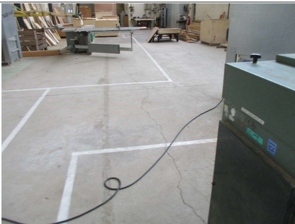
Photo n°9 : Fissures - Local 015, réparties sur le dallage
