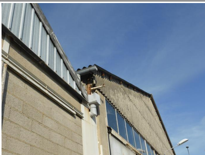
5 - Présence de bardage fibro-ciment au-dessus de la maçonnerie sur les pignons
