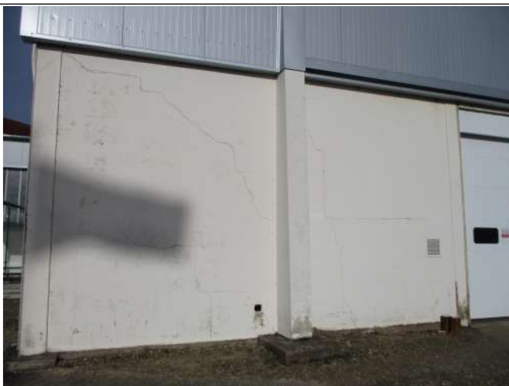
Photo n°4 : Fractures obliques - Voile maçonné, côté Ouest
