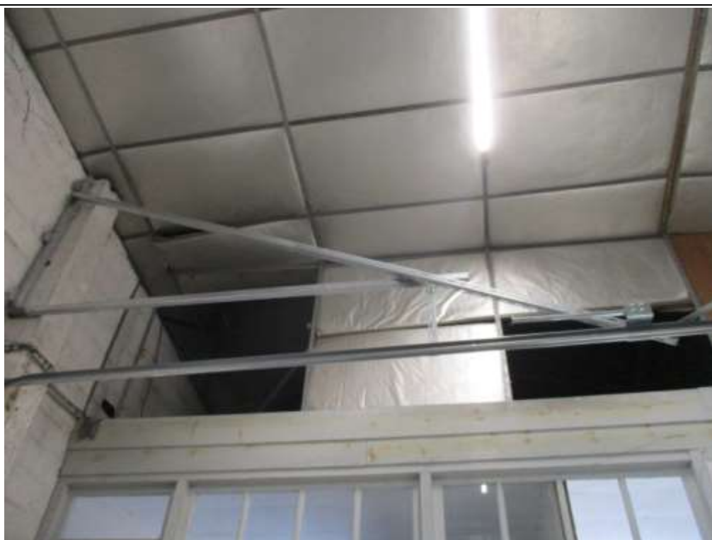
Photo n°15 : Désolidarisation d'éléments - Local 010, panneau d'isolant à proximité du local 018
