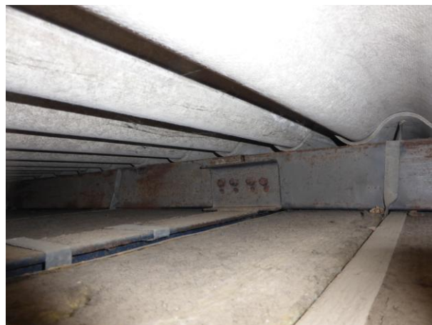
6 - Présence d'une poutre au vent à chaque extrémité du bâtiment sur shed.
