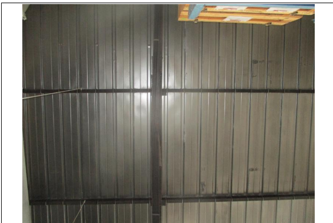
Photo n°14 : Déformation d'élément - Local 010, entre E7 et F7
