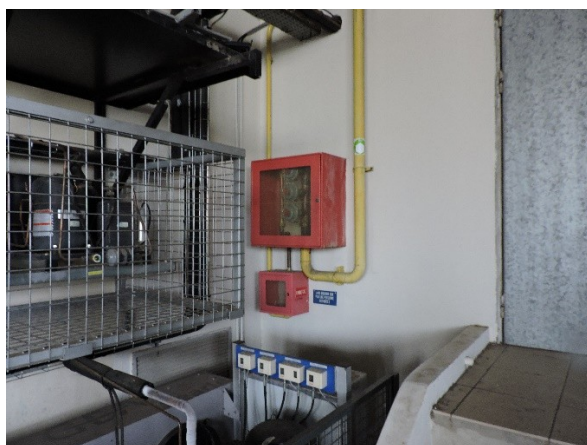
Vanne de sécurité et coffret de détente à déplacer
